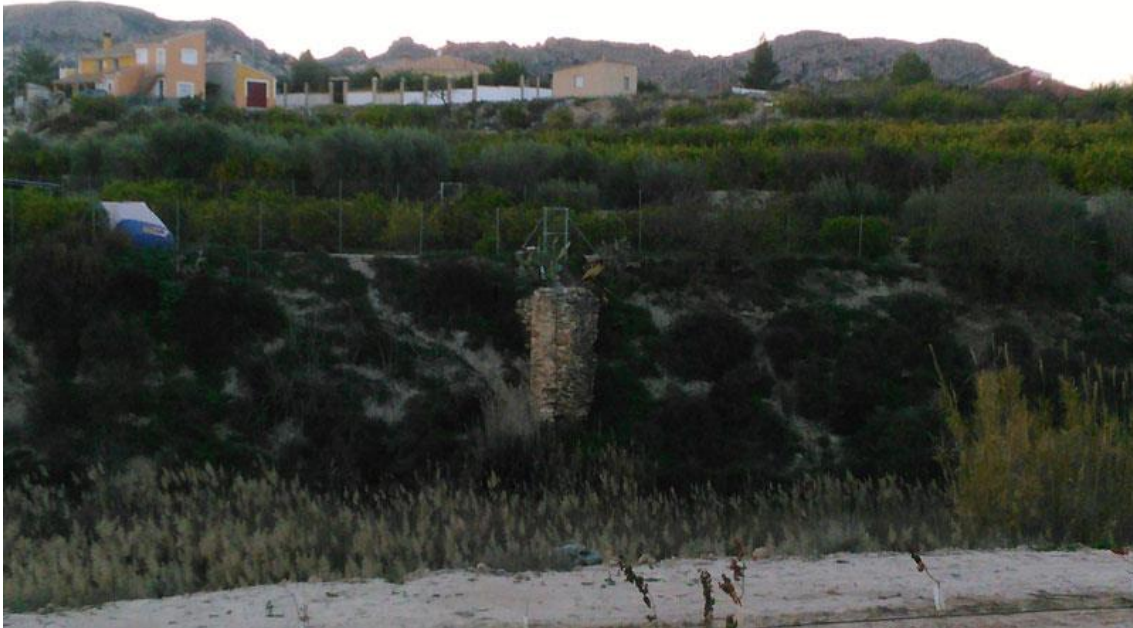
Ilustración 05. Restos del antiguo azud que servía para retener las aguas del río Mula, y aprovecharlas, mediante una conducción, en el regadío de La Puebla de Mula. Estas aguas se unían a las sobrantes del regadío de Mula, recogidas mediante el Azarbe de los poblanos . Fuente: Elaboración propia.
