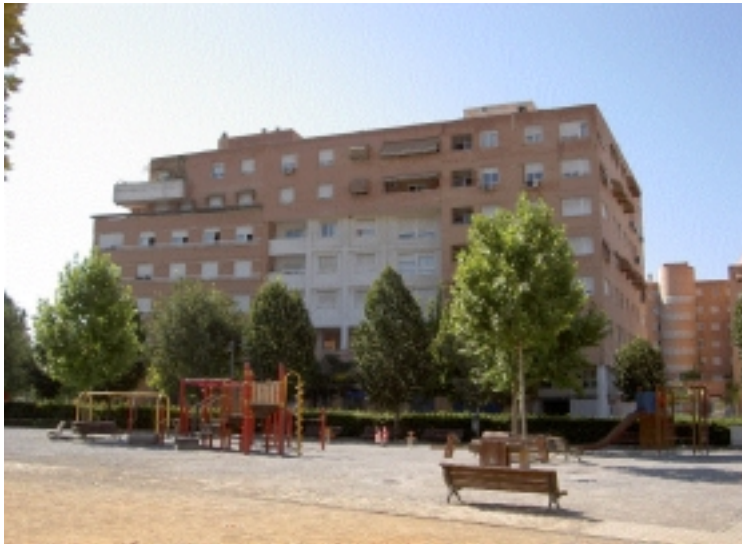
Edificio de viviendas con urbanización cerrada semejante al lugar en el que viven los entrevistados
