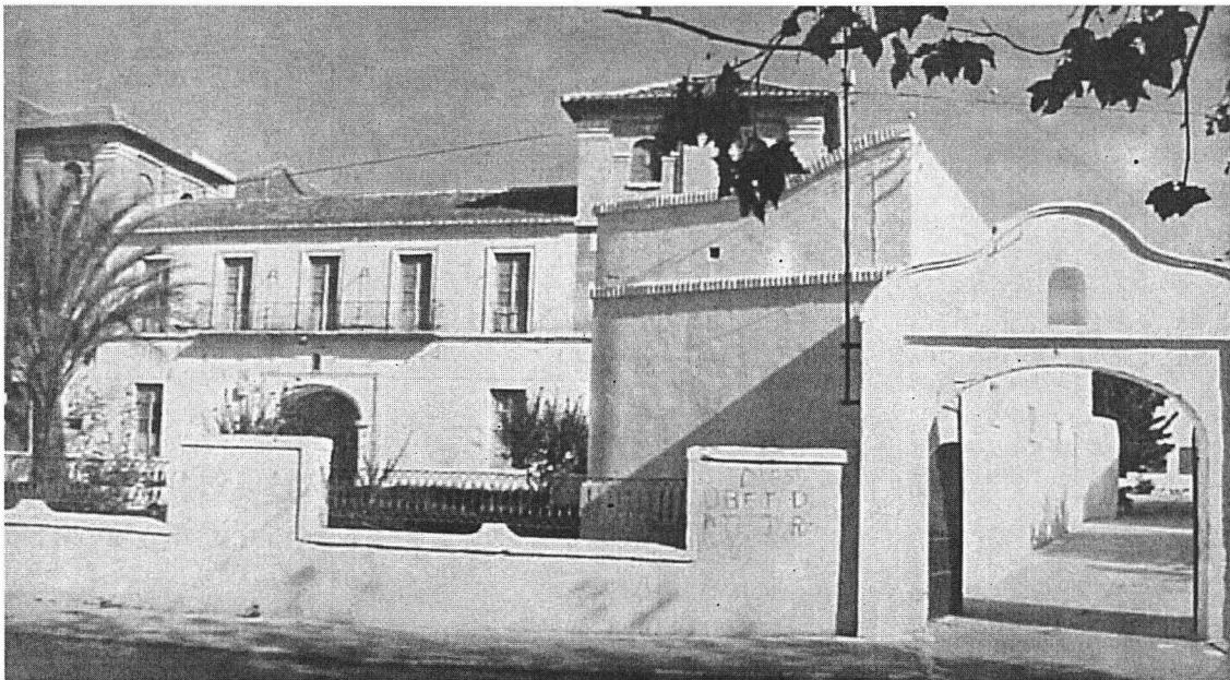
Ilustración n os 16 y 17.- Arriba: Informe sobre los destrozos ocasionados en los conventos de San Francisco y Capuchinos por las tropas francesas. (Archivo Municipal de Motril, leg. 317, pza. 26) Abajo: Fachada y accesos del convento de Capuchinos en Motril (Archivo Municipal de Motril-Foto Peña)
