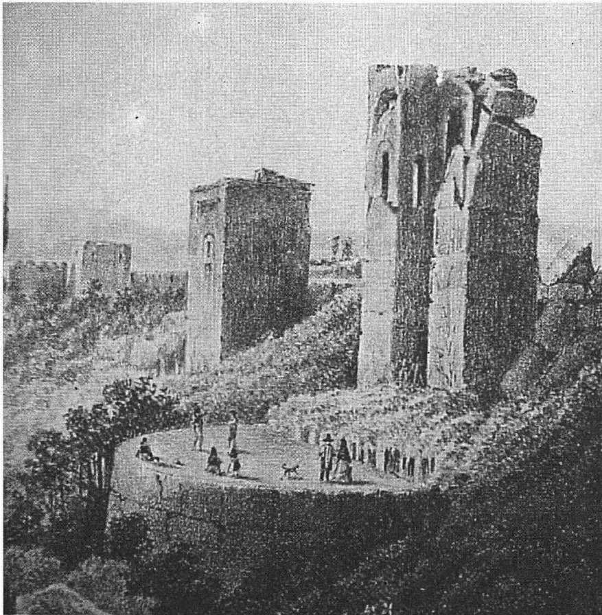
Ilustración nº 1.- Estado en que quedaron algunas torres y muros de La Alhambra tras su abandono e intento de destrucción por parte de los franceses. (Archivo personal)
