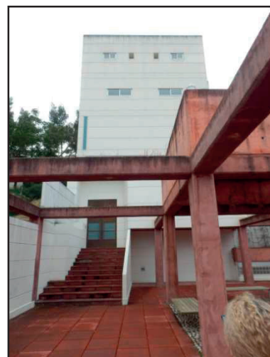
Edificio Anexo, vista desde el Ágora
