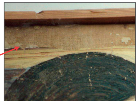
Manchas producidas por chorreones de agua
