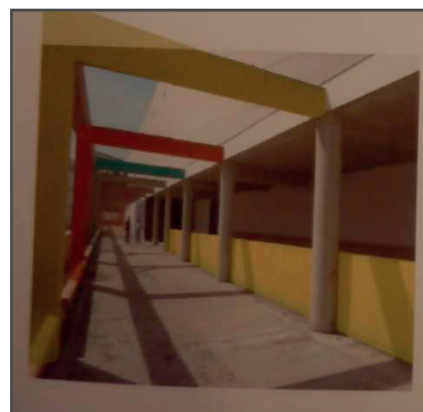
Stoa del edificio que da acceso al ágora
