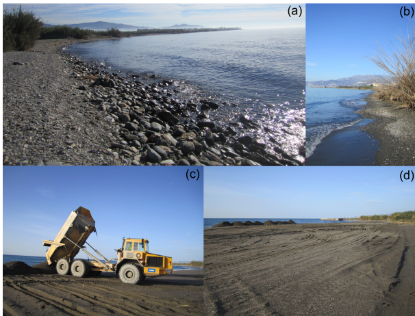
Figura 7: Regeneración del delta en 2014: Vistas Oeste-Este (a) y Este-Oeste (b) de la playa antes de la regeneración, (c) aporte de sedimentos y (d) situación de la playa en la fase final de los trabajos, con la desembocadura al fondo.
