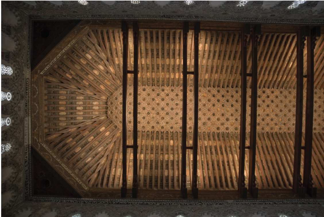
Fig. 110. Artesonado de la sala de oración de la Sinagoga del Tránsito con decoración de estrellas (foto: Daniel Muñoz Garrido).
