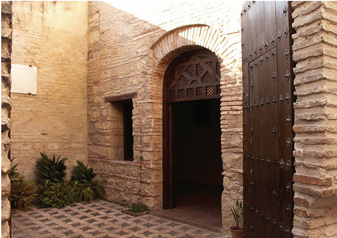
Fig. 22. Patio y entrada de la Sinagoga de Córdoba (foto: Daniel Muñoz Garrido).
