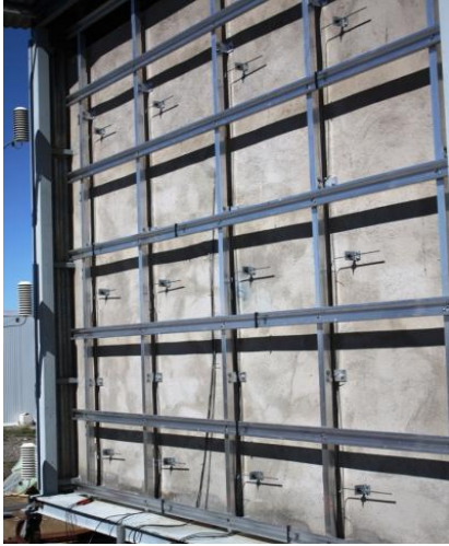
Figura 4.4.- Vista de la fase intermedia de construcción: Estructura metálica
