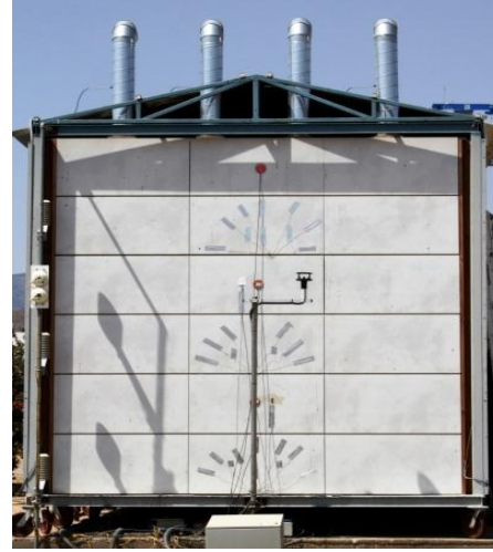
Figura 4.5.- Vista exterior de la fachada ventilada
