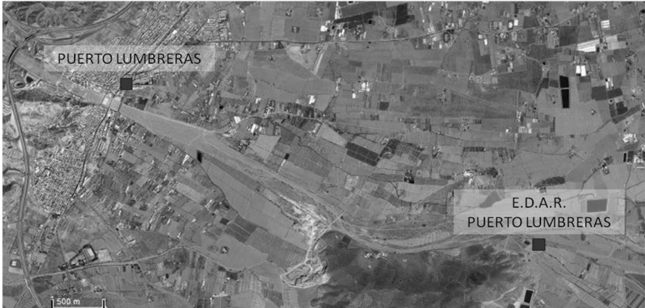
Figura 14. Foto aérea de la situación de la Estación Depuradora de Aguas Residuales (EDAR) de Puerto Lumbreras en la cual se desarrolló la segunda fase de la investigación de choque
