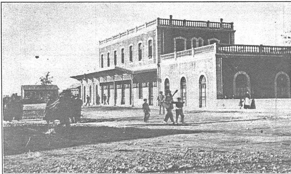
Construcción de la Estación de Ferrocarril.
