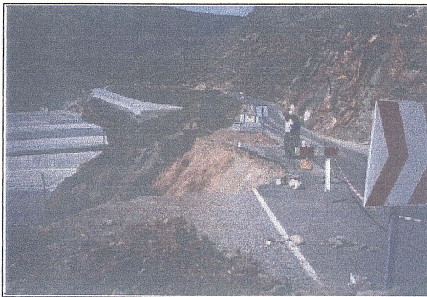
Carretera C-333, p.k. 58+200.
