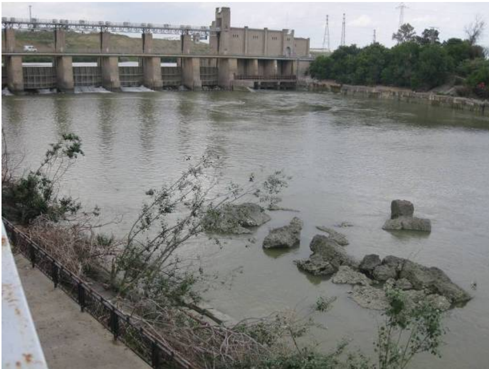
Figura 1.2: Presa de Alcalá del Río (Sevilla).
