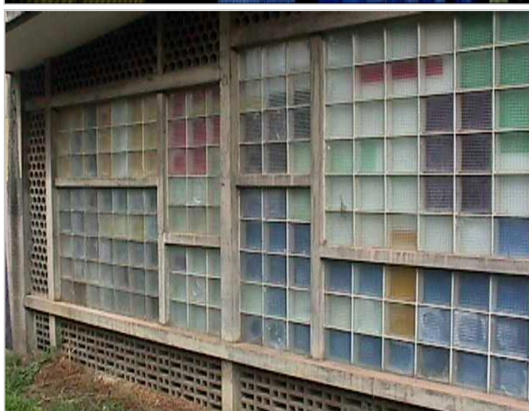
80. "Sin Título". Policromía. (1956) Vitrail. Bloques de vidrio pintados con óxidos estructura de hormigón y muro calado. 502.5 x 997 cm. Auditorio. Antigua Escuela de Enfermeras. Actualmente aula de clase
