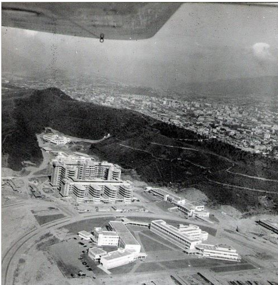
Vista aérea de la Ciudad Universitaria de Caracas, donde se valora la construcción de las primeras edificaciones destinada para la atención médica. Foto Leo Matiz En: AA.VV. (2001) Ciudad Universitaria de Caracas Patrimonio Mundial. Fotografías: Olga Lucía Jordan, Carlos Beltrán. Caracas, Soledad Mendoza Editora. p. 25
