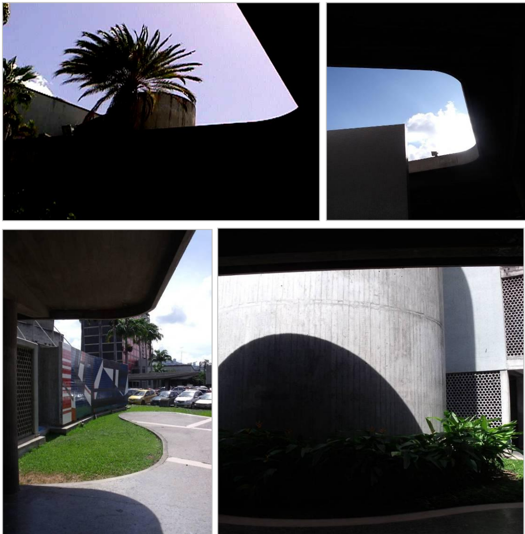
Efectos visuales propiciados por las luces y las sombras entre los diversos techos cubiertos de la Plaza Cubierta del Rectorado, en la Ciudad Universitaria de Caracas. Foto. Juan Pérez Hernández.
