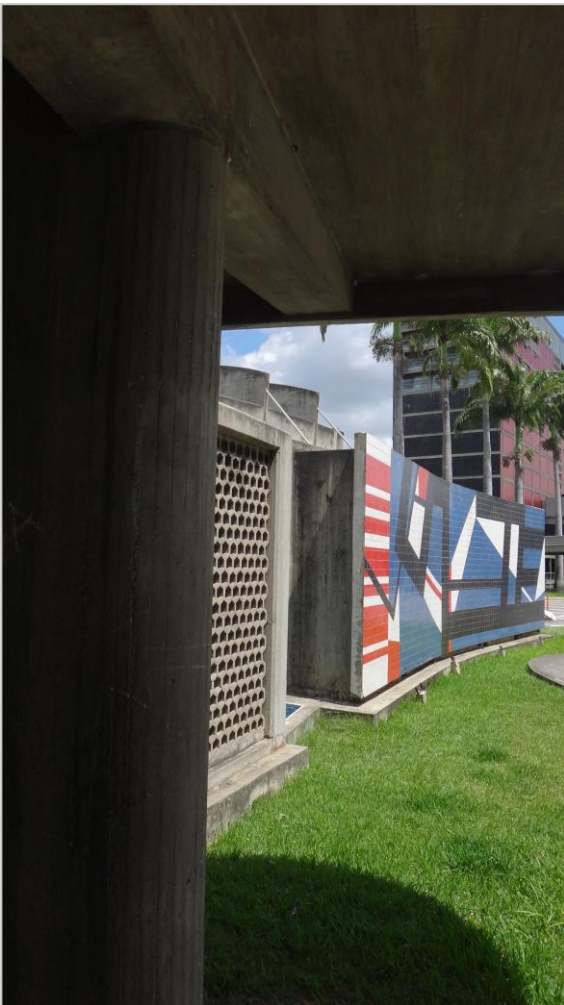
(2) 302.5 x 1162 cm. Parte posterior de la obra Zona externa Plaza Cubierta del Rectorado. Ejecutado por la firma Llamart. Reconstruido, por Cerámicas Carabobo.
