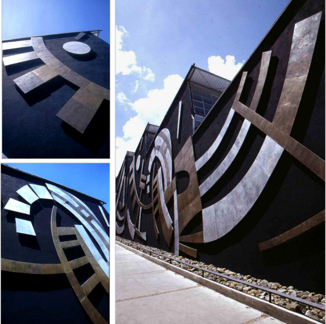
33. "Sin Título" (1955). Mural en Relieve. Planchas en metales pulidos (Cobre y aluminio) y friso especial (texturado) 1102 x 4037 cm. Edificio del Facultad de Ciencias. Fachada este edificio de talleres. Laboratorios Docentes y Biblioteca. (Antigua Escuela Técnica Industrial)
