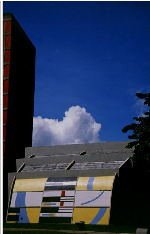
51. "Sin Título" (1954) Reconstruido (1985) Mural. Cerámica esmaltada. 640 x 1465 cm. Edificio Sala de Conciertos. Fachada este. Ejecutado por la firma Llamart. Reconstruido, por Cerámicas Carabobo.
