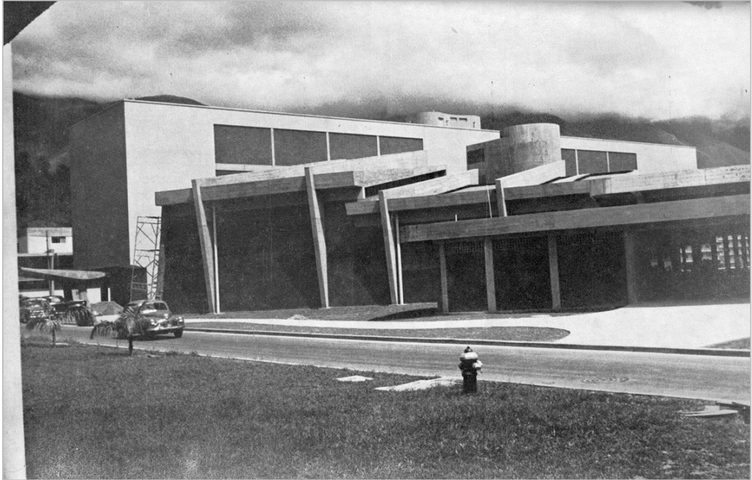
Se valora el cuerpo de andamios preparados durante el proceso de ejecución de la obra del artista Mateo Manaure, para el Edificio Paraninfo – Ciudad Universitaria de Caracas. En: República de Venezuela. Memoria y Cuenta del Ministerio de Obras Públicas, 1954. Caracas, Dirección de Cartografía Nacional M.O.P, 1954, p. 99
