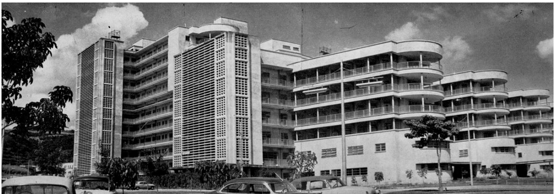
Aspecto exterior del Hospital Clínico, aun sin las Fachadas Policromadas de Mateo Manaure. En: República de Venezuela. Memoria y Cuenta del Ministerio de Obras Públicas, 1954. Caracas, Dirección de Cartografía Nacional M.O.P, 1954, p. 157
