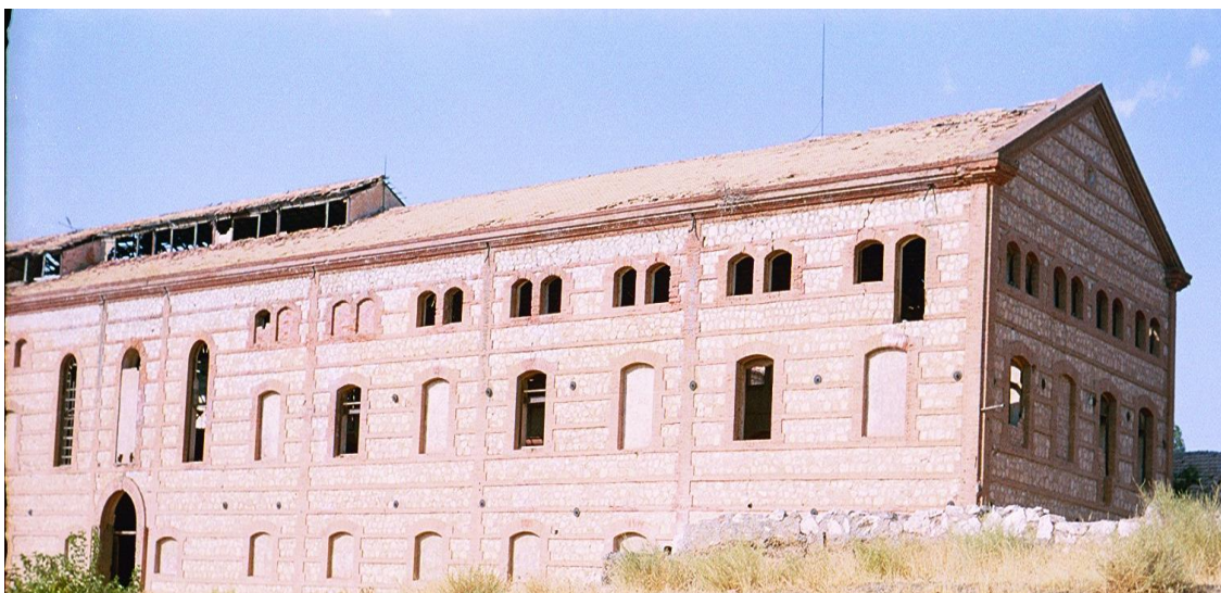
Fig. 83. Fotografía de la cubierta del Cuerpo de fábrica de la azucarera San Torcuato (Guadix)
