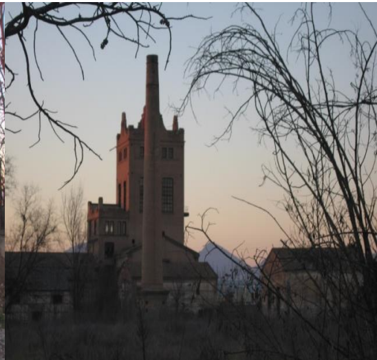
Fig. 327. Foto de la chimenea de la destilería
