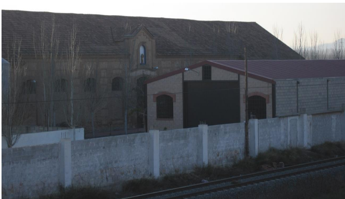
Fig. 366. Foto del recinto cercado que acoge parte del antiguo Cuerpo de fábrica y de las nuevas instalaciones frente al mismo
