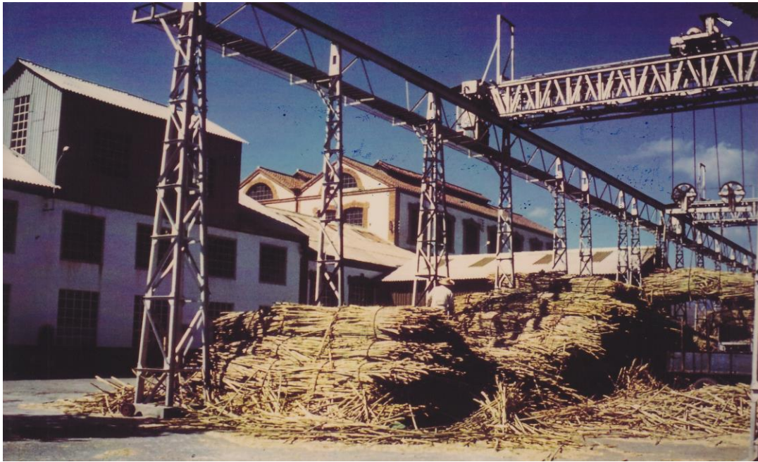
Fig. 233. Foto del puente grúa. Campaña del año 1967 en Torre del Mar. Fuente: ASAL
