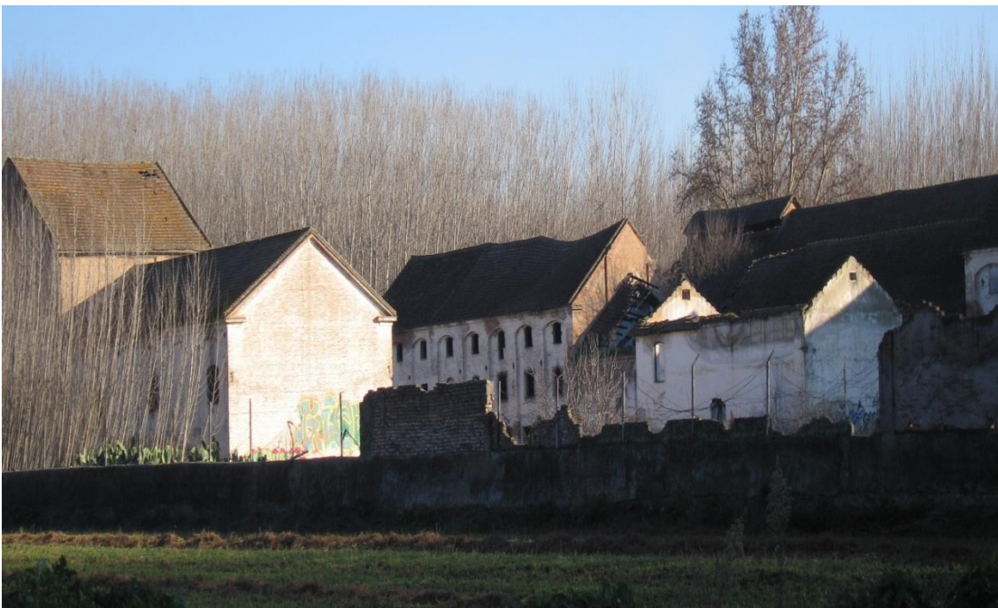
Fig. 411 y 412. Dos fotos del estado actual de las construcciones fabriles
