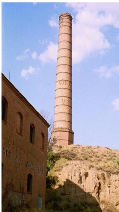
Fig. 590. La chimenea de la fábrica
