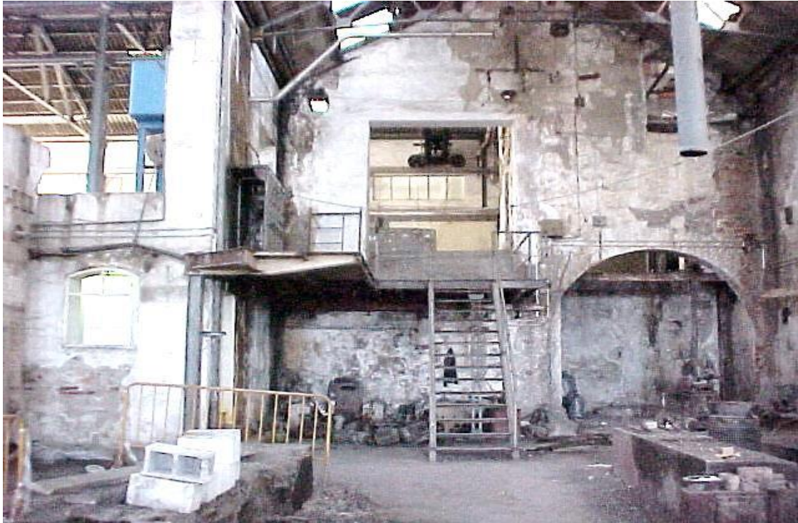
Fig. 522. Foto del espacio interior del gran salón del Cuerpo de fábrica. Fuente: ASGAE
