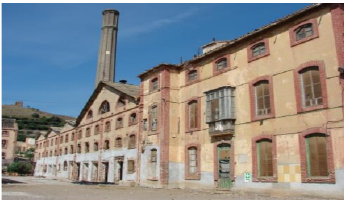
Fig. 477. Foto de la casa de dirección, naves del Cuerpo de fábrica y chimenea de la azucarera Ntra. Sra. del Pilar. Antes de la rehabilitación
