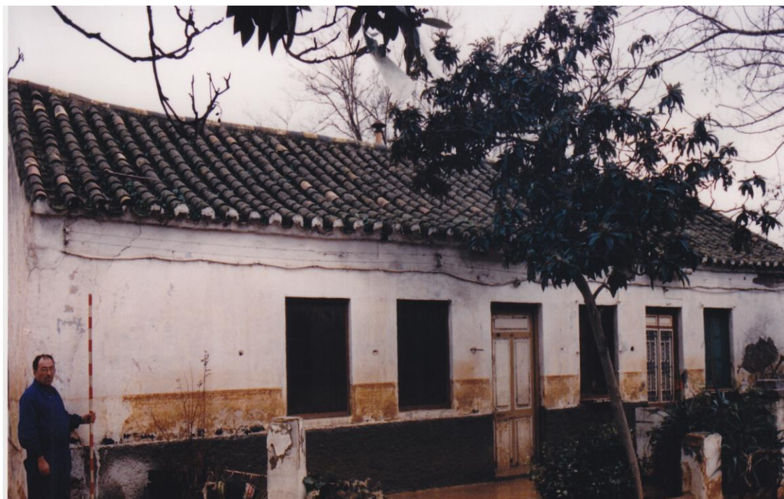
Fig. 200. Fotografía de las viviendas de la barriada obrera de Hispania. Inundaciones de los años setenta.
