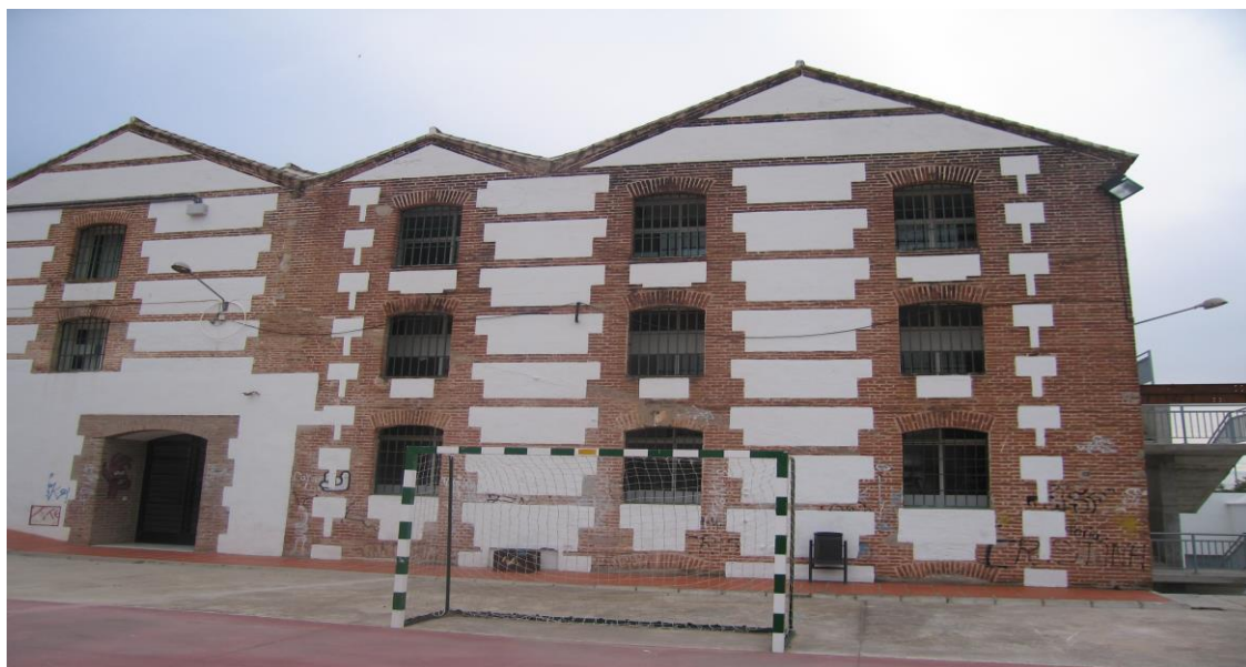
Fig. 224. Foto de las naves de la fábrica de San José rehabilitadas convertidas en gimnasio del centro escolar IES Chaparil
