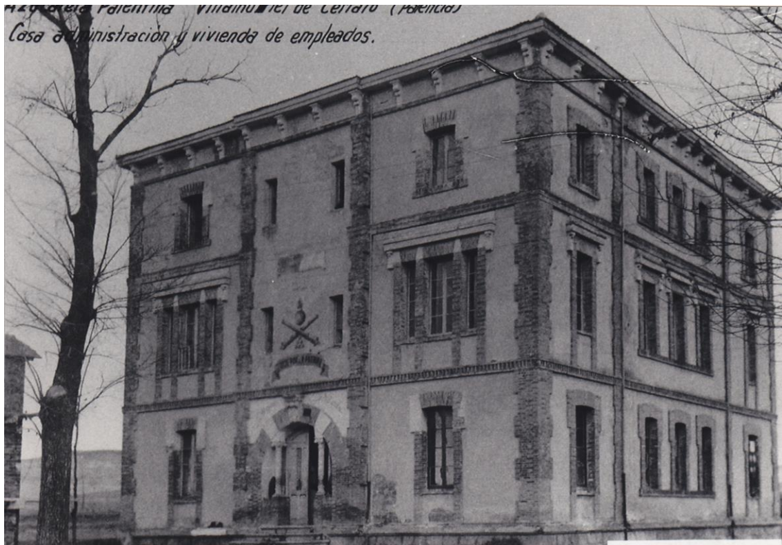
Fig. 108. Fotografía de la casa de administración y viviendas de empleados en la Azucarera palentina en la localidad de Villamuriel de Cerrato (Palencia). Fuente: SGAE. Benavente
