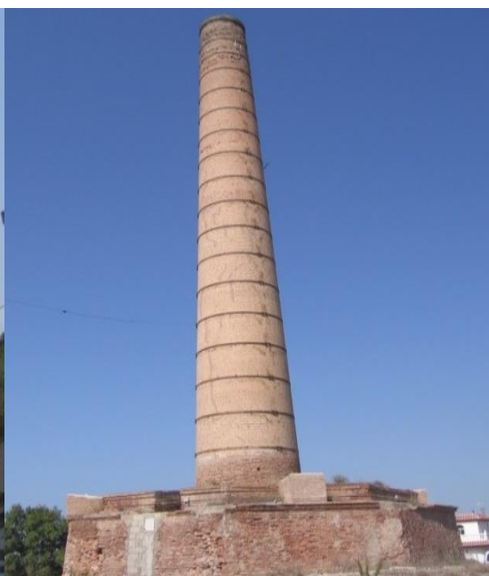
Fig. 448. Foto del estado actual de la chimenea
