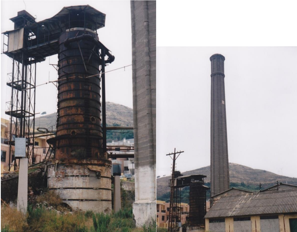
Figs. 467 y 468. Foto de la calera procedente de Láchar que se instaló en 1929 y la chimenea construida el año 1930 de Ntra. Sra. del Pilar (Motril)
