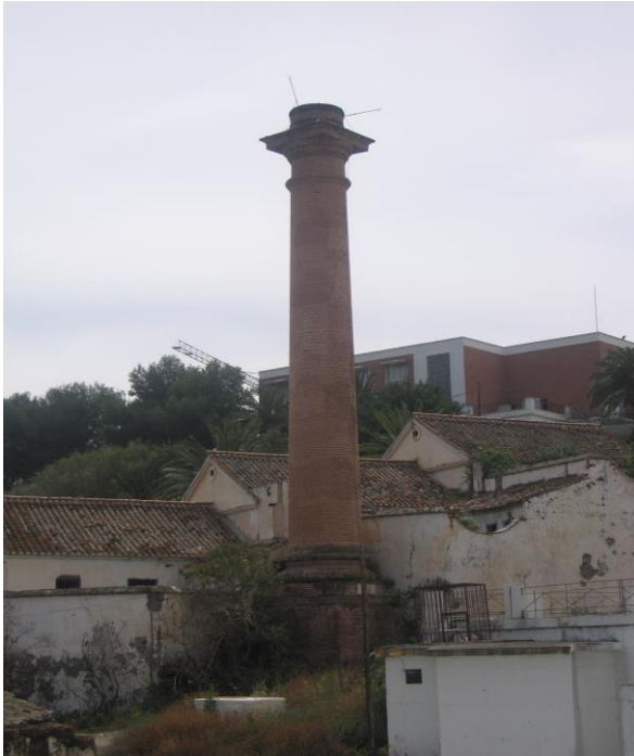
Fig. 251. La chimenea de la azucarera
