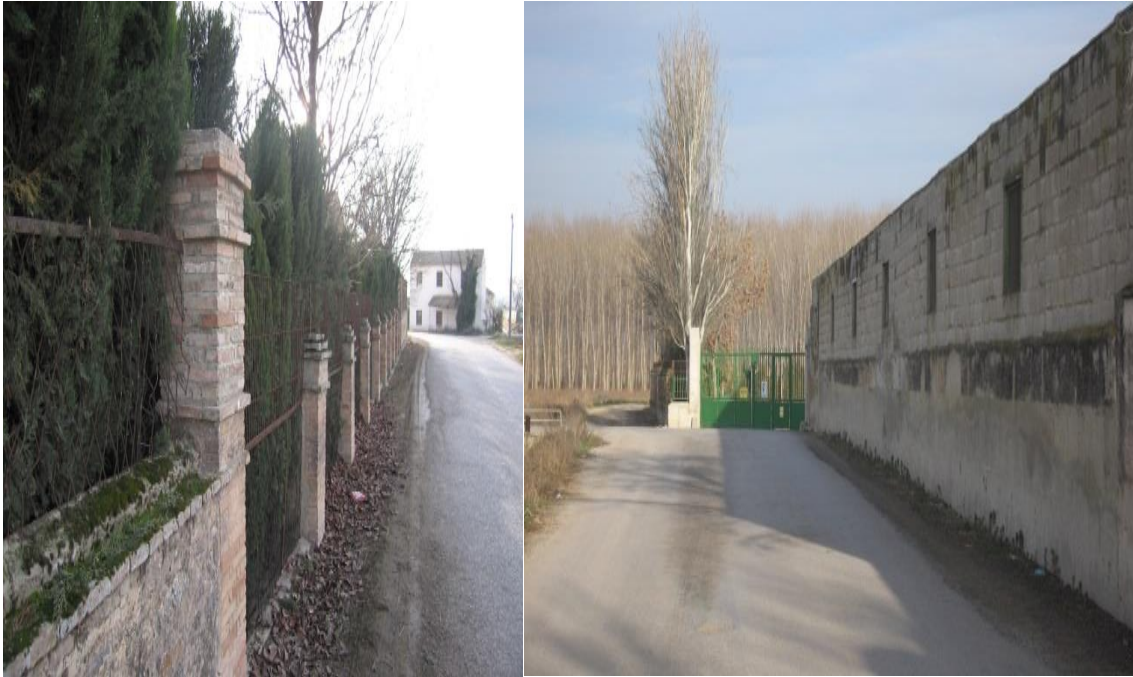
Fig. 418 y 419. Dos fotografías de la verja y cerca que rodean en la actualidad a las antiguas construcciones de la azucarera San Pascual
