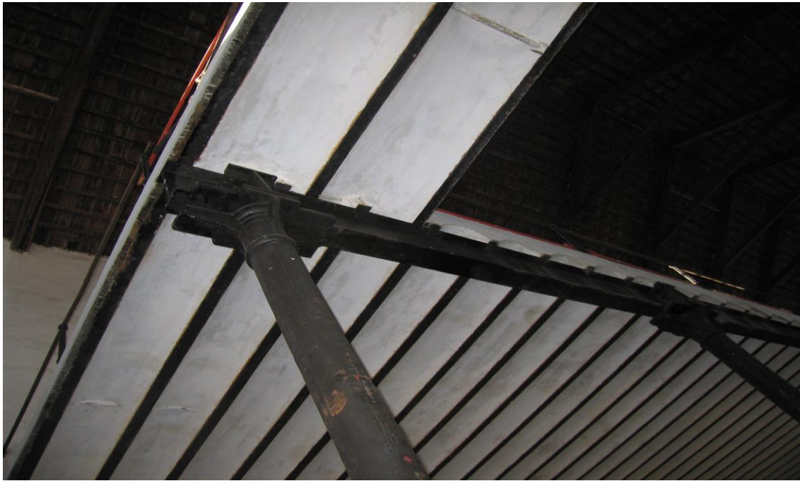
Fig. 79. Fotografía de los elementos sustentantes del almacén de planta rectangular restaurado en la azucarera Ntra. Sra. del Pilar (Motril). Propiedad de SGAE
