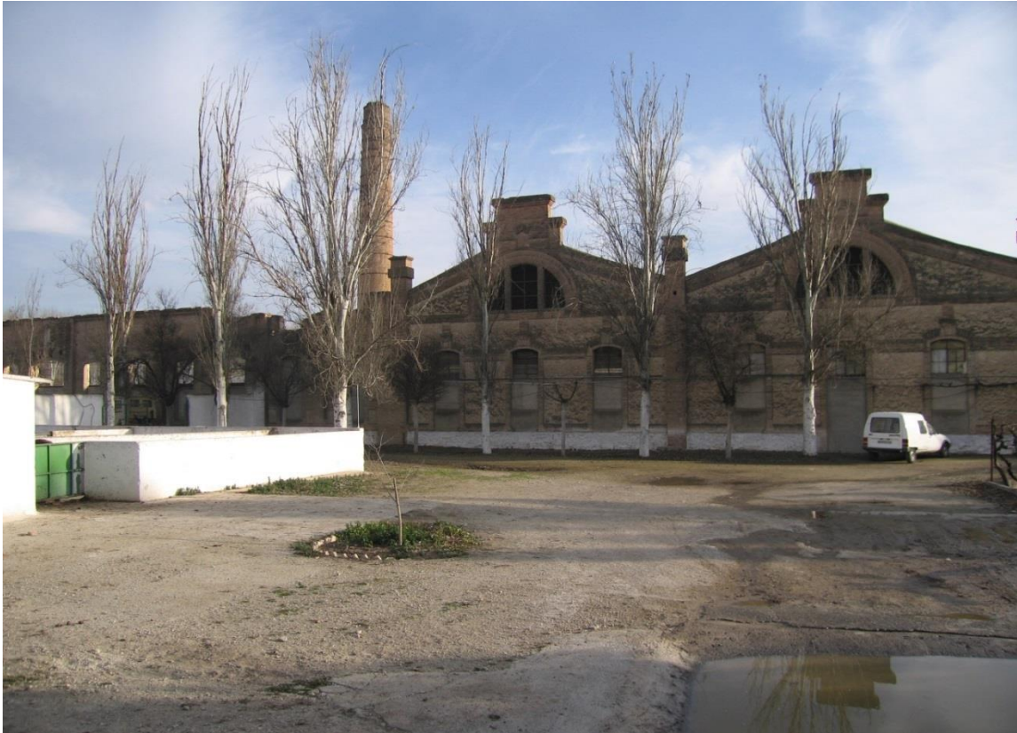
Fig. 421. Fotografía del interior actual del antiguo recinto de la azucarera San Pascual
