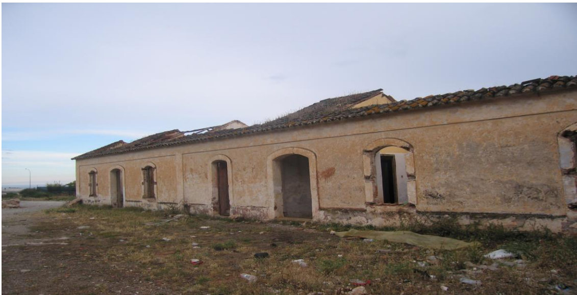
Fig. 104. Viviendas de obreros en la azucarera San Joaquín (Maro)
