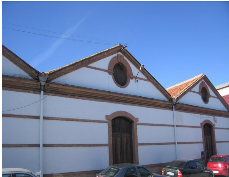
Fig. 262. Fotografía de los almacenes de azúcar de la fábrica Antequerana
