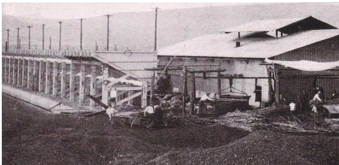
Fig. 146. Instalaciones en el puerto de Motril del cable aéreo Dúrcal-Motril. Fuente: SGAE. Benavente
