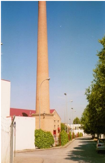
Fig. 274. La chimenea de la azucarera
