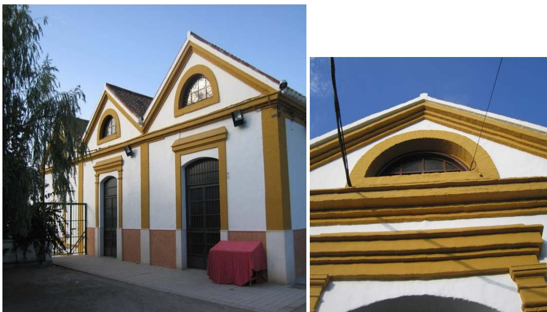
Fig. 436 y 437. Fotos del estado actual de las naves y detalle del tímpano del frontón de la azucarera Ntra. Sra. de la Almudena (Motril)
