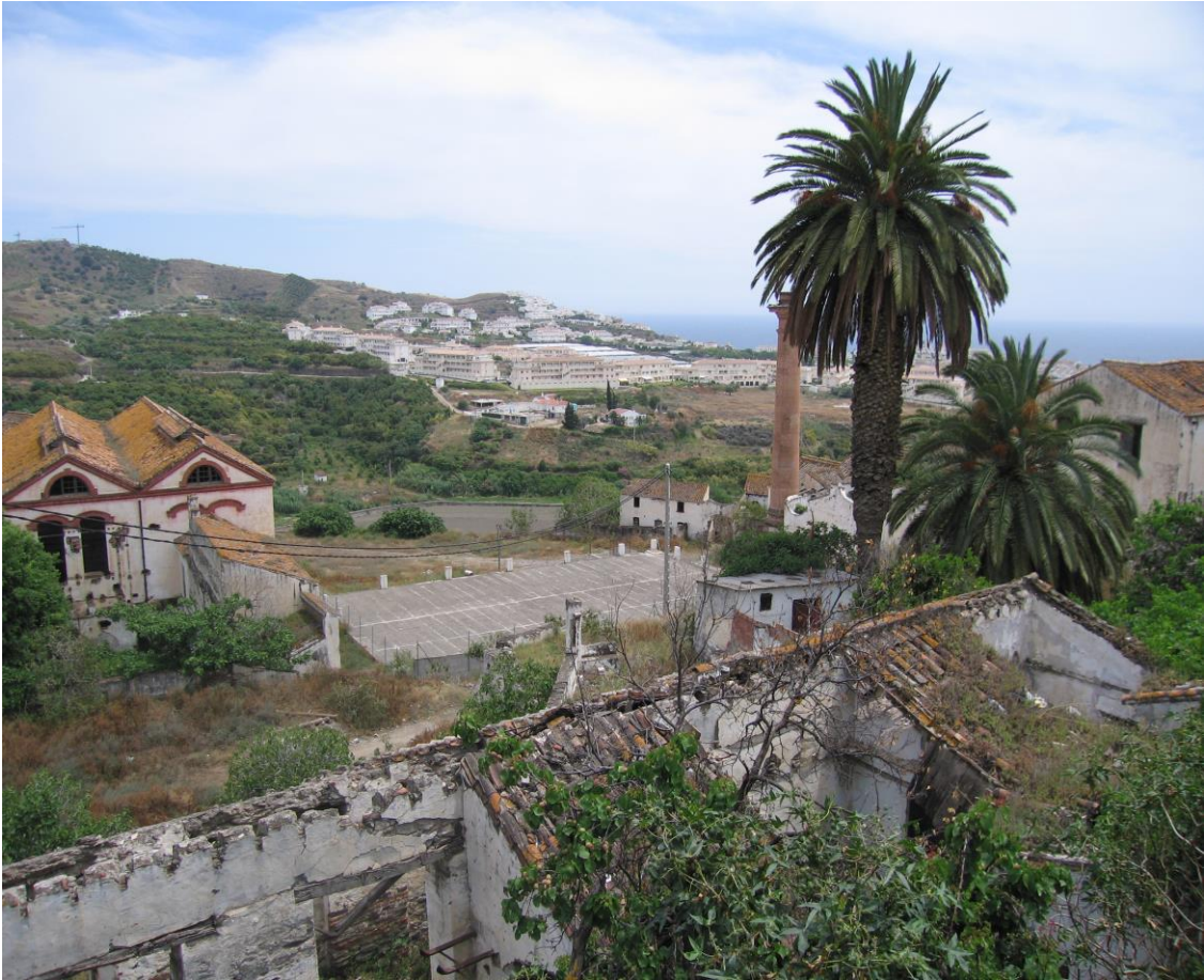
Fig. 256. Exterior del conjunto de la azucarera de San Rafael (Torrox)
