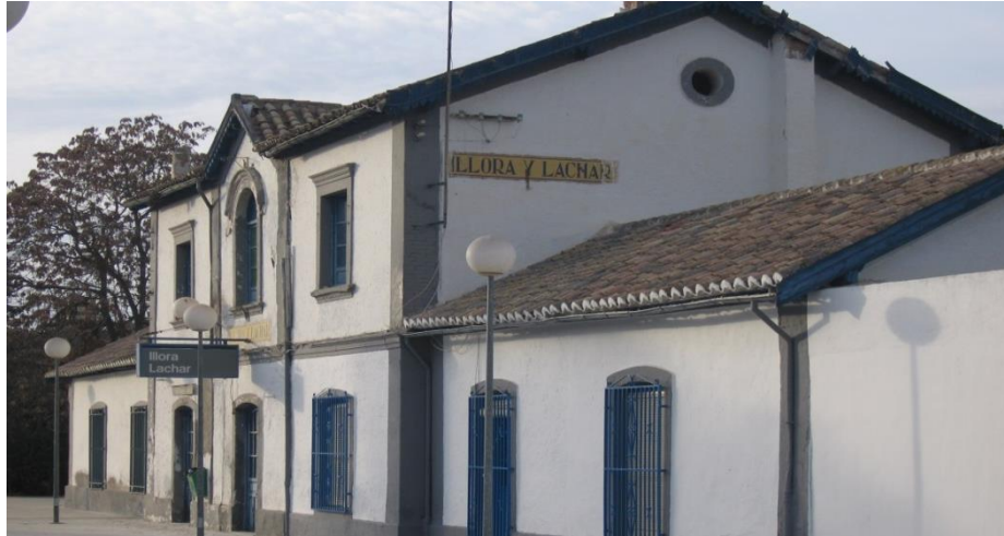
Fig. 356. Foto actual de la estación de Íllora y Láchar
