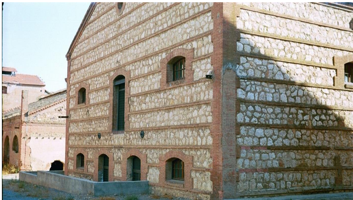
Fig. 593. Foto actual después de la intervención sobre el antiguo almacén de pulpa de la azucarera
