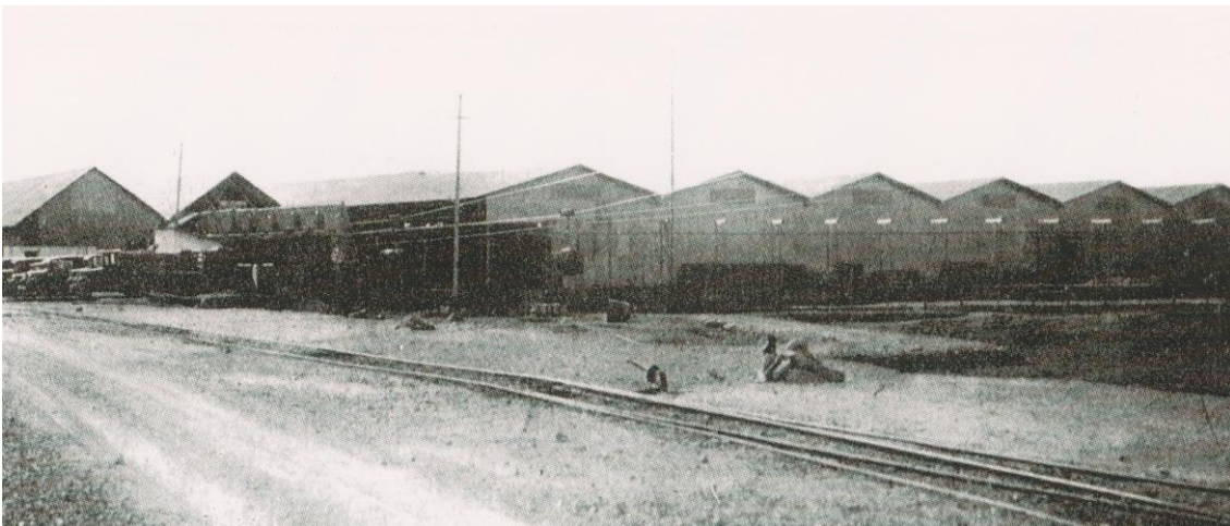
Fig. 149. Foto de los almacenes instalados en el puerto de Motril. ASGAE. Benavente
