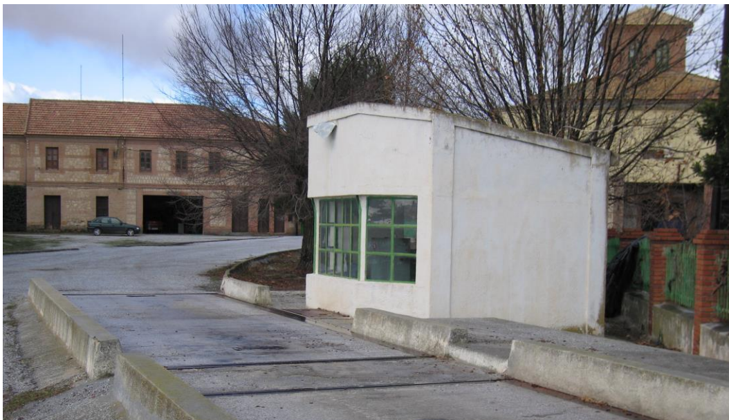
Fig. 100. Fotografía de una de las básculas instaladas en la azucarera de Ntra. Sra. de las Mercedes de Caniles
