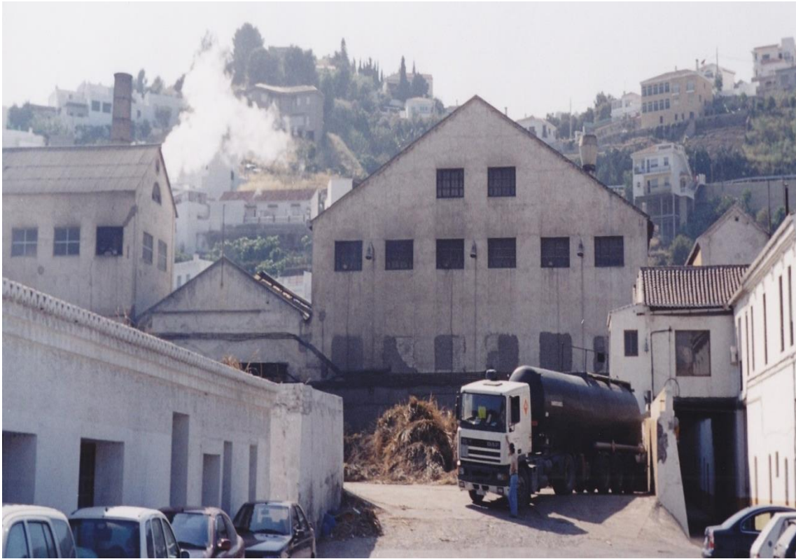
Fig. 503. Fotografía de la plaza de las cañas y de la nave de la sección de remolacha de la azucarera de Guadalfeo (Salobreña)
