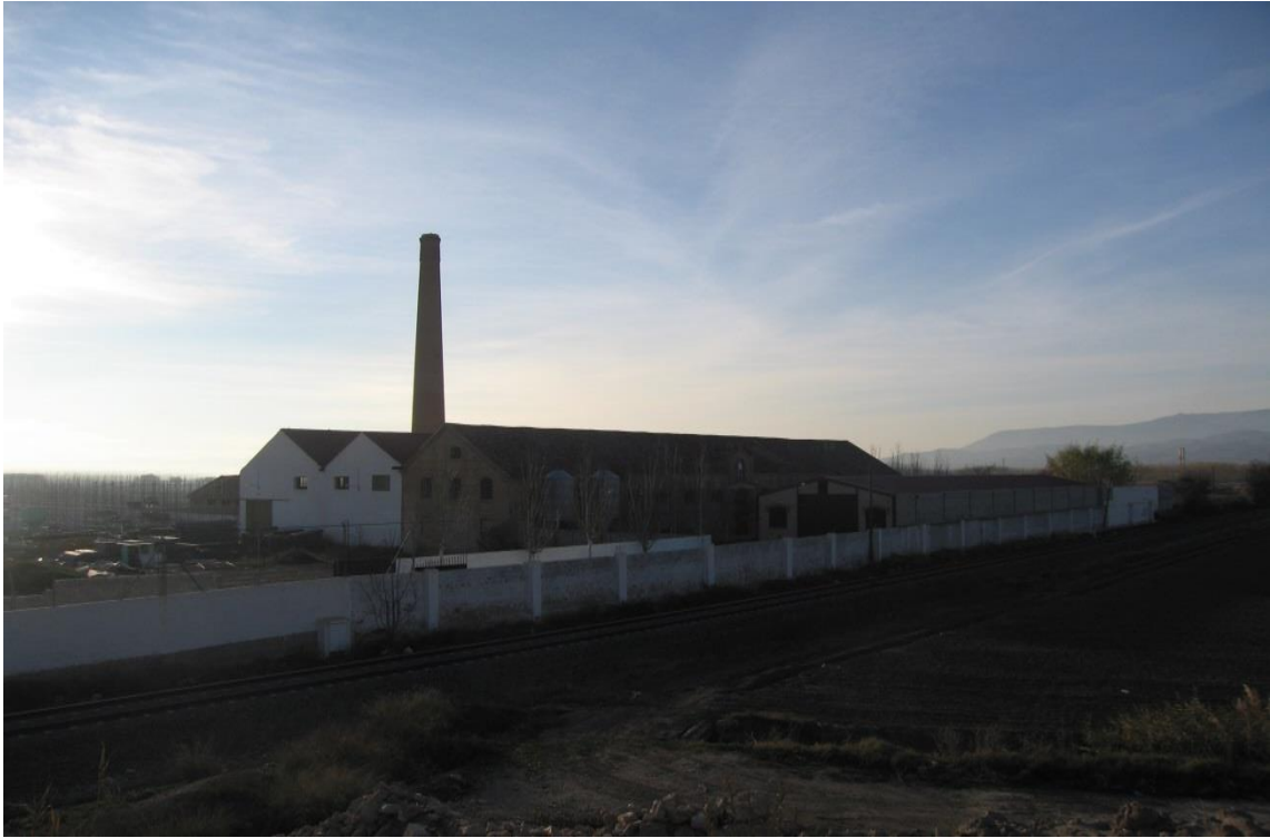
Fig. 367. Foto actual de los restos de la antigua azucarera y de las nuevas construcciones levantadas dentro del recinto
