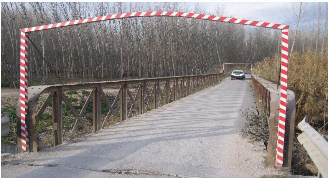
Fig. 357. Foto del puente de hierro del ferrocarril de vía estrecha que unía la azucarera y la Estación de Íllora
