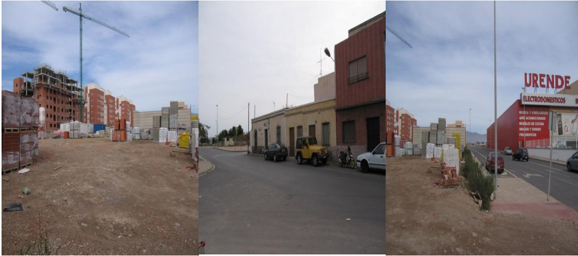
Figs. 613. Cinco fotos de los antiguos terrenos del recinto fabril ocupados hoy en proyectos constructivos. La quinta foto (superior derecha) es la plaza y espacio urbano circundante donde está actualmente colocada la puerta monumental de la azucarera
