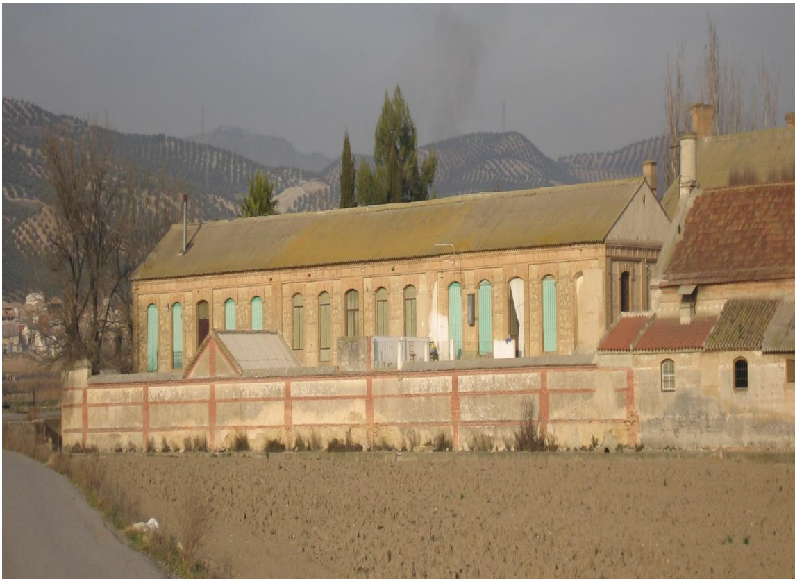
Fig. 422. Fotografía de la reutilización de parte las antiguas construcciones fabriles de la azucarera en viviendas
