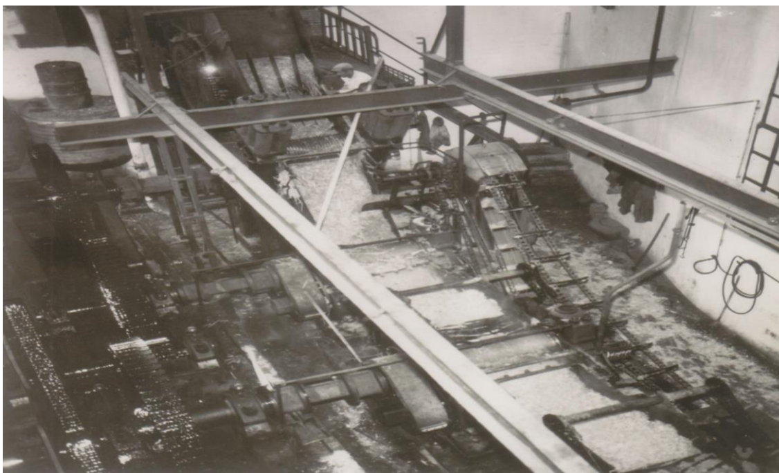
Fig. 1. Fotografía donde se muestra la conducción del bagazo en la Melcochera de Lobres. Fuente: AMSA
