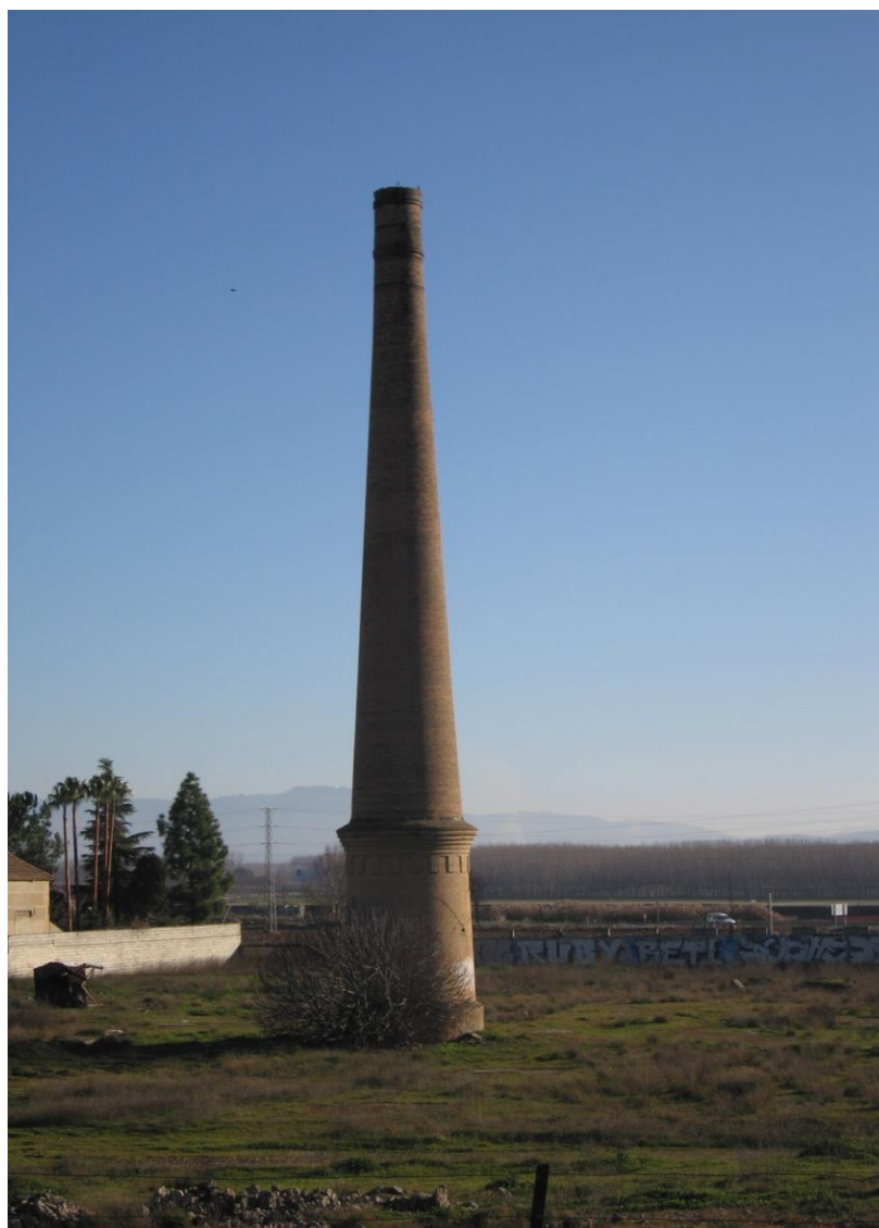
Fig. 293. Fotografía de la chimenea de la azucarera de La Vega (Atarfe)
