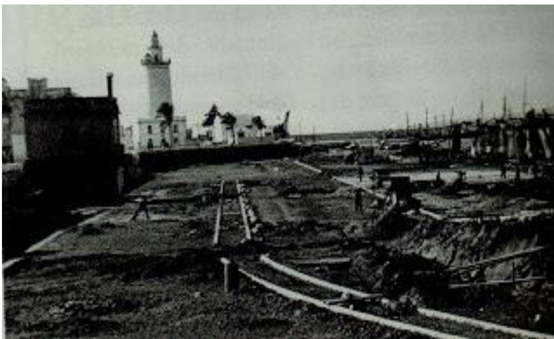
Fig. 156. Foto del muelle de Málaga y el faro. Fuente: AHMMA
