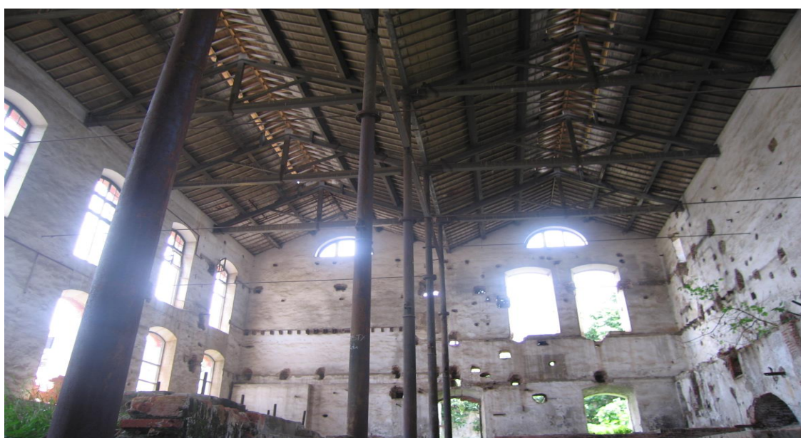
Fig. 250. Interior del Cuerpo de fábrica de San Rafael (Torrox)
