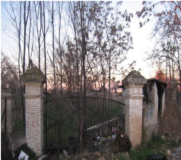
Fig. 326. Foto de la entrada a la destilería de San Isidro
