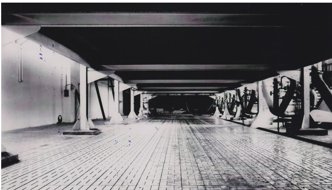
Fig. 118. Fotografía del piso inferior de la nueva difusión de la azucarera Ntra. Sra. del Carmen (Torre del Mar). Fuente: ASAL
