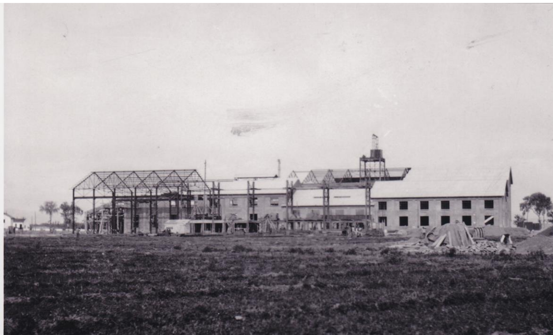
Fig. 122. Fotografía de un momento constructivo de la azucarera Hispania (Málaga). ASGAE. Benavente
