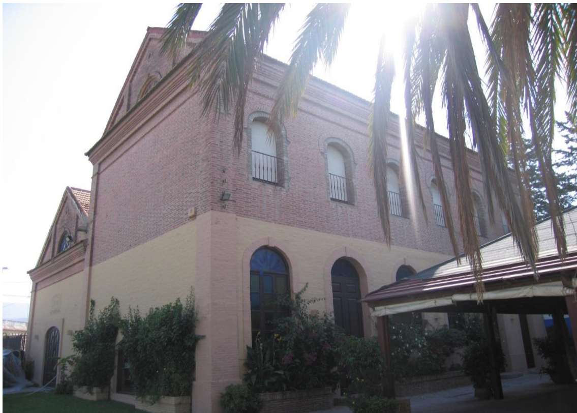
Fig. 459. Foto del antiguo Cuerpo de fábrica de Ntra Sra. de Lourdes rehabilitado en la actualidad
