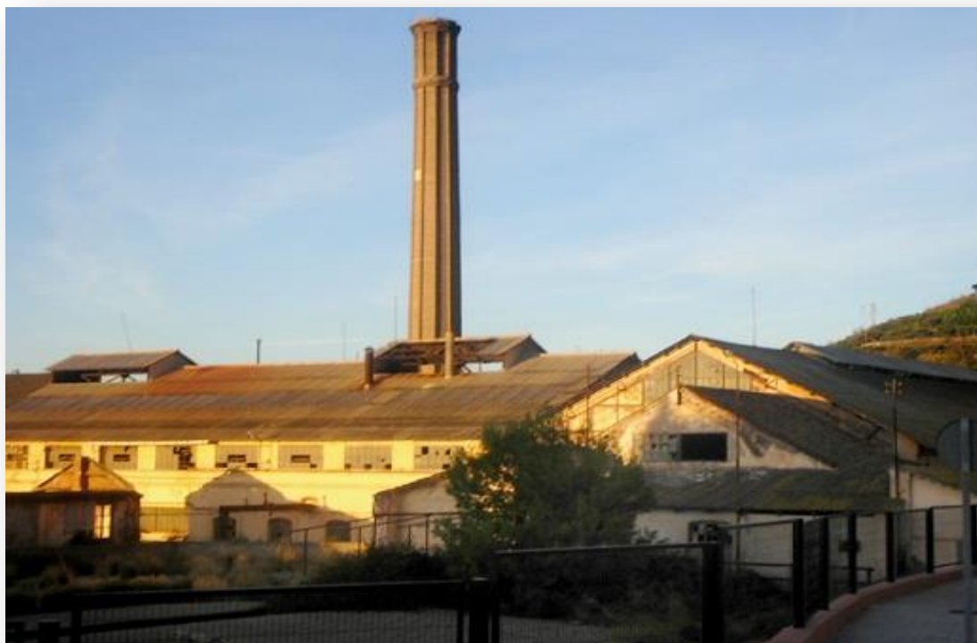
Fig. 460. Foto panorámica de la azucarera Ntra. Sra. del Pilar (Motril). Fuente: BVA
