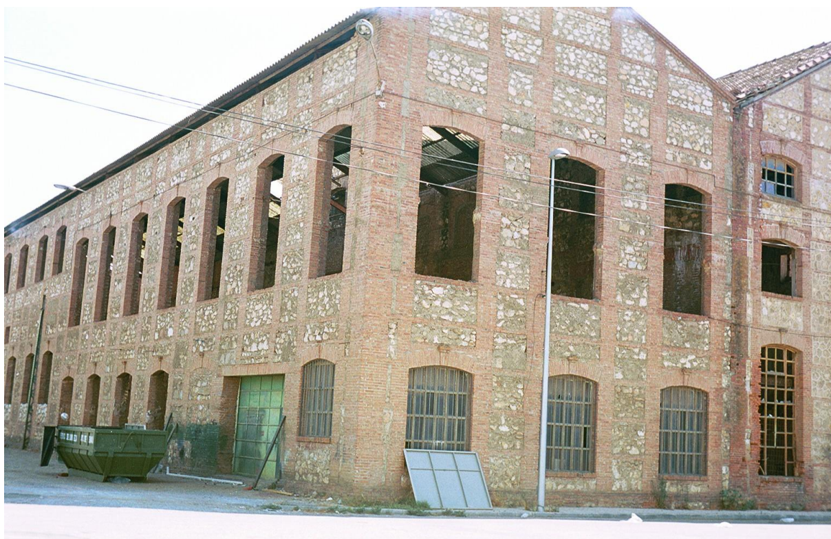
Fig. 76. Foto de los muros de carga del Cuerpo de fábrica de la azucarera Ntra. Sra. del Carmen de Benalúa
