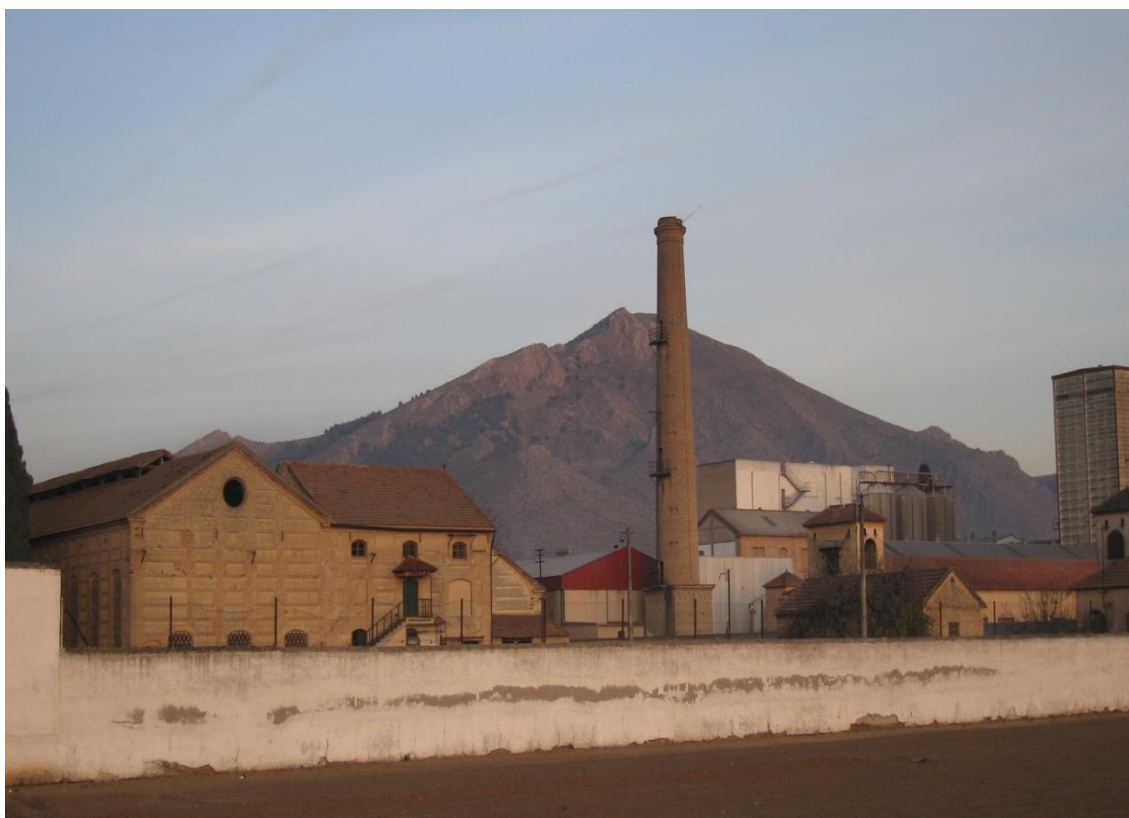
Fig. 372. Foto actual del recinto y parte de las construcciones del Cuerpo de fábrica y chimenea de Ntra. Sra. del Rosario
