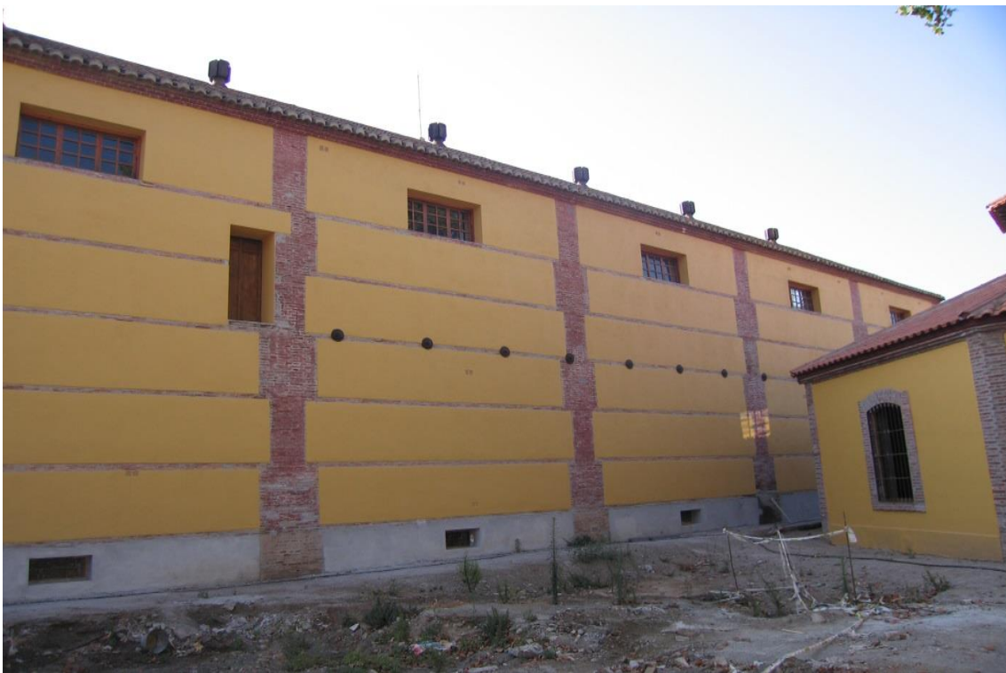
Figs. 478, 479, 480, 481, 482 y 483. Seis fotos de la rehabilitación interior y exterior de los antiguos almacenes. El almacén de efectos (octogonal) y el almacén rectangular adosado de la azucarera de Ntra. Sra. de Pilar. Se convertirá próximamente el octogonal en un restaurante temático dentro del futuro Museo del Azúcar emplazado en las antiguas construcciones fabriles
