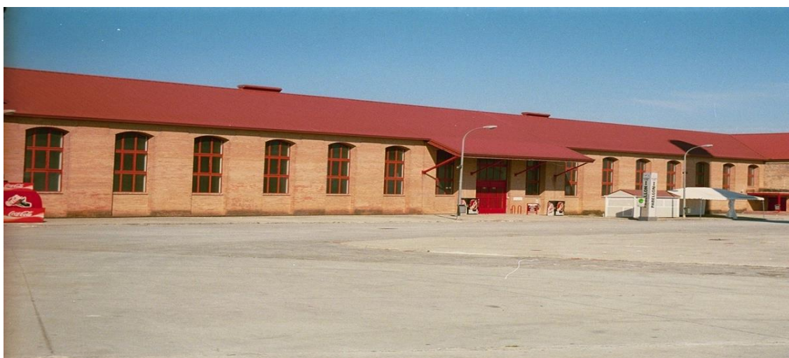
Fig. 273. Estado actual del antiguo Cuerpo de fábrica de Santa Juliana
