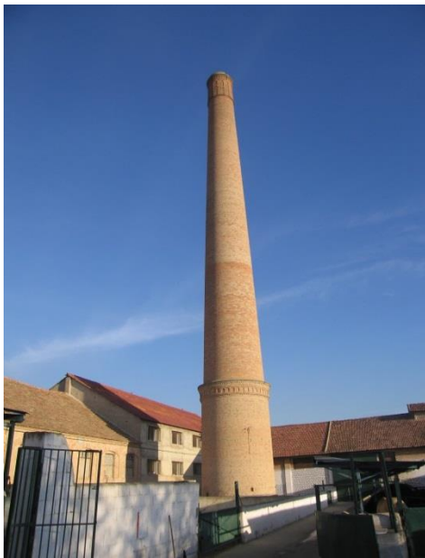
Fig. 364. Antigua chimenea del Carmen
