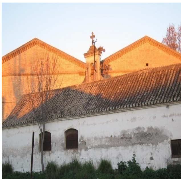
Fig. 320. Capilla de la fábrica San Isidro (exterior)
