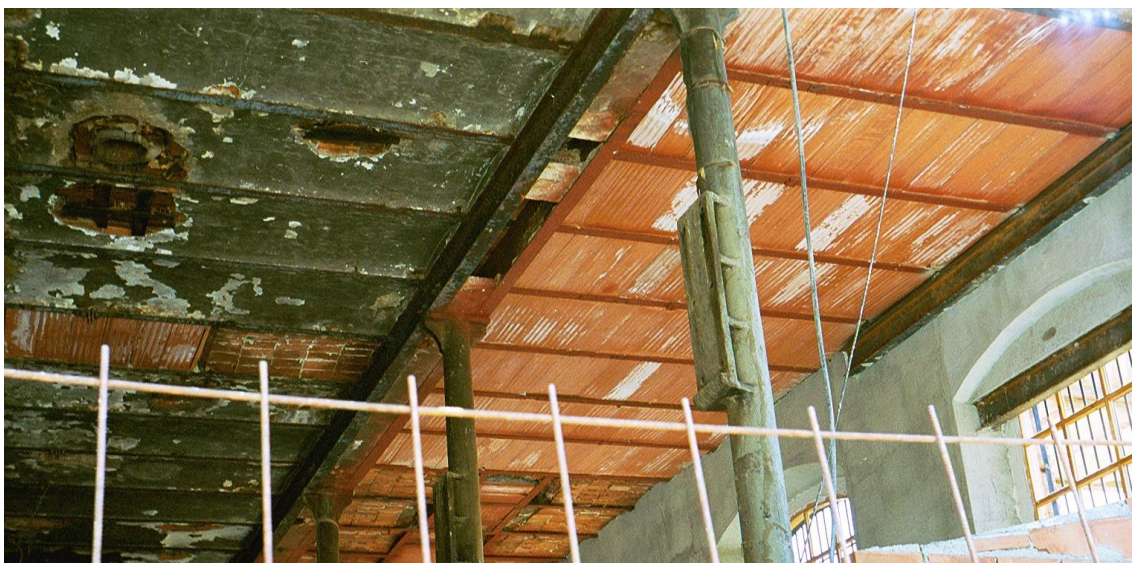
Fig. 80. Fotografía de los forjados antiguos y en proceso de restauración de una de las naves de la azucarera Ntra. Sra. del Carmen de Benalúa de Guadix
