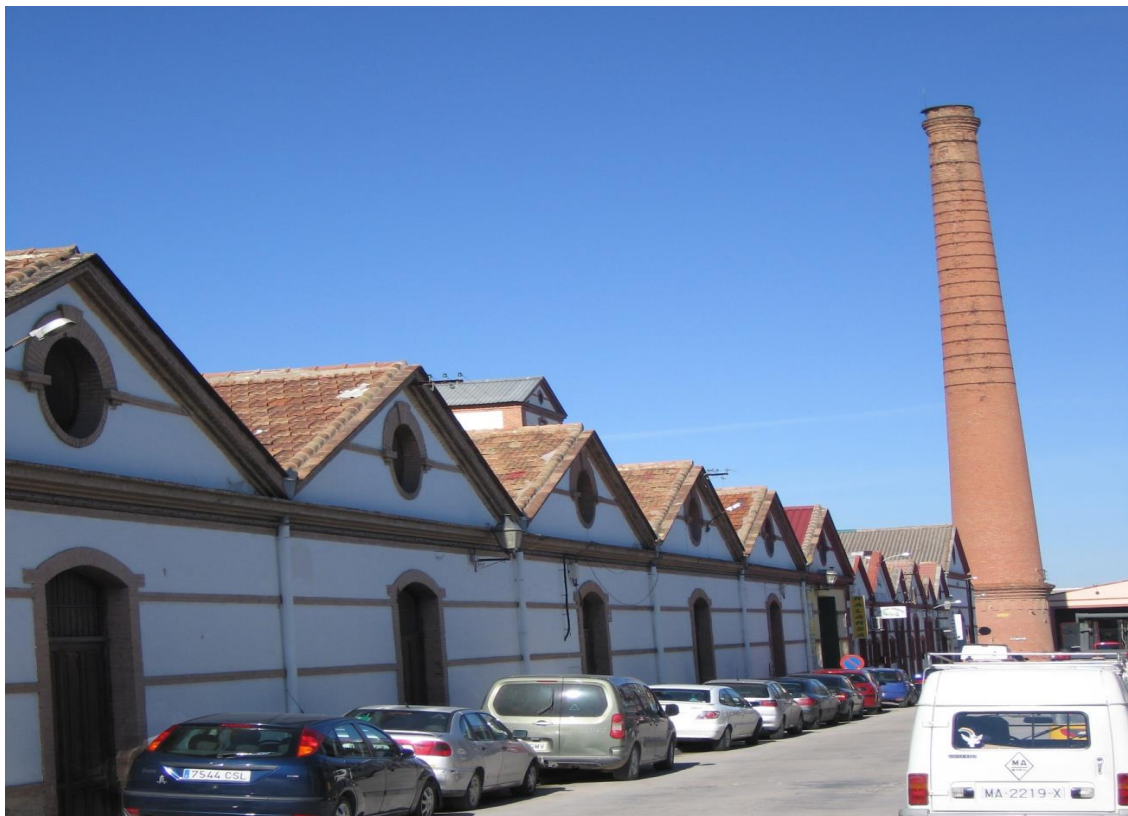
Fig. 267 Fotografía del estado actual de los antiguos almacenes de la azucarera antequerana y la chimenea al fondo
