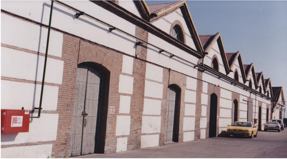
Fig. 504. Fotografía de los almacenes de la azucarera de Guadalfeo (Salobreña)
