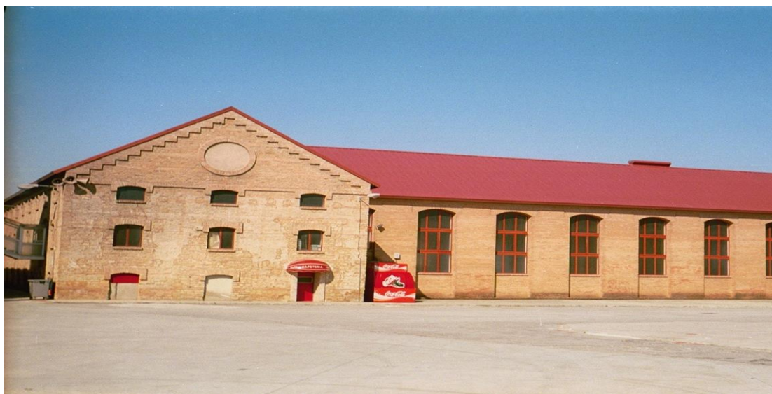
Fig. 272. Estado actual del exterior del Cuerpo de fábrica de Santa Juliana
