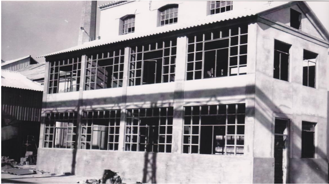
Fig. 123. Fotografía de la construcción de nuevo Laboratorio y las oficinas técnicas en la azucarera Ntra. Sra. del Carmen (Torre del Mar). Octubre de 1966. Fuente: ASAL
