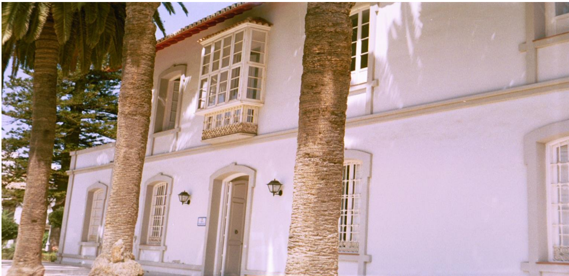
Fig. 237. Foto de la vivienda principal de la azucarera de Torre del Mar
