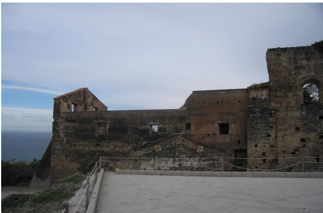
Fig. 213. Foto actual de los exteriores del Ingenio Armengol en Maro
