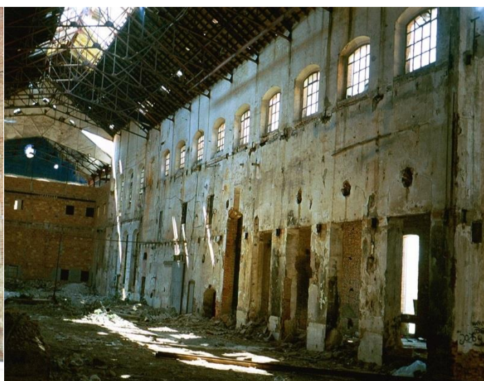
Fig. 562. Estado actual del interior del Cuerpo de fábrica
