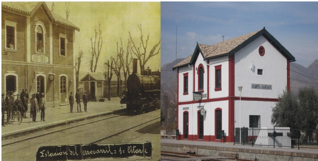
Fig. 279. Estación de ferrocarril de Atarfe: Fuente ASGAE. AB Fig. 210. Foto actual de la estación de ferrocarril
