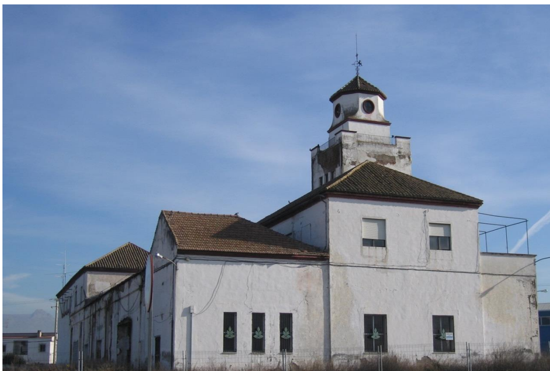
Fig. 304. Foto de parte de las construcciones rehabilitadas de la azucarera Ntra. Sra. de las Angustias (Granada)
