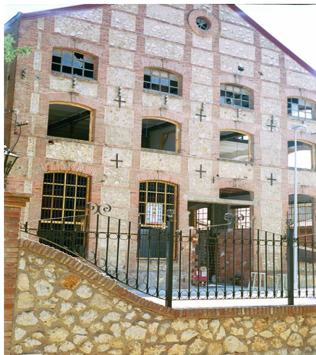
Fig. 75. Muros de carga de la azucarera de Benalúa de Guadix
