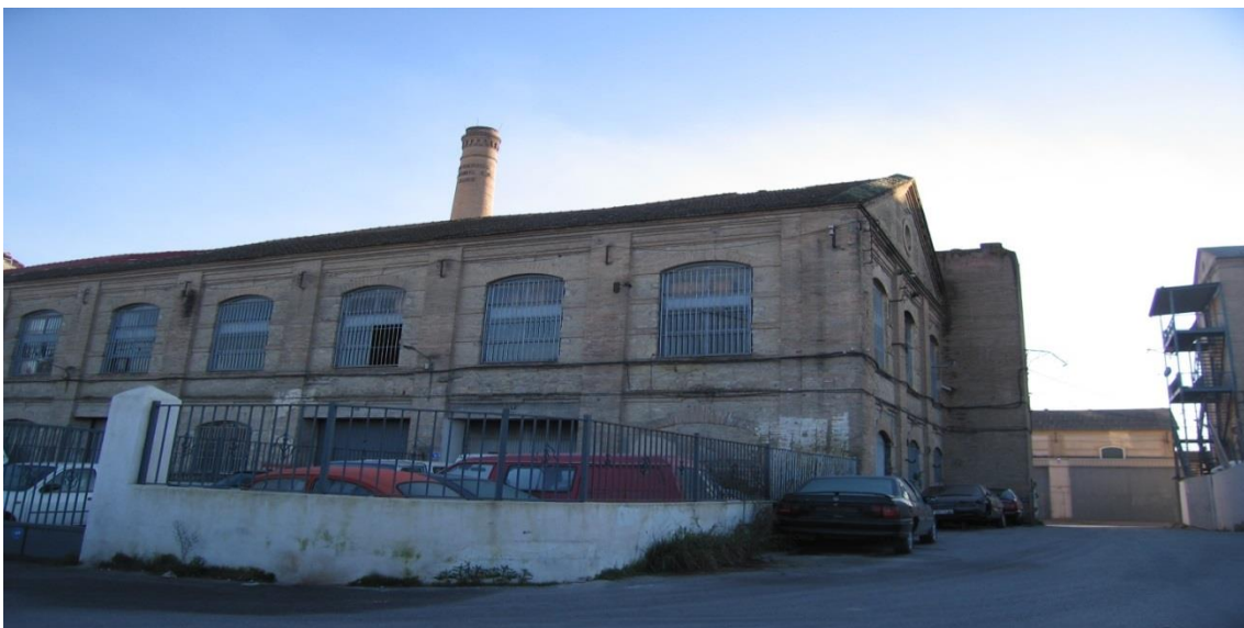
Fig. 388 y 399. Dos fotografías del estado actual del antiguo Cuerpo de fábrica de la Azucarera del Genil S.A o La Purísima (Santafé)
