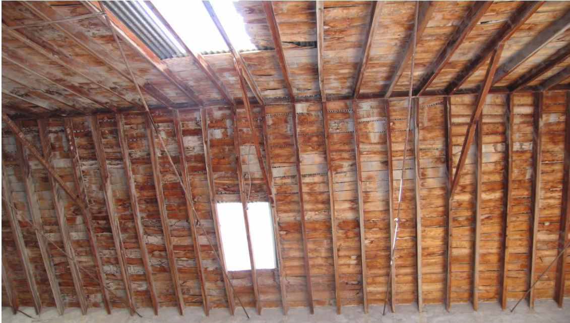
Fig. 81. Fotografía de una cubierta de madera de uno de las construcciones de la azucarera Ntra. Sra de las Mercedes de Caniles de Baza
