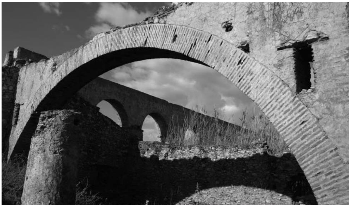
Fig. 257. Fotografía de las ruinas del ingenio de San Javier (Torrox). Fuente: R. Marín
