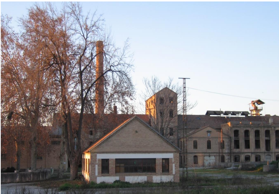
Fig. 319. Fotografía panorámica de la chimenea y el Cuerpo de fábrica (fondo) de la azucarera San Isidro (Granada)
