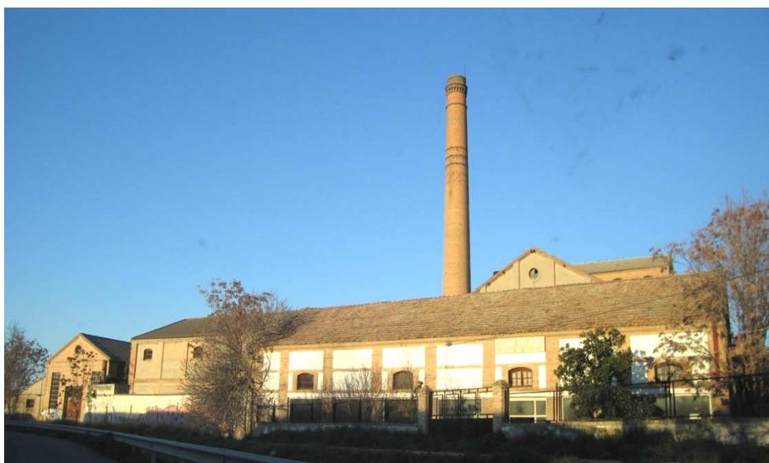
Fig. 314. Fotografía del Cuerpo de fábrica de la azucarera San Isidro
