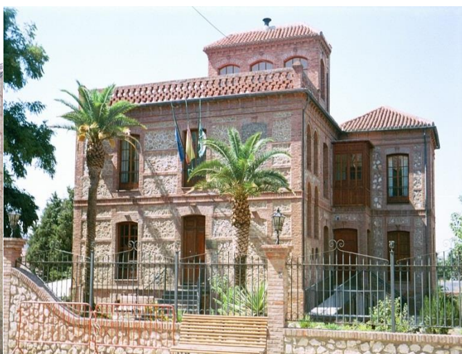
Fig. 560. Casa de Dirección. Actual Ayuntamiento de Benalúa
