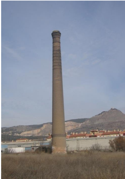
Fig. 282. La chimenea de la fábrica
