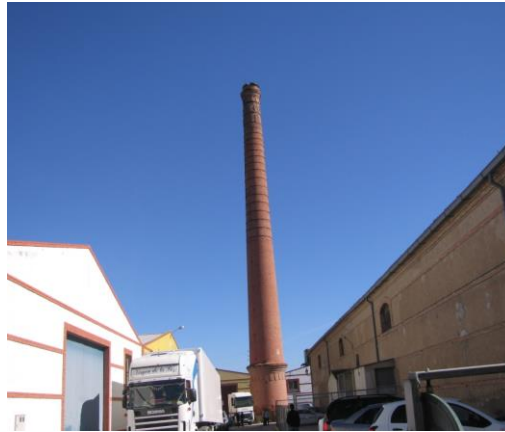
Fig. 260. Fotografía de la chimenea
