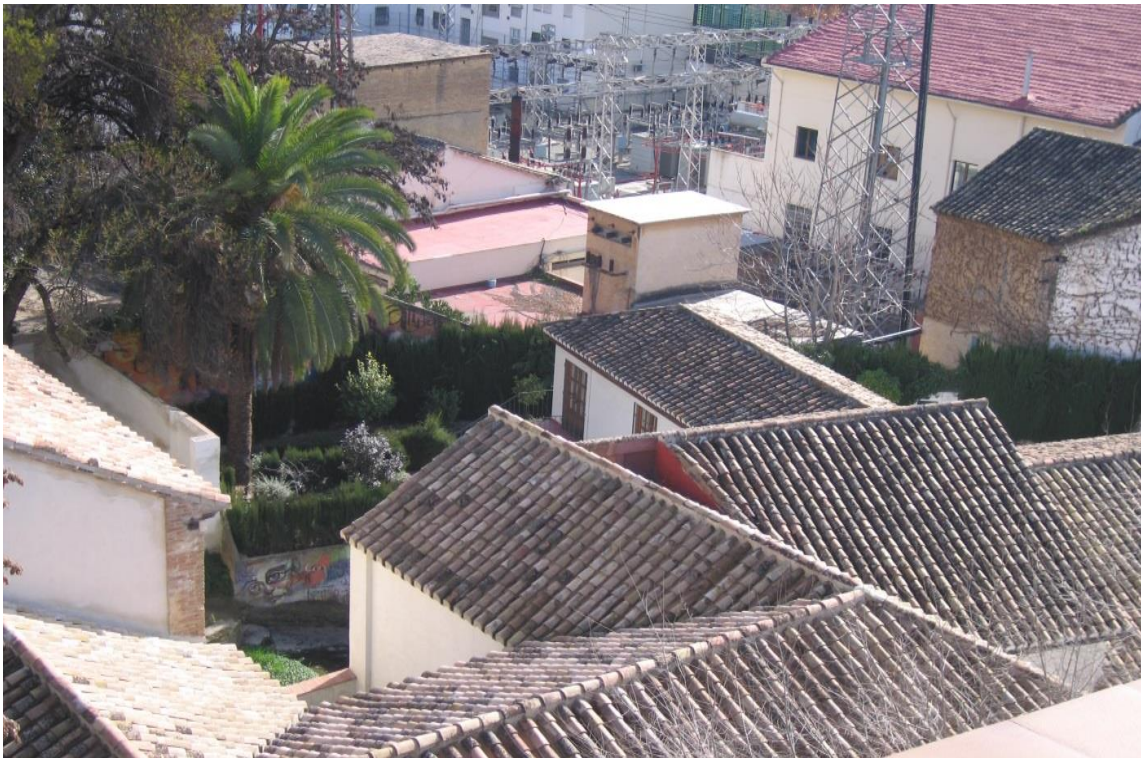
Fig. 340. Foto del conjunto de construcciones adosadas a la antigua azucarera en la cuesta de molinos. Al fondo parte de la Sevillana
