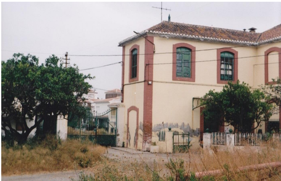
Fig. 476. Foto desde el interior del recinto de las dos viviendas rehabilitadas en 1954. Viviendas para el Ingeniero y los directivos la sede central de Madrid de la Sociedad General
