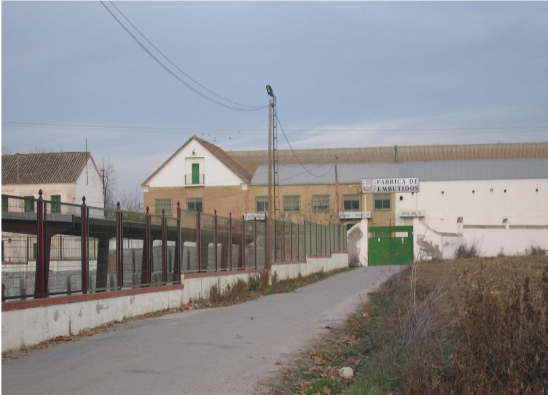
Fig. 359. Foto de la entrada actual al recinto de industrias cárnicas Vílchez
