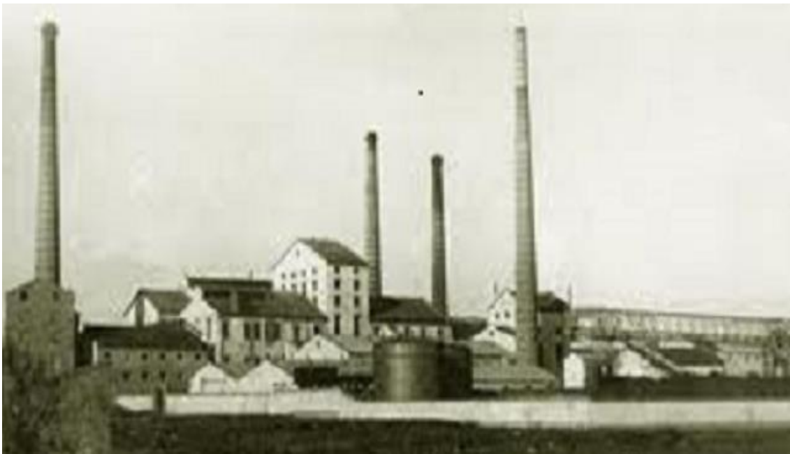
Fig. 64. Azucarera libre del Jalón en Zaragoza (1904-1996). En 2006 Ebro Puleva vendió todas las instalaciones. Fuente: Archivo Ebro Puleva
