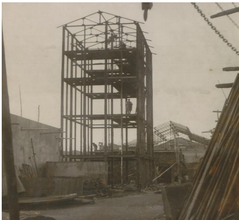
Fig. 553. Montaje de la vieja destilería Montero (antigua de Benalúa). Fuente: AMSA
