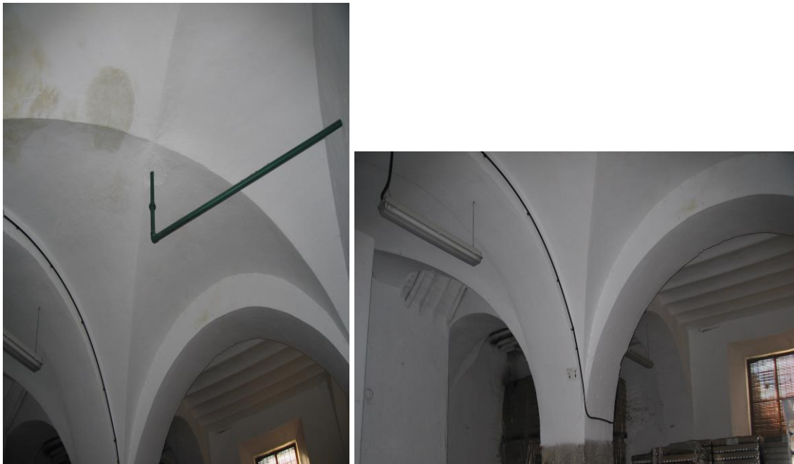
Fig. 205. Dos fotografías de las bóvedas de arista en la sala denominada la “Capilla”
