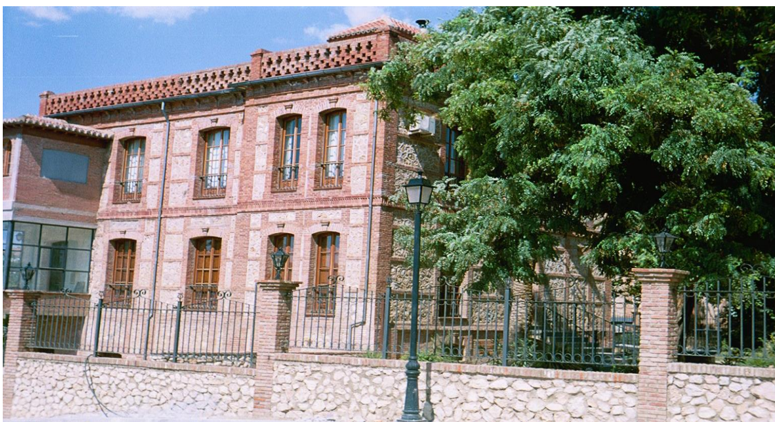
Fig. 114. Fotografía de la casa de dirección de la azucarera de Benalúa de Guadix
