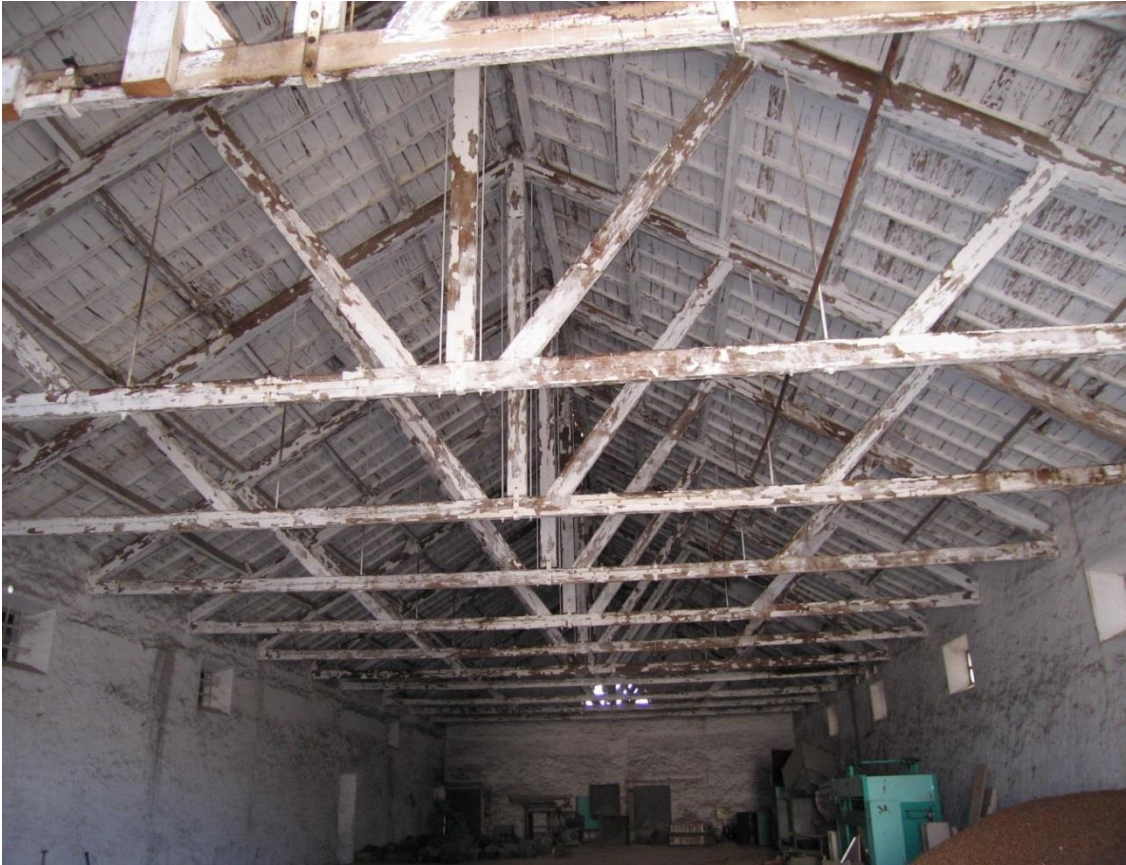
Fig. 580. Foto del interior de uno de los almacenes. Cubierta de cerchas y tablazón de madera
