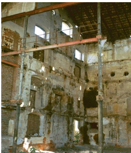
Fig. 563. Estado actual del interior del Cuerpo de fábrica
