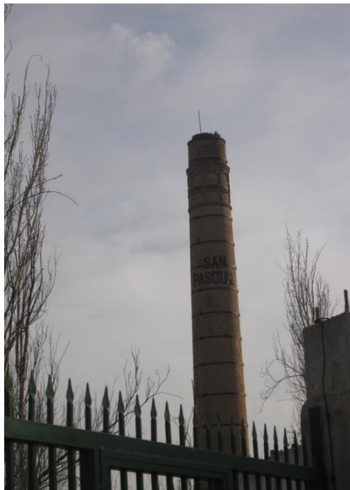
Fig. 416. Fotografía de la chimenea de la azucarera
