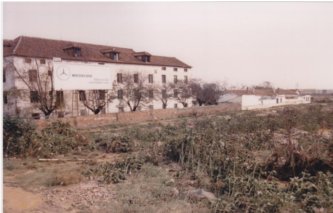
Fig. 162. Fotografía de parte de las construcciones y tapia del Ingenio Ordóñez convertido posteriormente en el barrio de la azucarera Hispania (Málaga). Fuente: ASGAE. Benavente
