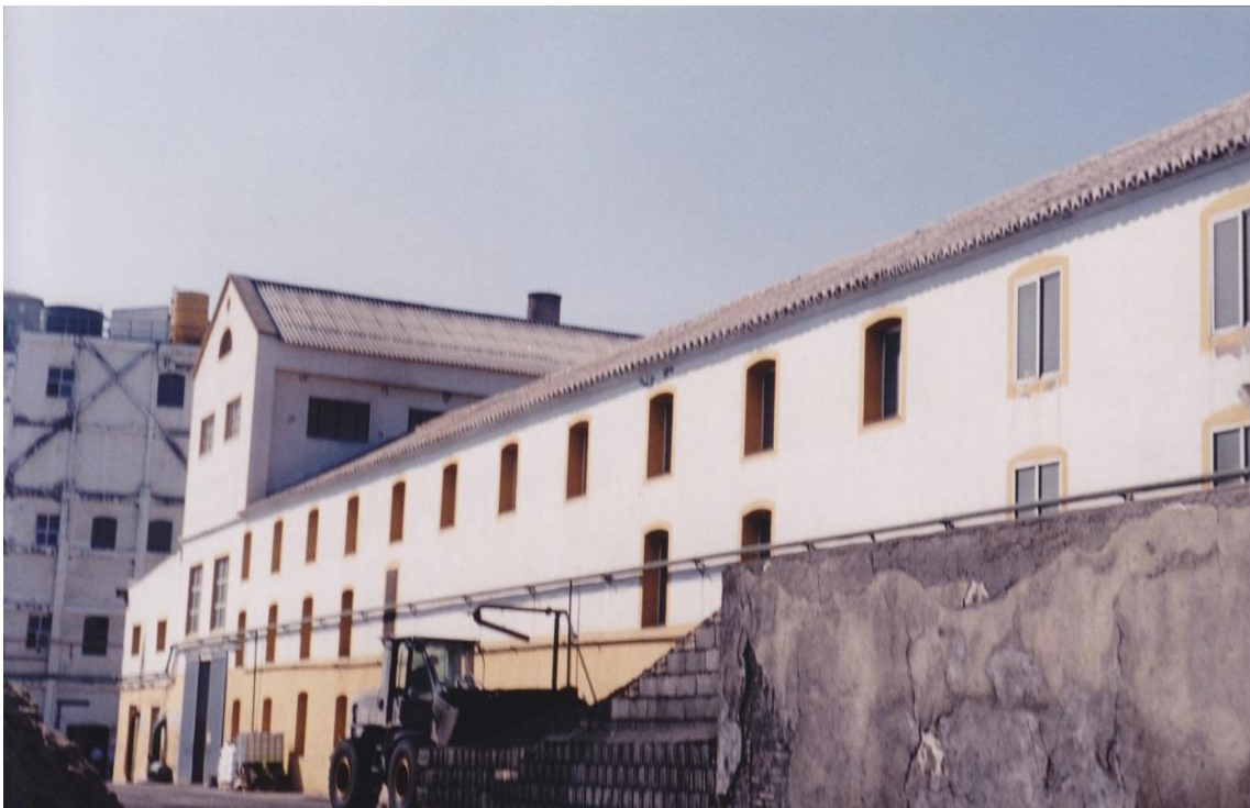
Fig. 505. Fotografía de la carbonera (derecha), los secaderos (frente) y de la destilería (izquierda) de la azucarera
