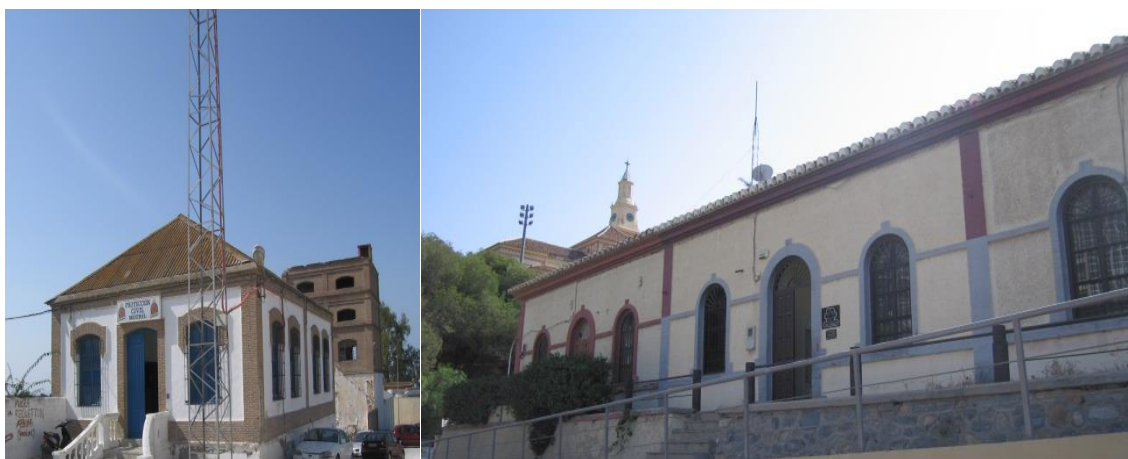
Fig. 449. Recinto de la alcoholera. Protección civil Fig. 450. Recinto de la alcoholera. Centro de drogodependencias
