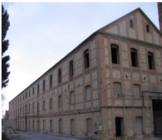
Fig. 570. Foto del exterior del Cuerpo de fábrica
