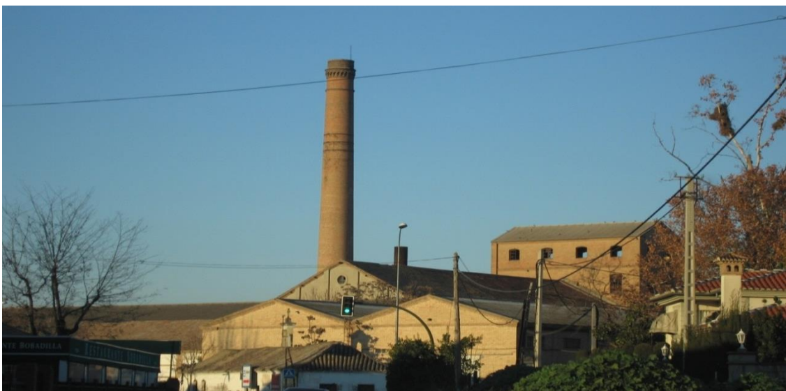
Fig. 316. Fotografía del Cuerpo de fábrica y chimenea de la azucarera San Isidro (Granada)
