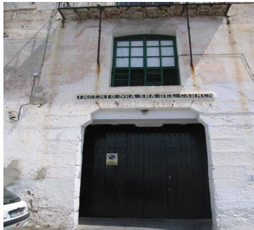
Fig. 202. Puerta principal de la fachada del Ingenio
