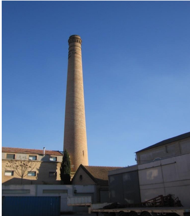
Fig. 392. Fotografía del estado actual de la chimenea
