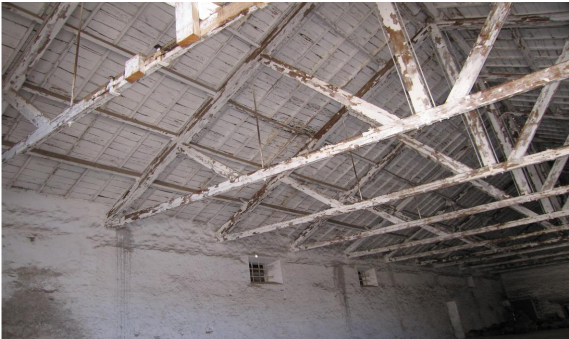
Fig. 82. Cerchas de madera en una construcción de la azucarera de Ntra. Sra. de las Mercedes de Caniles de Baza
