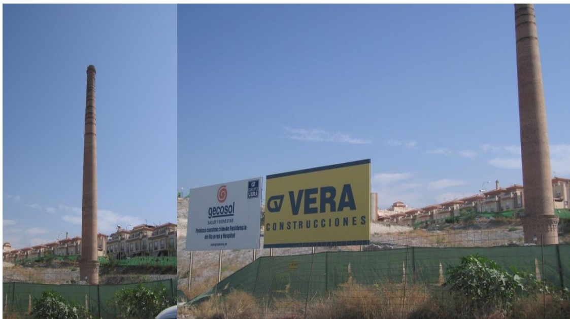
Figs. 433 y 434. Fotos actuales de la chimenea de la azucarera La Motrileña (Motril). En sus alrededores nacen urbanizaciones
