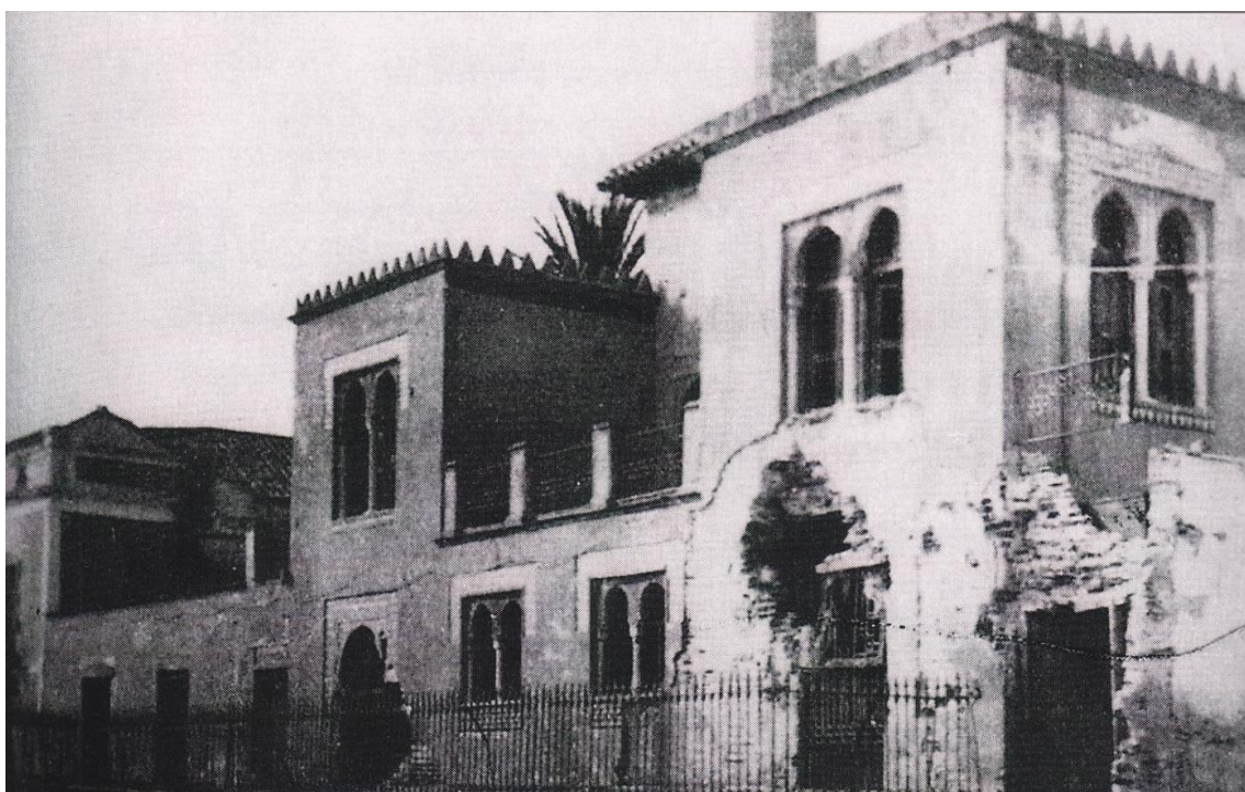
Fig. 429. Estado del edificio de la Najarra después del bombardeo republicano de abril de 1937. Fuente: ASGAE
