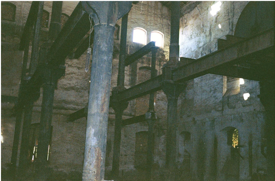
Fig. 74. Fotografía de pilares de hierro fundido en la azucarera San Torcuato (Guadix)
