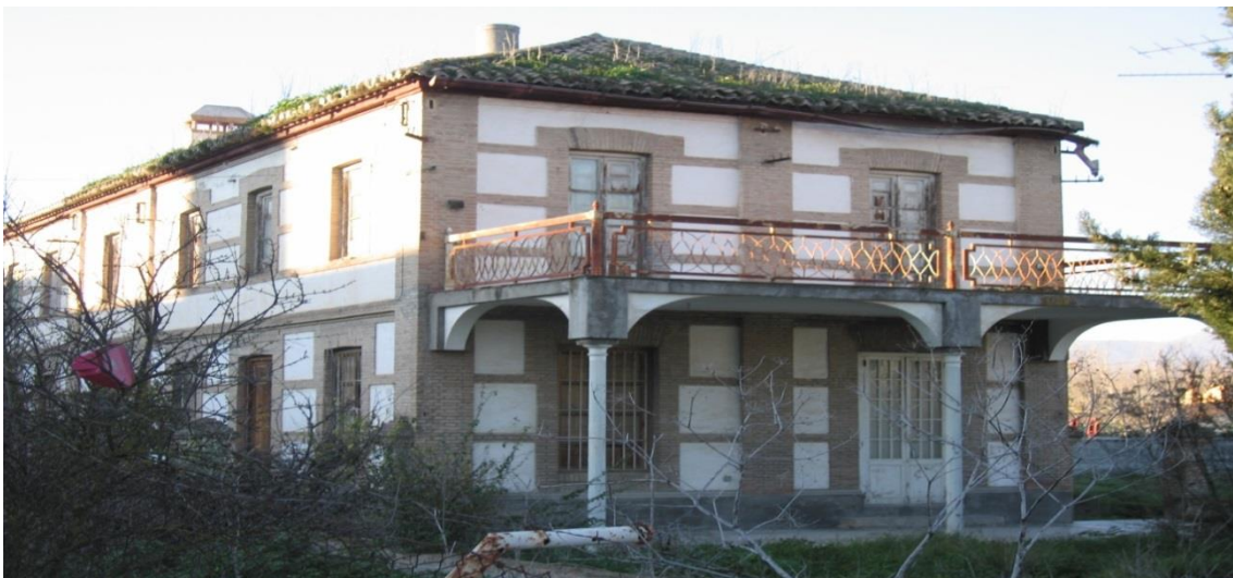
Fig. 397. Fotografía de la terraza y porche vivienda principal y de empleados del complejo fabril de la azucarera La Purísima (Santafé)
