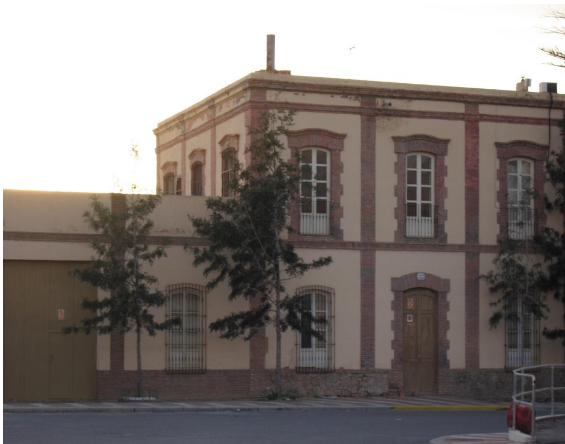
Fig. 600. Foto del antiguo almacén de efectos de la Azucarera de Adra
