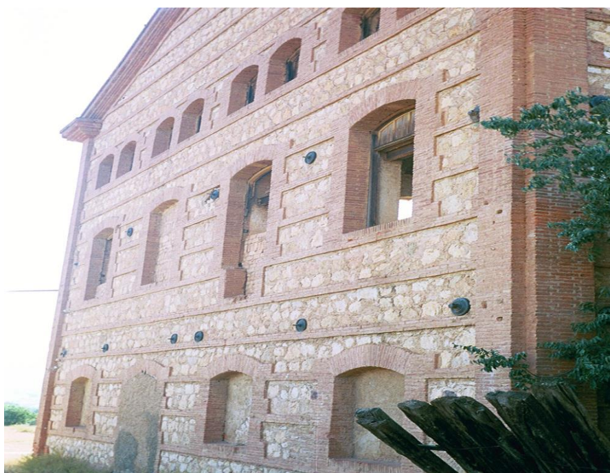
Fig. 86. Foto de los vanos en una de las construcciones de la fábrica San Torcuato (Guadix)
