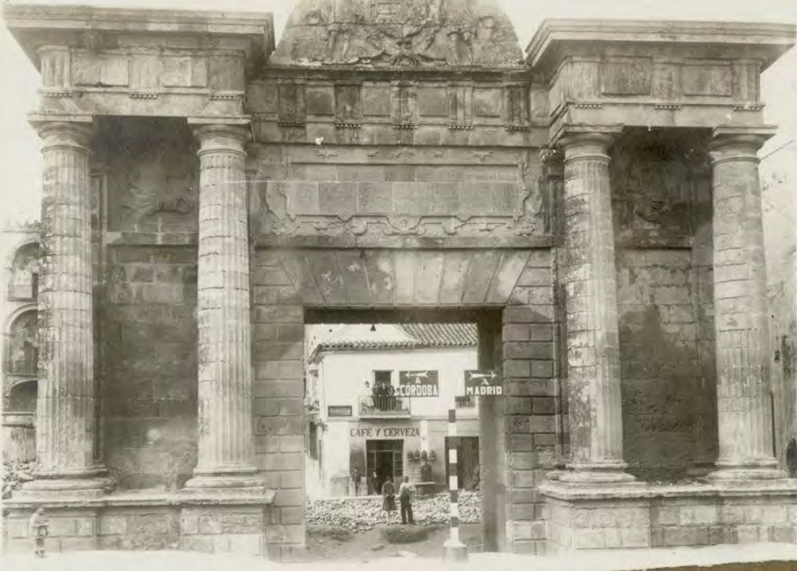
Figura 1.20: Fotografía de la Puerta del Puente, al desembarcar, desde el puente Romano.
