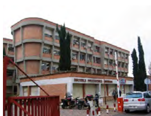
Figura 2.84: Escuela Ingenieros Técnicos Industriales. Fuente: Instituto Andaluz del Patrimonio Histórico
