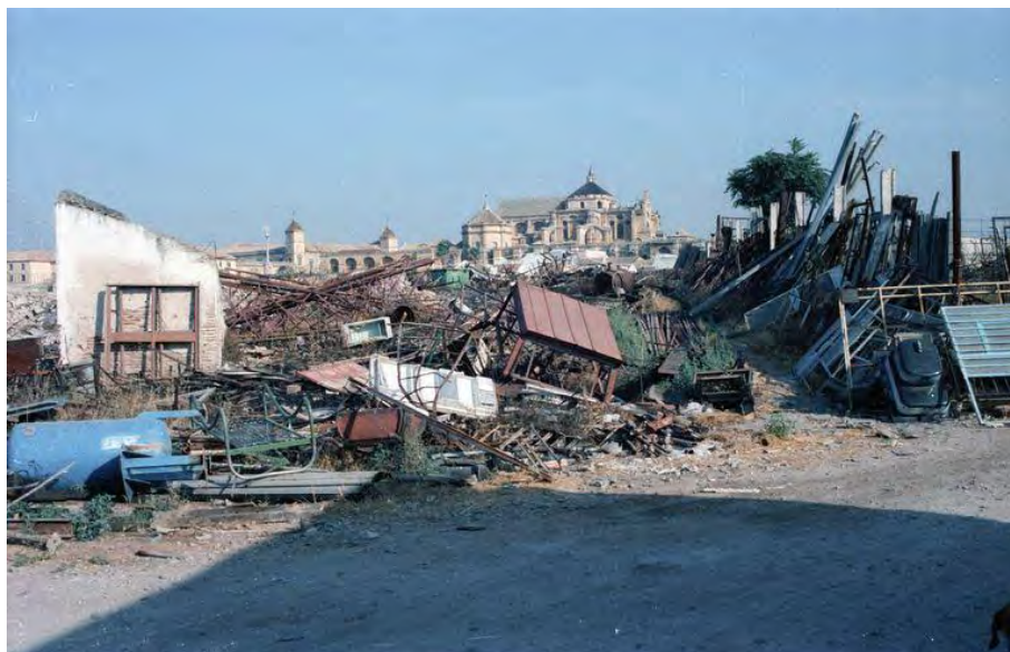
Figura 2.27: Escombros en Miraflores (1993) Autor desconocido. 1993. Fuente: Archivo Municipal de Córdoba.
