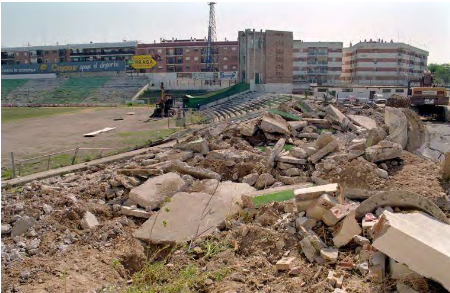
Figura 2.65: Demolición del estadio del Arcángel. Fuente: Archivo Municipal de Córdoba
