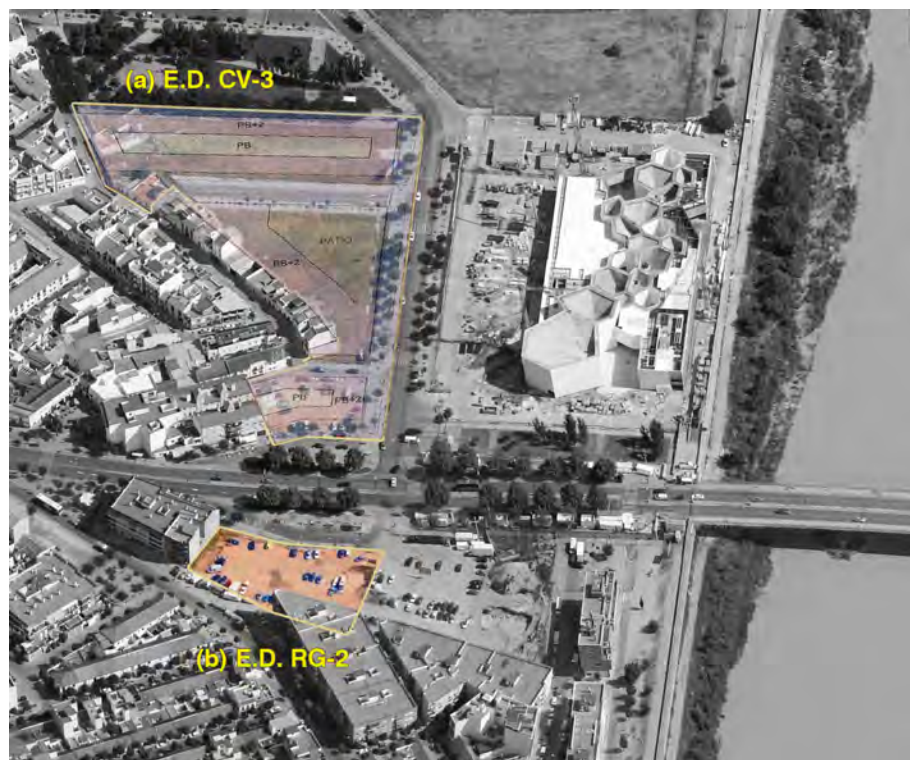
Figura 2.29: Estudios de Detalle en el Campo de la Verdad: (a) Superposición del Plano de Ordenación de Volúmenes del Estudio de Detalle de la Unidad de Ejecución cv-3 (2007). Promotor: Procanval S.L. Arquitectos: R. Castello Pérez, J.A. González-Muriel Martínez. Promotor: Procanval S.L. (b) Solar B del Estudio de Detalle rc-2, objeto del concurso v4J (viviendas para jóvenes en Córdoba). Fuente: Elaboración propia a partir de imagen aérea de Google Maps 2013 y del proyecto refundido del ED. CV-3 (Gerencia Municipal de Urbanismo de Córdoba).
