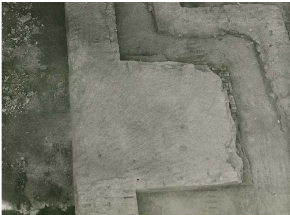
Fig. 105. Murcia. Vista cenital del torreón comentado en la figura anterior. Obsérvese el forro con que fue reparado y el relleno entre éste último y la estructura original. Apréciense, así mismo, cómo una de las esquinas fue rehecha con ladrillos (Navarro Palazón y Jiménez Castillo, 1991-1992)
