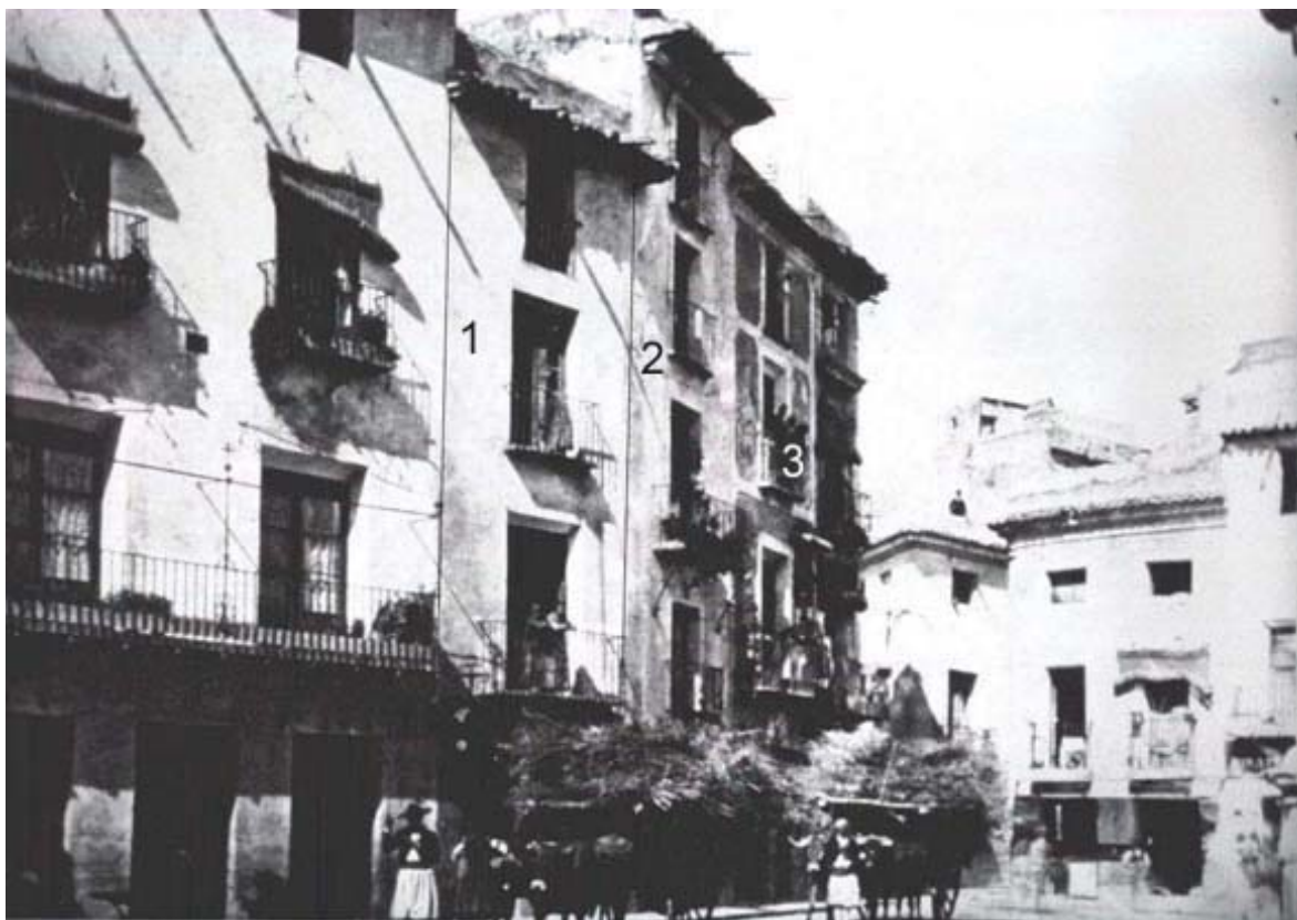
Fig. 375. Foto antigua de la calle S. Pedro de Murcia, frente a la iglesia del mismo nombre. Obsérvese que en la ciudad tradicional cristiana las casas se abren a la fachada para su ventilación e iluminación, dado que en la mayor parte de ellas ya no existe patio central que cumpla con estas funciones. La existencia de profundas y estrechas parcelas (1, 2 y 3) es otro rasgo característico
