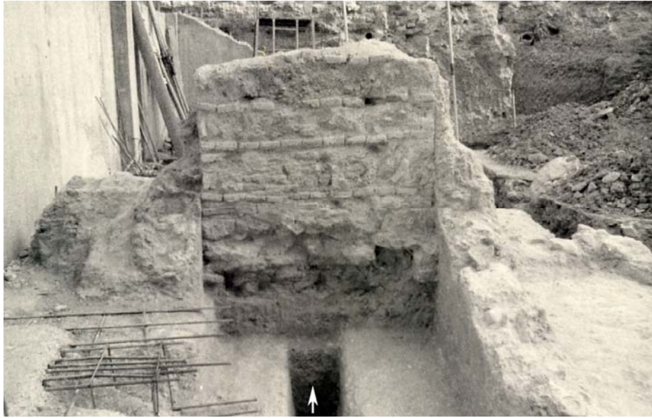
Fig. 136. Vista desde el interior del portillo de la figura anterior; el vano fue cegado con el muro de mampostería encintada del centro de la imagen
