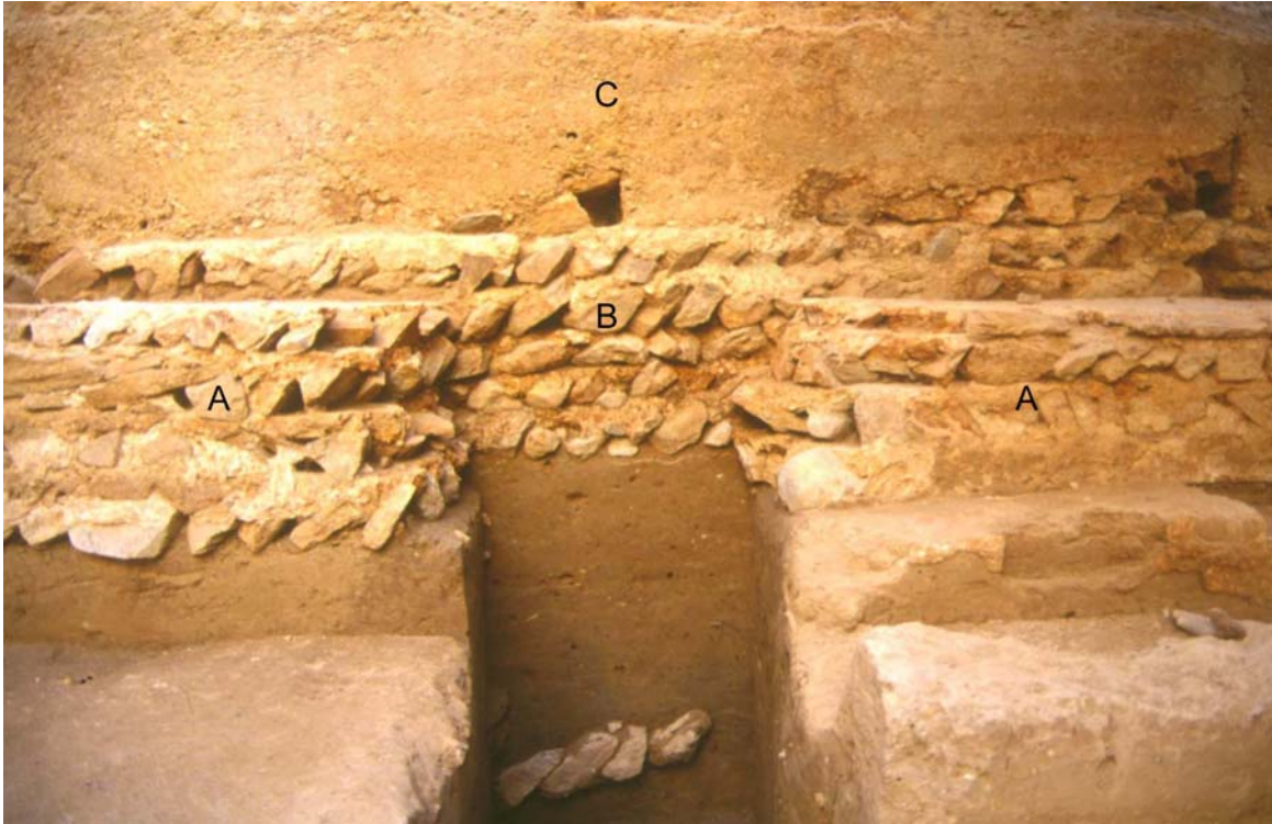
Fig. 73. Murcia. Casón de Puxmarina. Medianería conformada por dos muros adyacentes con cimentación de mampostería (s. X). El proceso de formación es el siguiente: 1º Se construye el muro A. 2º Al muro A se le adosa el B. 3º Los propietarios del inmueble más antiguo eliminan el muro A y dejan como medianería el B, ganando así la superficie de la estructura desaparecida. 4º Finalmente el alzado de tierra del muro B fue sustituido por una nueva estructura (C) de tapial de hormigón (ss. XII-XIII)
