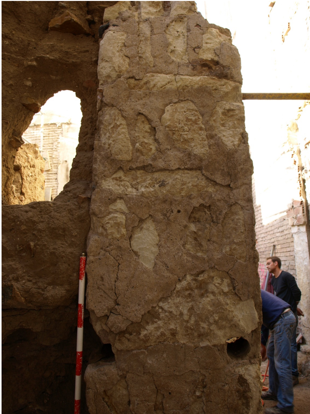
Fig. 150. Murcia. Machón de sillarejos de calcarenita tomados con argamasa que reforzaba la parte central del frente de un torreón en calle Nicolás Ortega (García Ruiz, 2012, p. 49)
