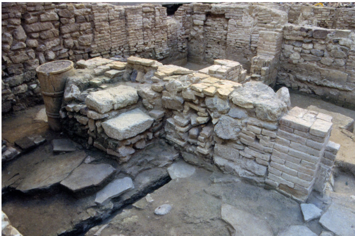
Fig. 316. Platería, 31-35. Casa 1. Escalera situada en la crujía sur, en donde también se sitúa el zaguán (Ramírez Águila y Martínez López, 1999)
