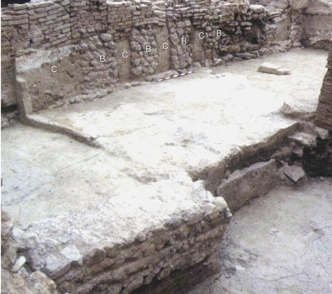
Fig. 81. Murcia. Casa 2 de plaza Belluga de Murcia (ss. X-XI). Salón norte. Obsérvese en la medianera del fondo las reparaciones realizadas con sucesivos bataches de mampostería (B) que dejan entre si angostos tramos del alzado original de tierra (C).
