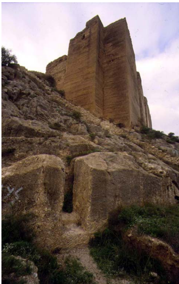
Fig. 40. Castillo de Monteagudo. En primer plano, la puerta de codo tallada en la roca; al fondo, la esquina nororiental del bastión superior
