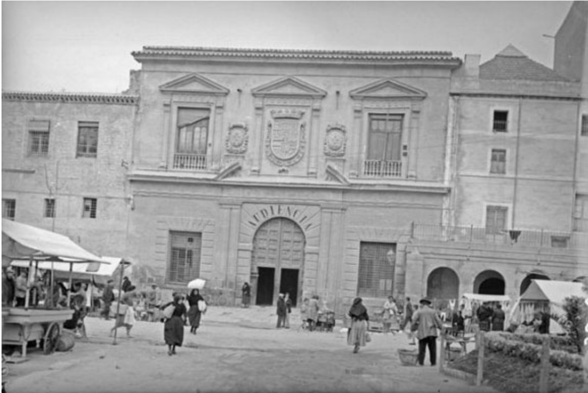
Fig. 124. Murcia. Edificio del Almudí. El cuerpo de la derecha, cerrado por una cubierta a cuatro aguas, es un antiguo torreón de grandes dimensiones
