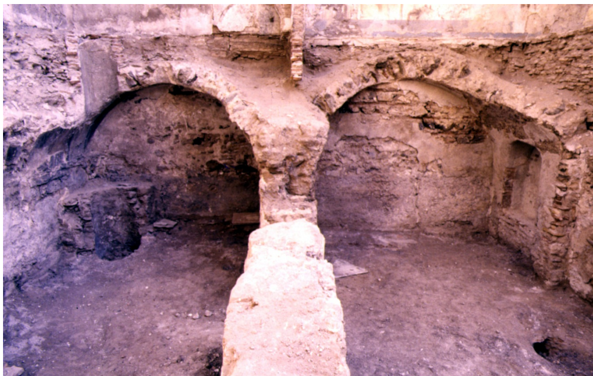
Fig. 180. Baño de San Antonio. Bóvedas de las salas templada y caliente
