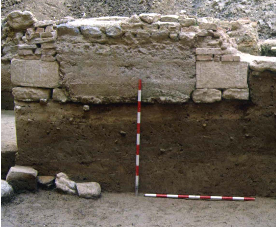
Fig. 84. Murcia. Casa A de calle Platería, nº 14 (s. XII). Muro construido con cimentación de tapial de hormigón y solución mixta en las jambas: cimentación de sillares y alzado de ladrillos (Jiménez Castillo y Navarro Palazón, 1997)
