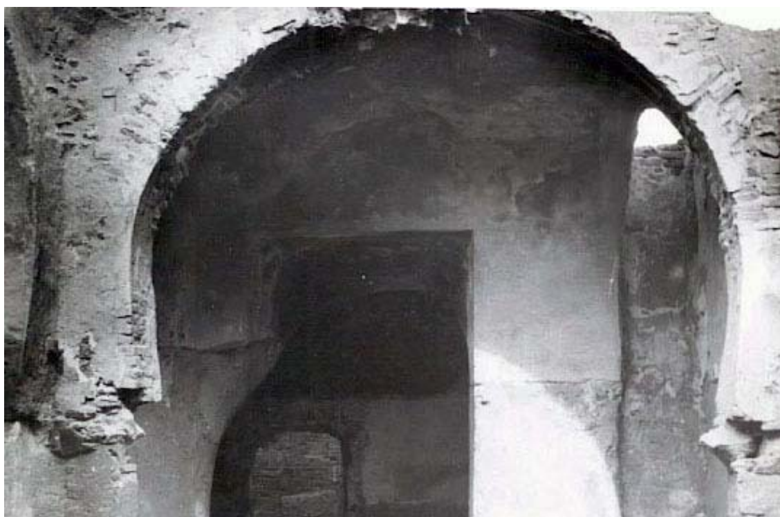
Fig. 174. Baño de Madre de Dios, detalle de uno de los arcos de la sala de reposo
