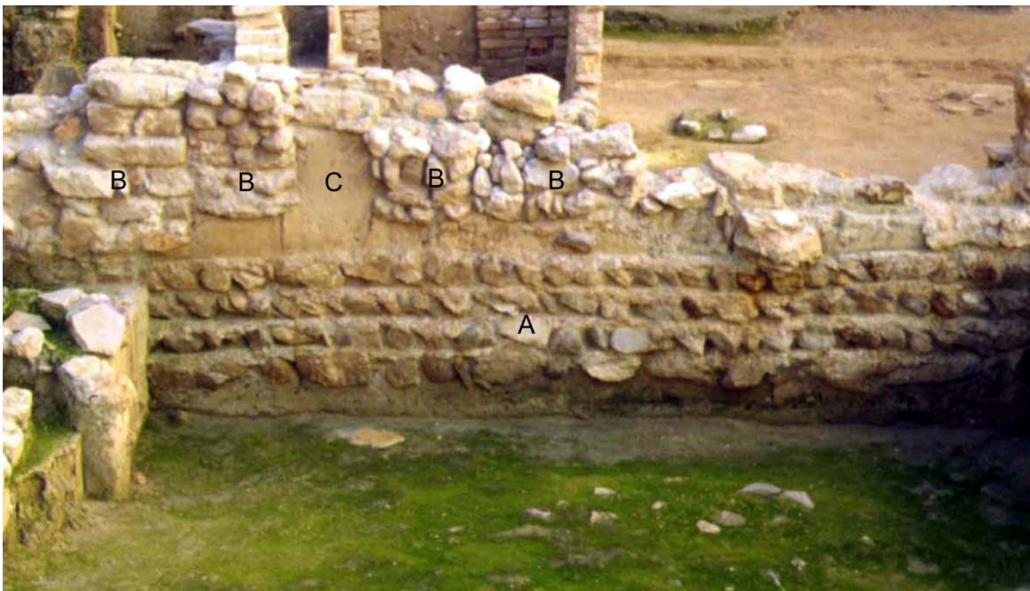
Fig. 80. Murcia. Casa 2 de plaza Belluga. Muro medianero entre dos viviendas andalusíes. Obsérvese el cimientto de mampostería de la obra original (A) y las reparaciones realizadas con bataches de mampuestos (B) de casi todo el antiguo alzado de tierra (C)
