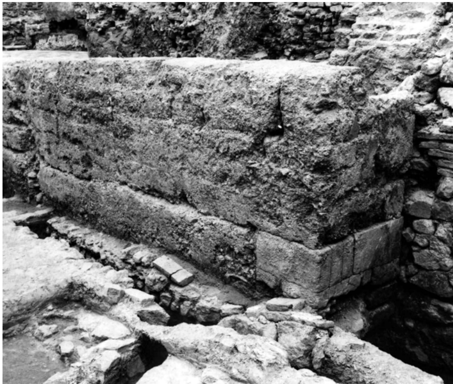
Fig. 86. Casa excavada en el solar del casón de Puxmarina de Murcia (ss. XII-XIII). Véase en el muro de tapial de hormigón cómo ha sido reforzada su esquina con sillares de calcarenita (Jiménez Castillo, Navarro Palazón y Thiriot, 2005)
