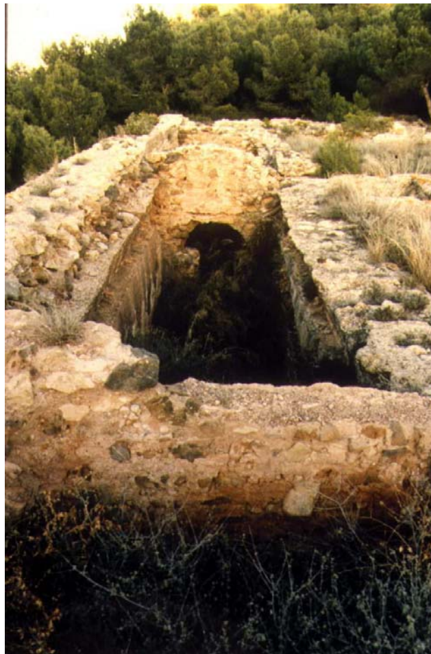
Fig. 98. Murcia. Recinto superior del Portazgo. Tercer cuarto del siglo XII. Obsérvese en la parte superior de la obra de hormigón el retalle para apoyar la bóveda de ladrillo que debía cubrir la crujía
