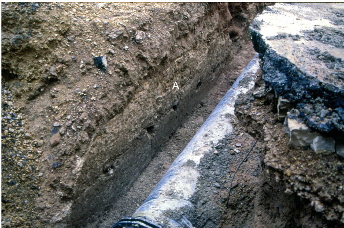
Fig. 210. Restos de un muro de tapial de hormigón (A), presumiblemente del patio de la mezquita, hallado en la Plaza de la Cruz
