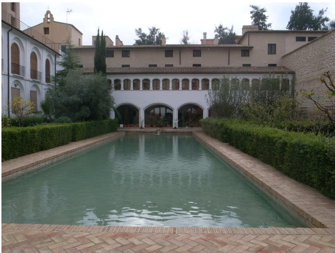
Fig. 359. El Alcázar Seguir. Estado actual del patio
