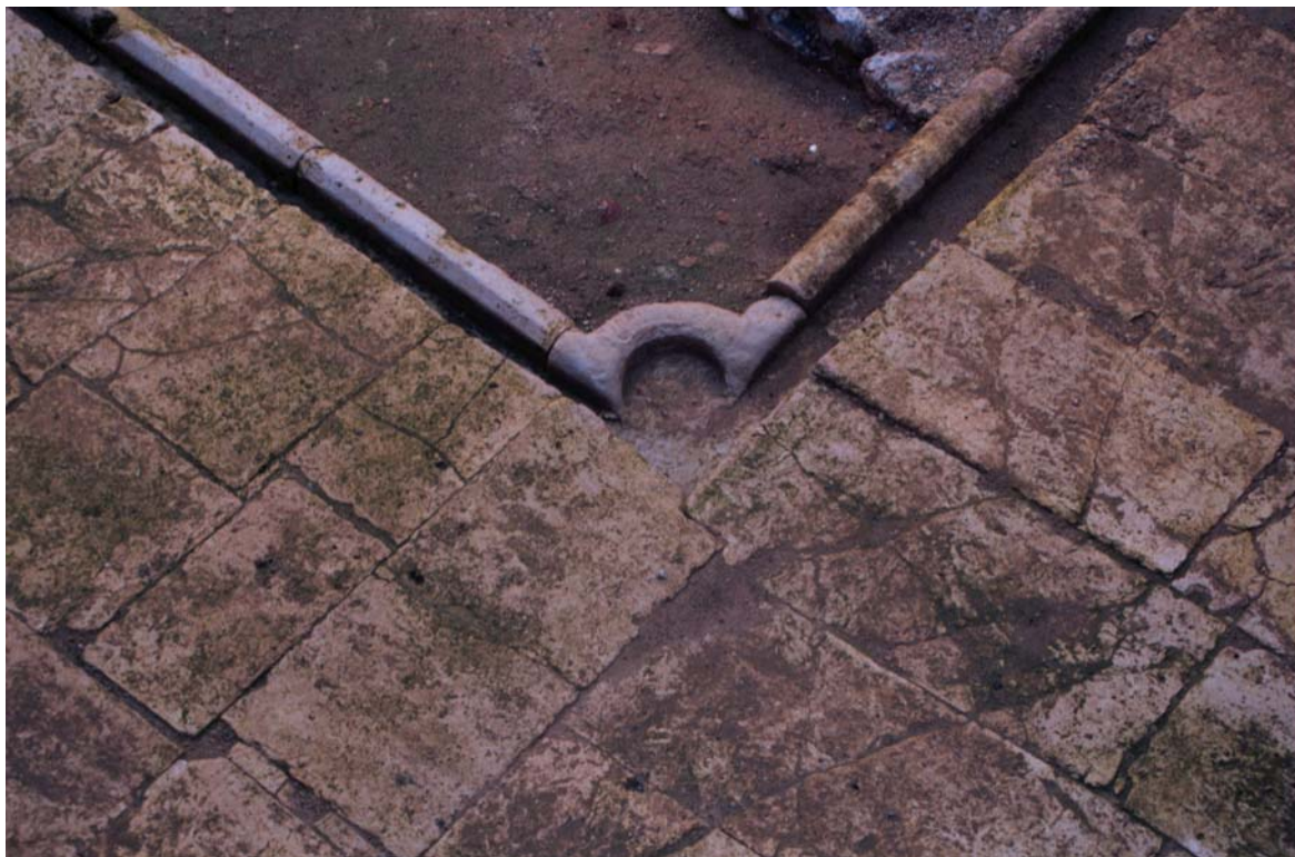
Fig. 161. Orihuela, calle Hospital. Visión parcial del patio de una casa andalusí. Obsérvese el canalillo perimetral conformado por piezas de piedra labrada; las de los ángulos eran de forma ultrasemicircular para reforzar los puntos en donde caían las aguas de lluvia recogidas en los tejados
