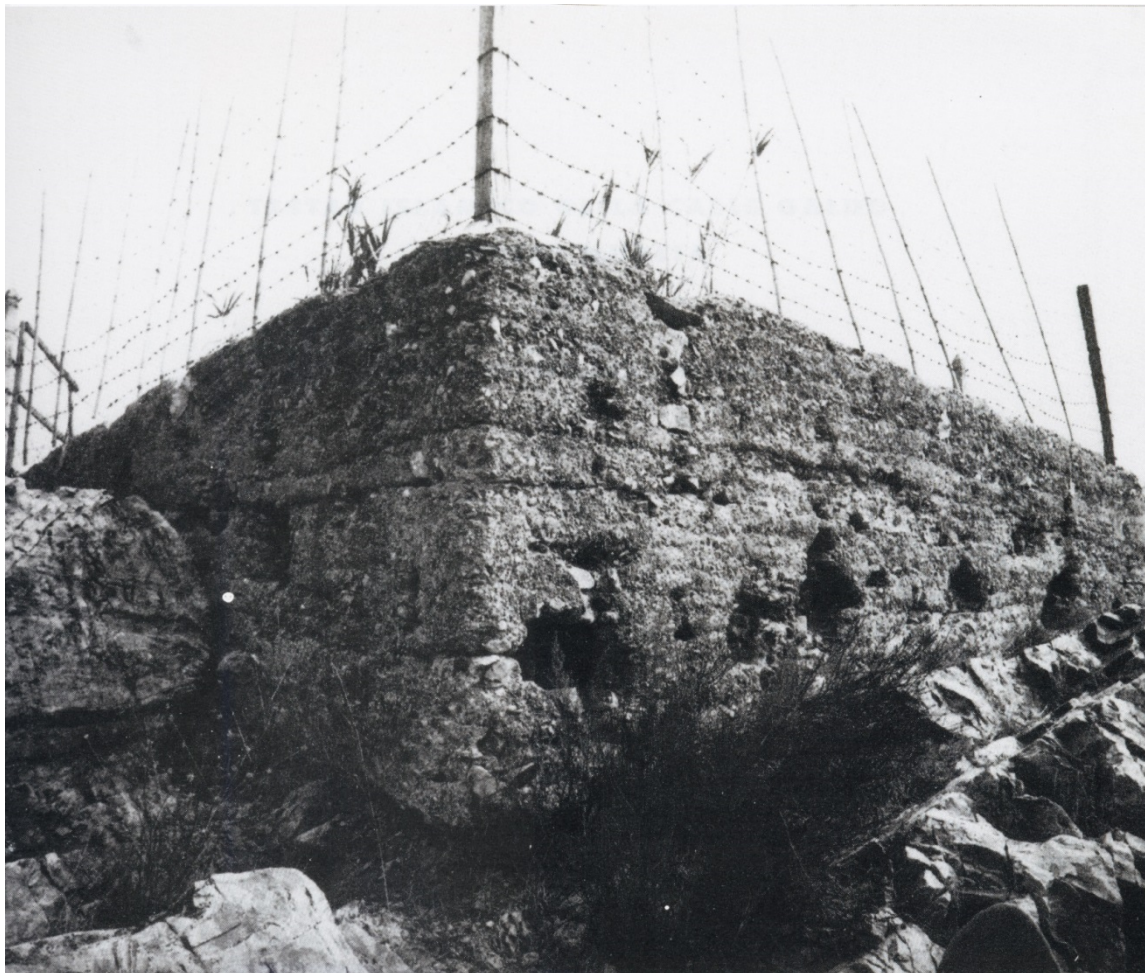
Fig. 67. Uno de los torreones del edificio fortificado de Cabezo de Torres
