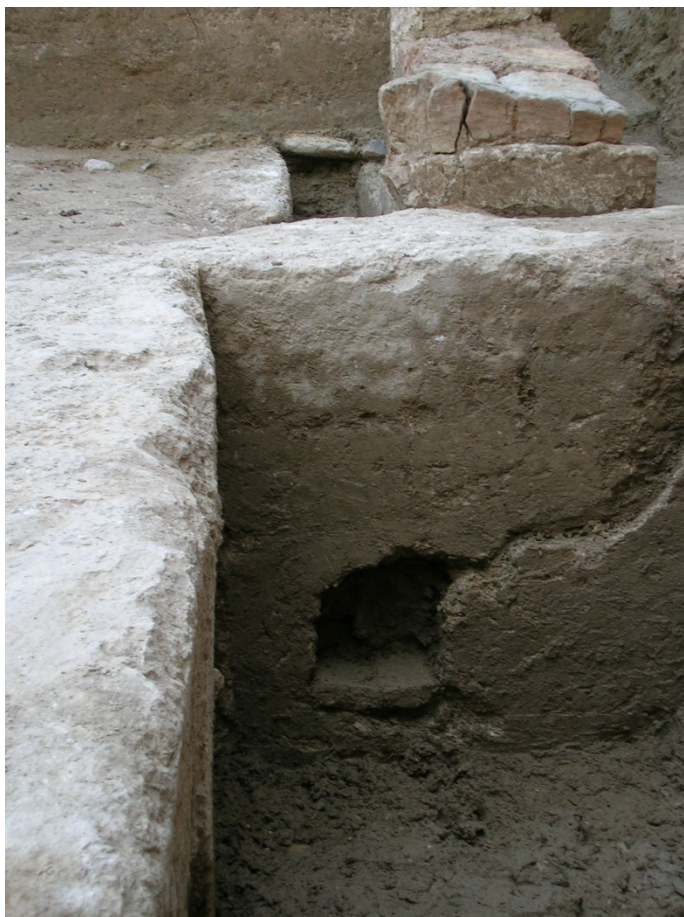
Fig. 337. Palacio de San Andrés. Detalle del ángulo NE del arriate del núcleo 3. Obsérvese la boca de la atarjea y, sobre ella, el canalillo de desagüe (Jiménez Castillo, 2010)
