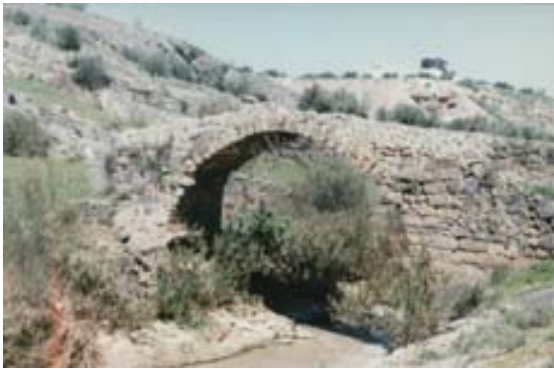
Fig. 342. Puente medieval de posible origen romano sobre el río Víboras. Tucci-Sonsotingi. Fotografía autor.
