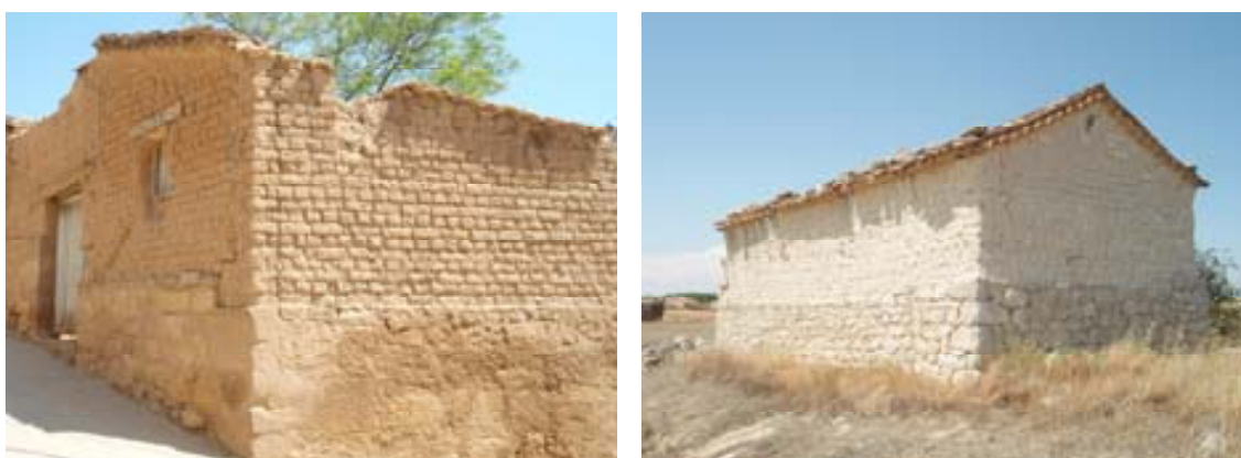
Figs. 151 y 152. De izda. a dcha. Morón de Almazán y Señuela en Soria). Se observa la base de piedra y sillares más o menos trabajados y el alzado realizado a base de adobes secados al sol. Fotografías autor.
