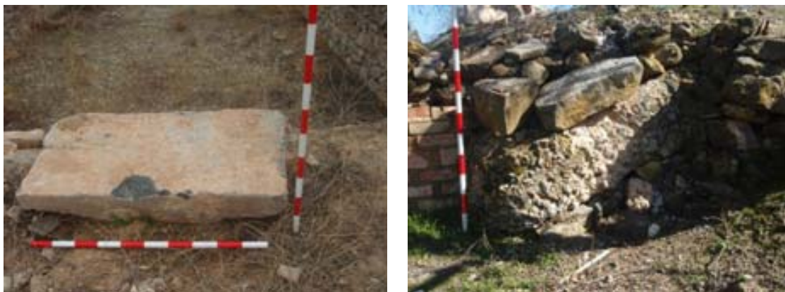
Fig. 367 a 372. Aspecto general cortijo Largo Depósito de agua y canalizaciones con diversos elementos romanos insertados en la construcción. Martos. Fotografías autor.
