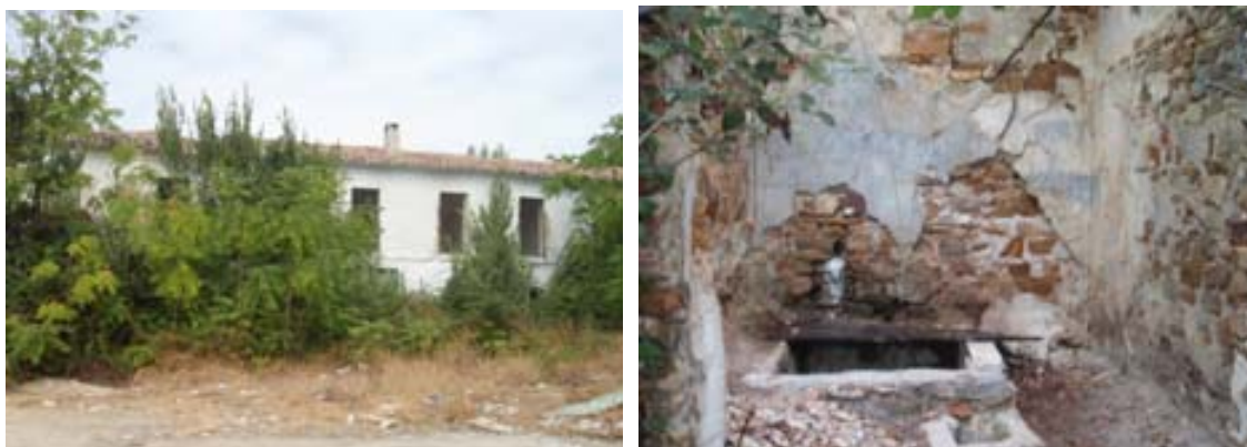
Fig. 358 y 359. Alojamientos abandonados y nacimiento de agua. Baños del agua Hedionda. Martos. Fotografías autor.
