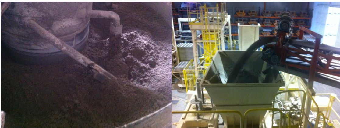
Figura 17. Amasado del hormigón y alimentación al equipo de vibrocompactación
