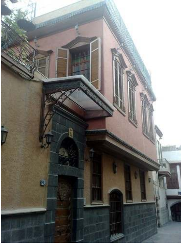
Fig.5. 24. Damasco. Casa rehabilitada
