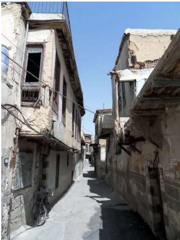
Fig.5. 19. Damasco. Estado ruinoso de las casas (Fakoush.B)
