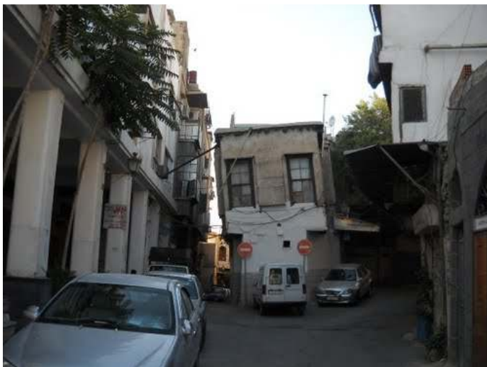
Fig.5. 15. Damasco. Estado ruinoso de las casas (Fakoush.B)
