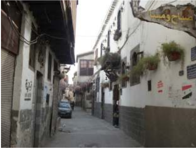
Fig.5. 22. Damasco. Calle rehabilitada
