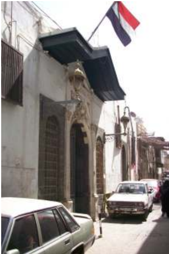
Fig.3. 28. Casa Anbar, Entrada principal
