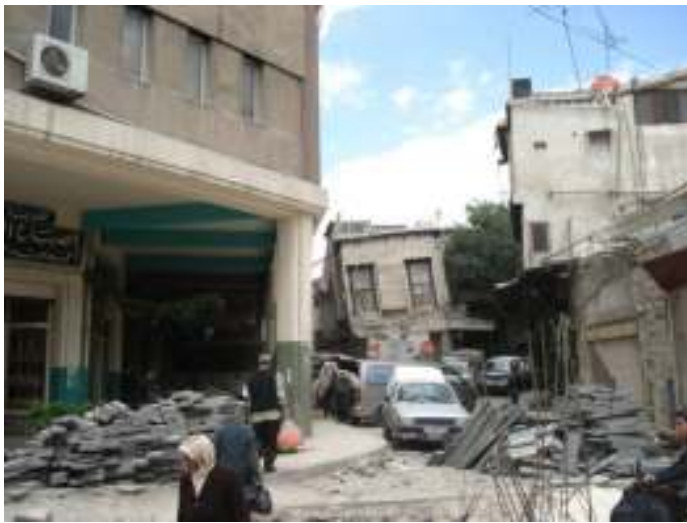
Fig.5. 14. Damasco. Estado ruinoso de las casas (Fakoush.B)
