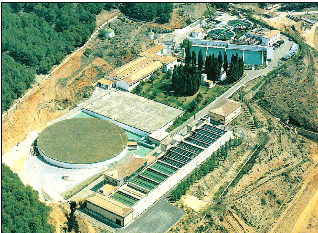
Figura 3.3: Estación de tratamiento de agua potable (ETAP)
