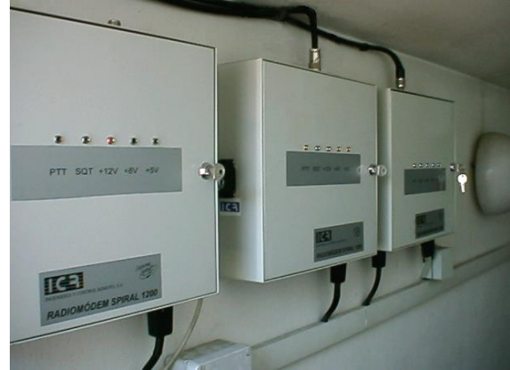
Figura 4.10: Instalación de radiomodem centrales
