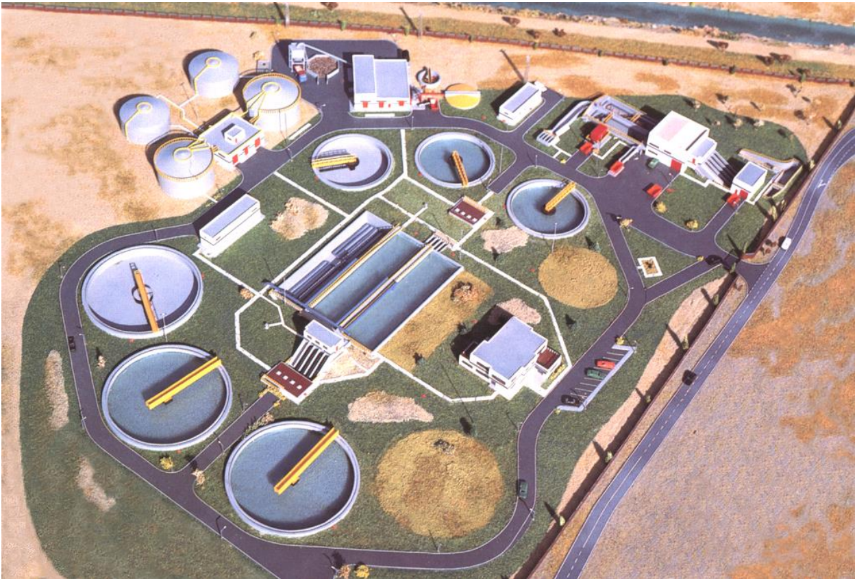
Figura 3.6: Estación depuradora de aguas residuales (EDAR)
