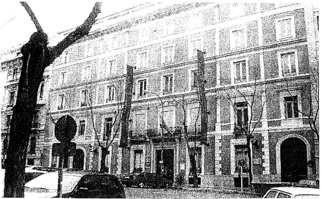
Figura 1: Sede de la antigua Escuela de Estudios Superiores de Magisterio en Madrid (Fuente: A. Molero 2000:32)
