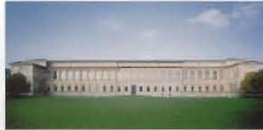
La Alte Pinakothek en su estado actual, la reconstrucción se integra en el conjunto manifestando las situaciones de sutura que marcan el límite entre parte original y parte reconstruida. Foto del autor.
