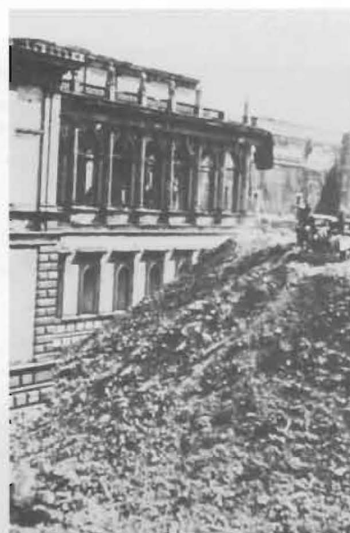
La Alte Pinakothek de Munich en 1945. Una montaña de escombros provenientes del centro de Munich se apilaban en los parterres de la fachada sur de la Pinakothek. La cadena de vagonetas instalada provisionalmente para el desescombro finalizaba en ellos, apoyando el talud de escombros en las fachadas del museo Bauer, Richard. "Ruinen-jahre, Bilder aus dem Zerstörten, München 1945-1949". Hugendubel, München, 1983.
