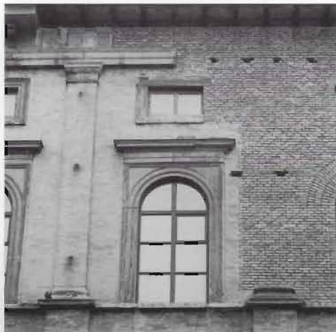
Fachada norte (trasera). La fábrica de ladrillo proveniente del desescombro consigue una matización "degradada", como barnizada por el paso del tiempo. Peter, Franz y Wimmer, Franz, "Von den Spuren. Interpretierender Wiederaufbau in werk von Hans Döllgast". München, 2000.
