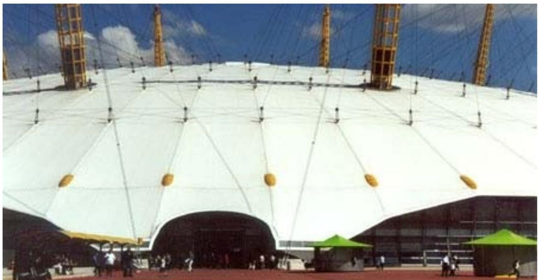
Fig. 2.5: Estructura tensada cerrada. Cúpula del Milenio, Londres (Reino Unido)
