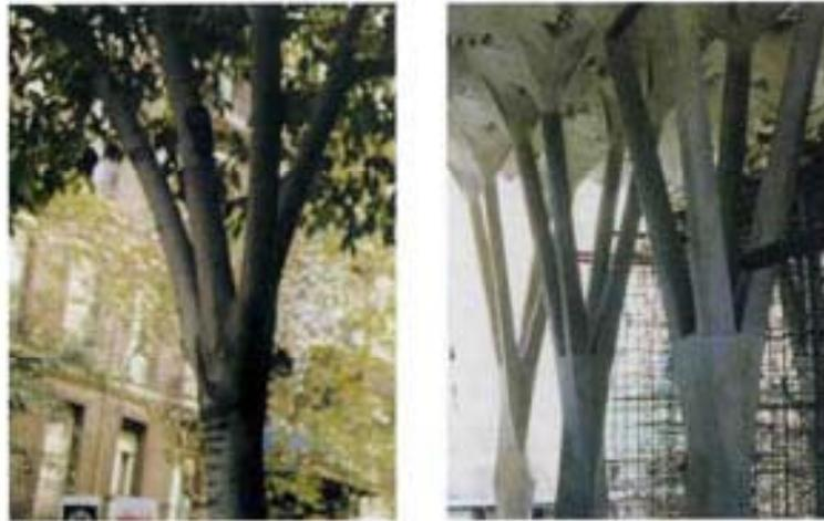
*Fig. 2.33: Pilares arbolados con formas catenarias.*
