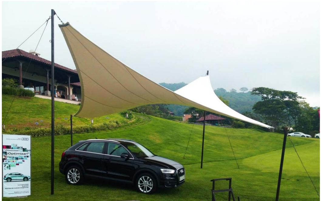
Fig.2.6: La estructura anticlástica más simple: Velaria de cuatro puntas, forma de silla de montar
