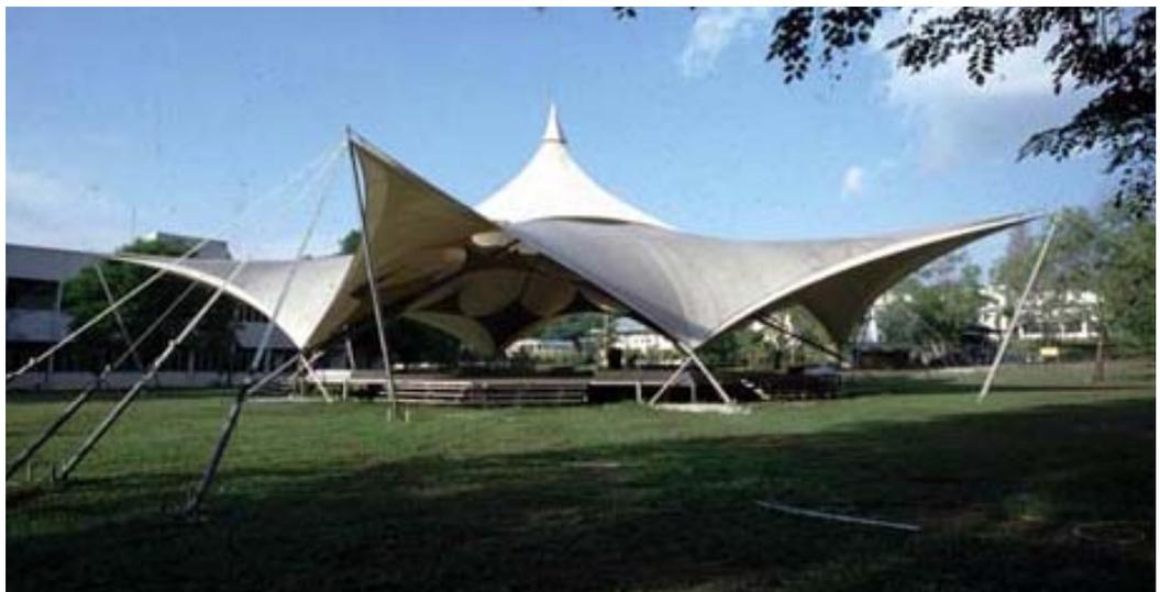
Fig. 2.4: Estructura tensada abierta. Proyecto "Assembly tent". Malasia
