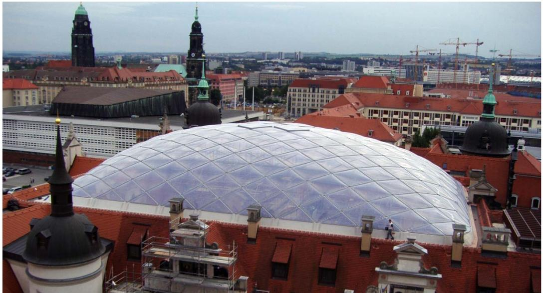
Fig. 2.19: Cubierta de elementos hinchados del Castillo de Dresde. Form T.L. Dresde (Alemania)
