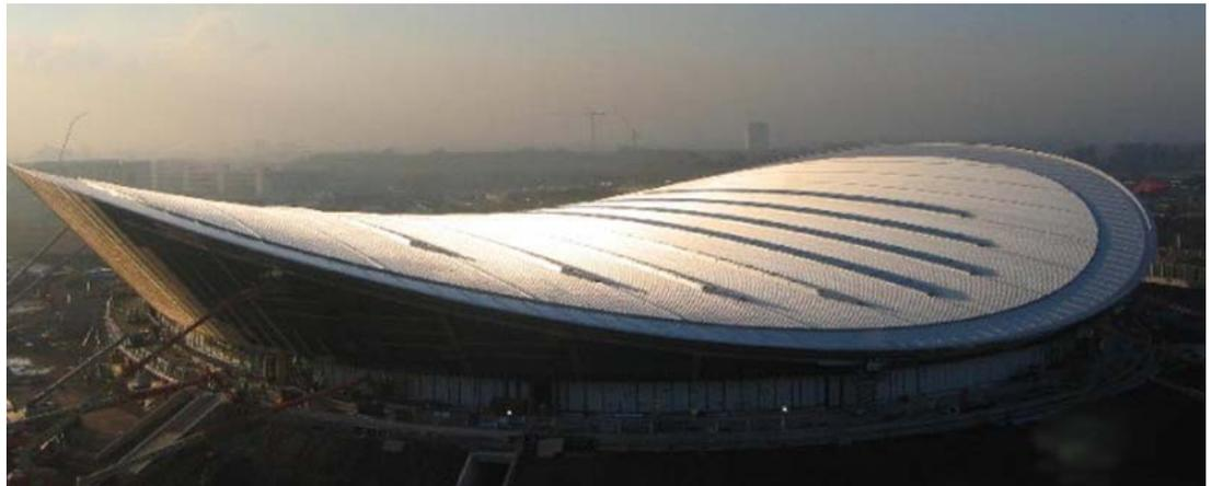
*Fig. 2.21: Velódromo de Londres para las olimpiadas de 2012. Hopkins architects. Londres (Reino Unido) Malla de cables cerrada (elíptica) con doble curvatura que sustenta los paneles.*
