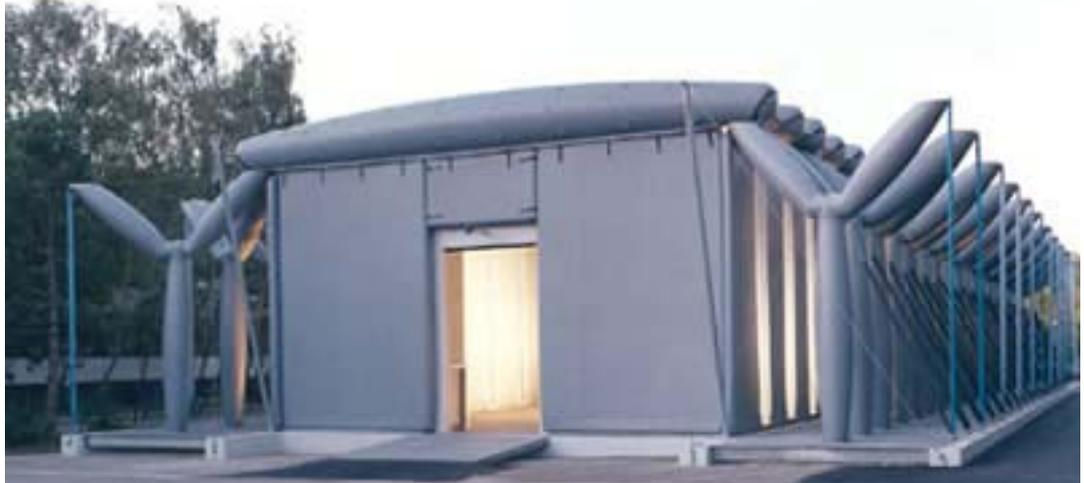
Fig. 2.18: Estructura soportada por aire Airstructure Exhibition Hall. Festo AG & Co. Esslingen (Alemania)
