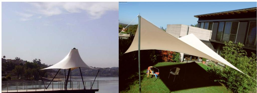
Fig. 2.9: Variantes de dos formas simples: Conoide (izqda..) y Paraboloide hiperbólico (derecha).
