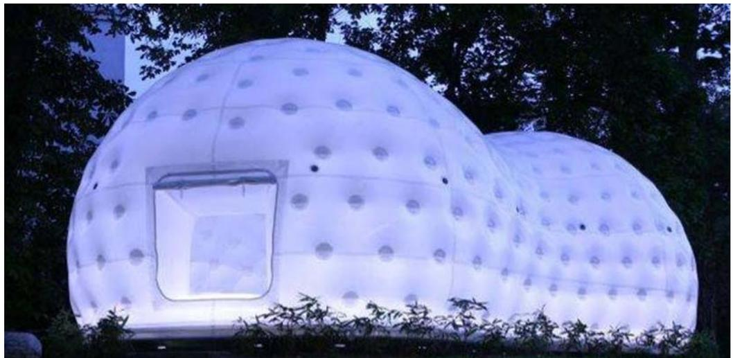
Fig. 2.7: Estructura neumática sinclástica: Modern Teahouse 2007. Frankfurt/Main (Alemania)
