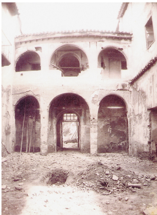
Fig. 6. Derribo de la Casa de los Infantes de Almería (1901).
