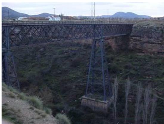
Los otros puentes estaban en una fase muy avanzada. El puente más importante era el que salvaba el arroyo de Gor, con un vacío de 230 m, sus características eran que constaba de tres tramos metálicos que medían 252 m, apoyados en dos estribos de 21 m de altura sobre 11 y 12 de cimentación sostenido por dos pilas metálicas de igual altura, que se asentaban sobre basamento de sillería.
