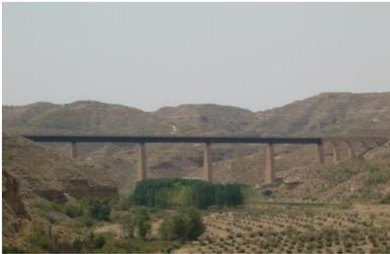
El puente sobre el río Fardes quedaba compuesto de dos tramos metálicos de 31,20 m cada uno. En su construcción el macizo de hormigón del estribo de la derecha, que se hincaba por air comprimido, se rompió, lo que dio motivo a la demolición del trozo desprendido y su sustitución por otro.
