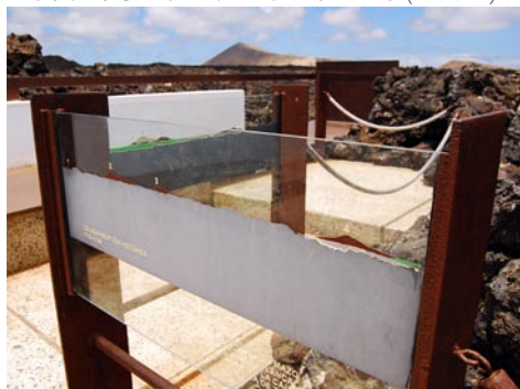
FIG. 815. D.3. CENTRO DE VISITANTES MANCHA BLANCA (TIMANFAYA). ●
