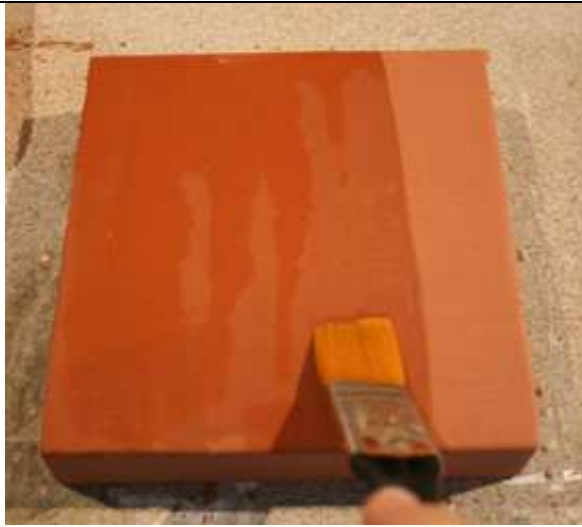
Humectación de la superficie.
