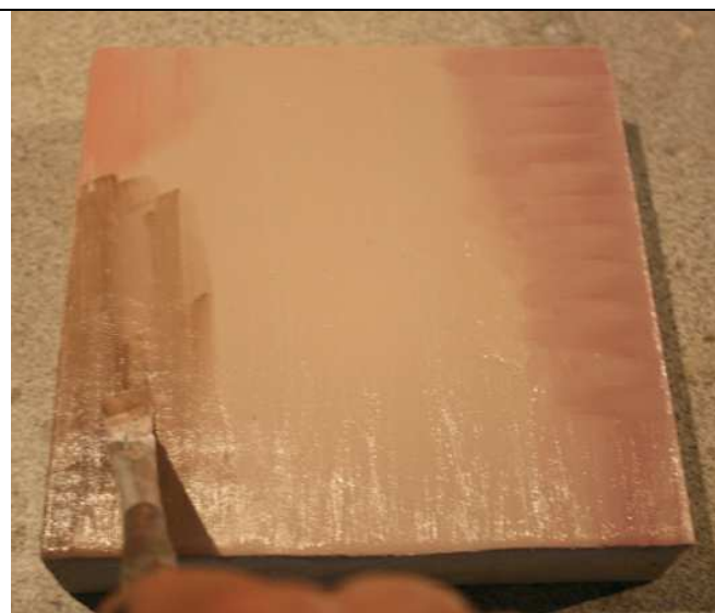
FIGURA 59. APLICACIÓN DE SEGUNDA CAPA DE ÓLEO Y MATIZ DE COLOR
