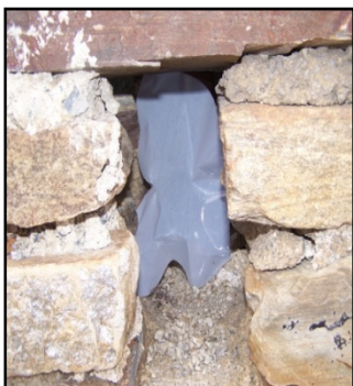
Figura 67. Papel adhesivo colocado en interior de barbacana.
