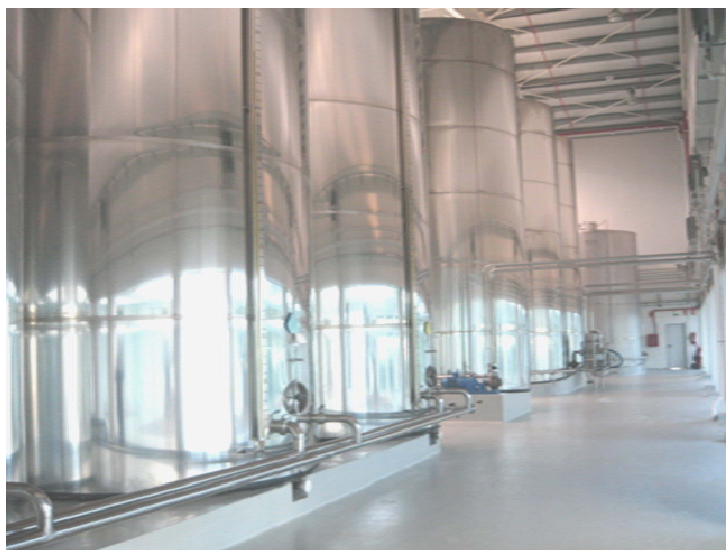
Figura 15. Bodega de almacenamiento de aceite con tanques de capacidad para 100.000 kg de aceite.
