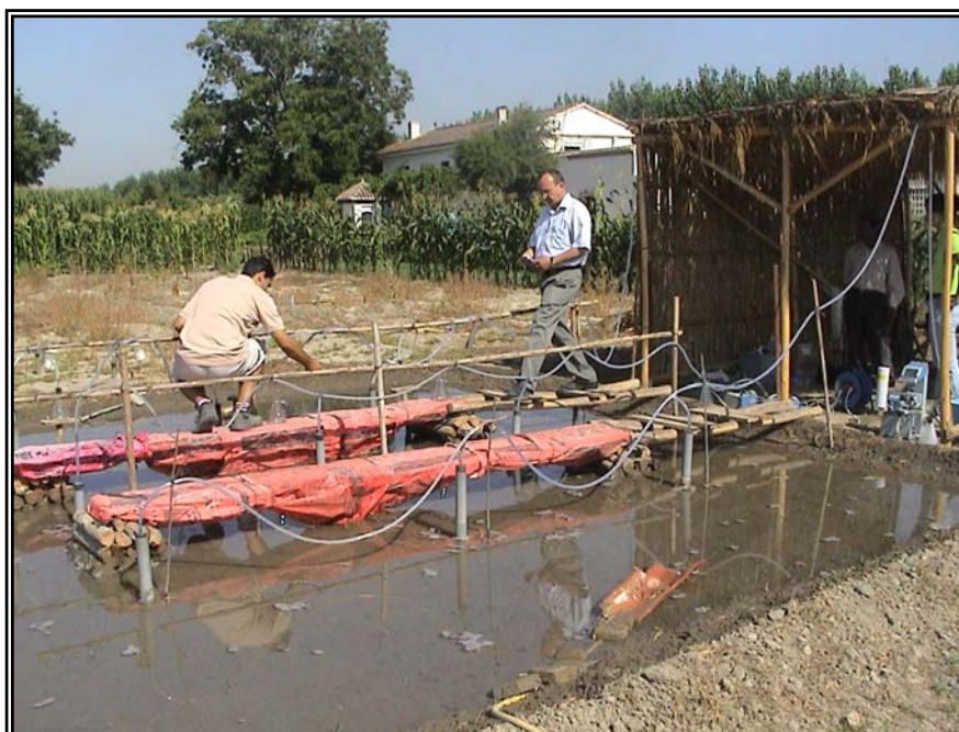
Figura 3.36 - Vista general de las parcelas experimentales.
