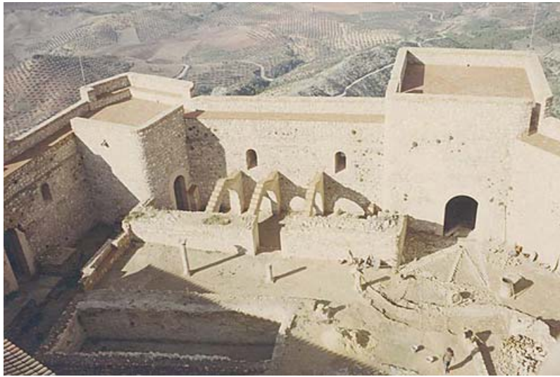
Últimos trabajos en el patio de armas (Dic. 1968). Fuente: Ministerio de Cultura. Archivo General de la Administración. Fondo Ministerio de la Vivienda, IDD (04)117.004, Caja 51/11845.
