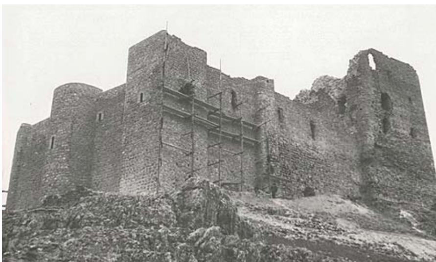
Trabajos en el exterior de la fortaleza. Fuente: Ministerio de Cultura. Archivo General de la Administración. Fondo Ministerio de la Vivienda, IDD (04)117.004, Caja 51/11845.
