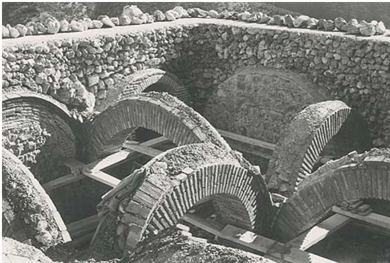
Arranque de las bóvedas en la segunda planta de la Torre del Homenaje (Nov. 1965). Fuente: Ministerio de Cultura. Archivo General de la Administración. Fondo Ministerio de la Vivienda, IDD (04)117.004, Caja 51/11845.
