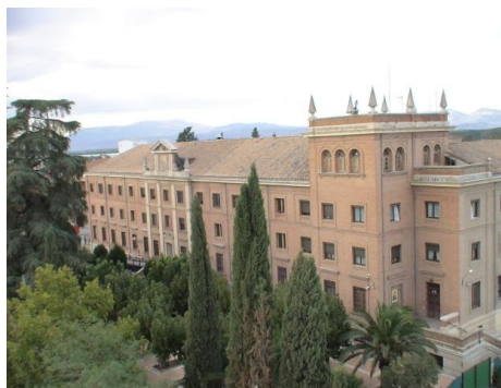
Figura 20. Residencia Geriátrica “Perpetuo Socorro”, Santa Fe (Granada).
