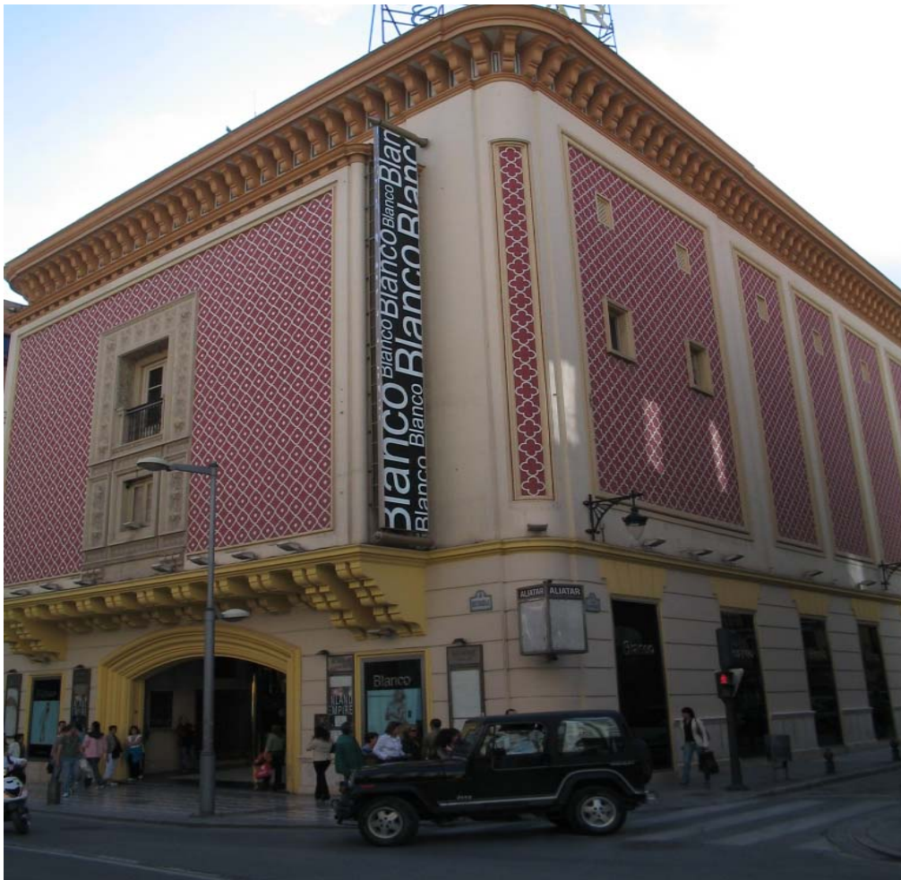
21. Fachada Cine Aliatar, 2007.
