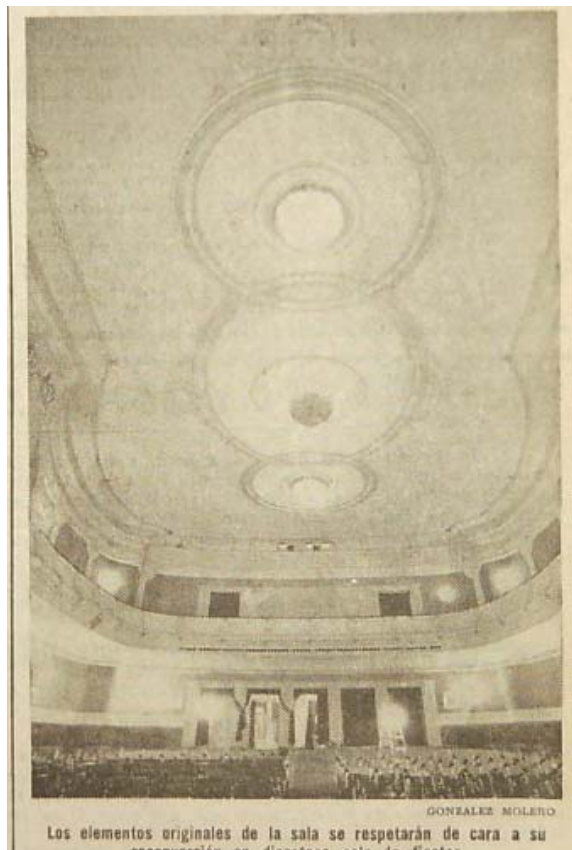
91. Interior del cine Granada antes de las reformas, 1993.
