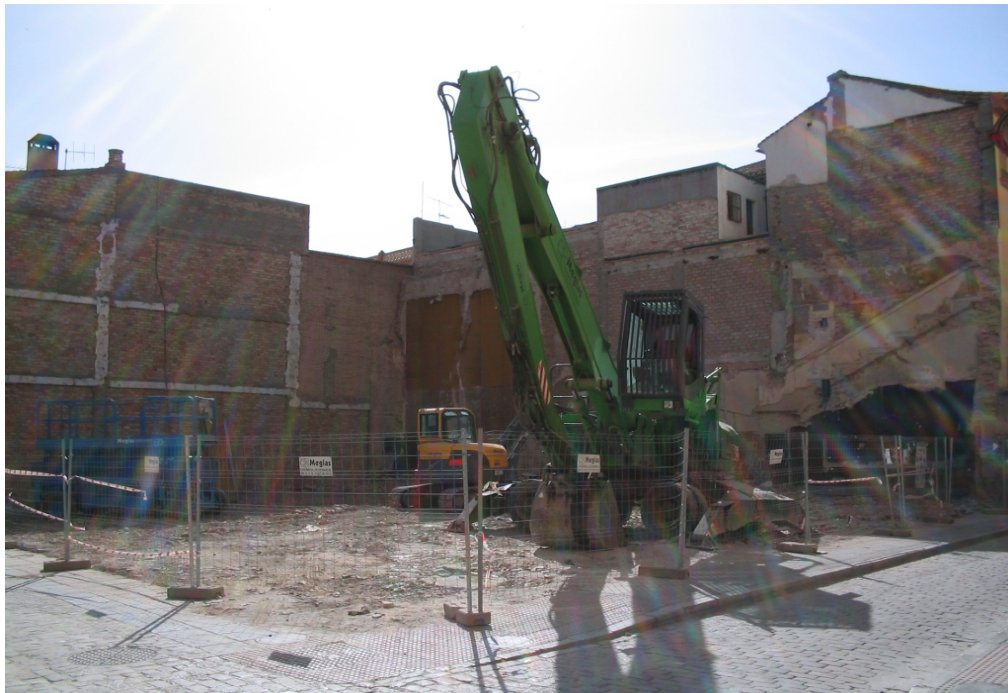
155. Derribo Cine Goya, Junio 2008.
