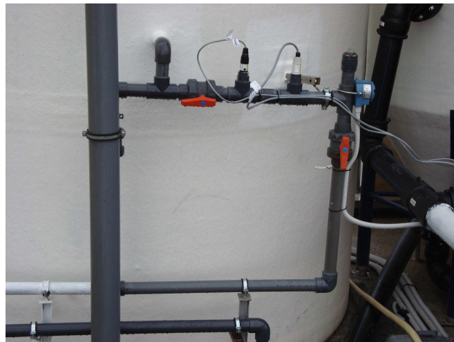
Figura 3.6. Circuito de sensores y bomba de purga.
