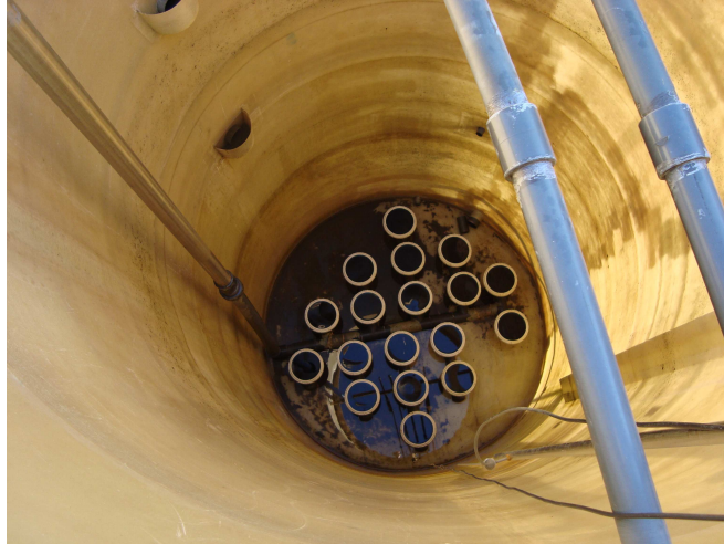
Figura 3.7. Soplante y parrilla de difusores en tanque aireado.
