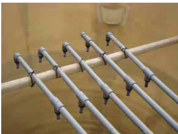
Figura 3.5. Duchas sobre el tanque aireado y detalle de boquilla.
