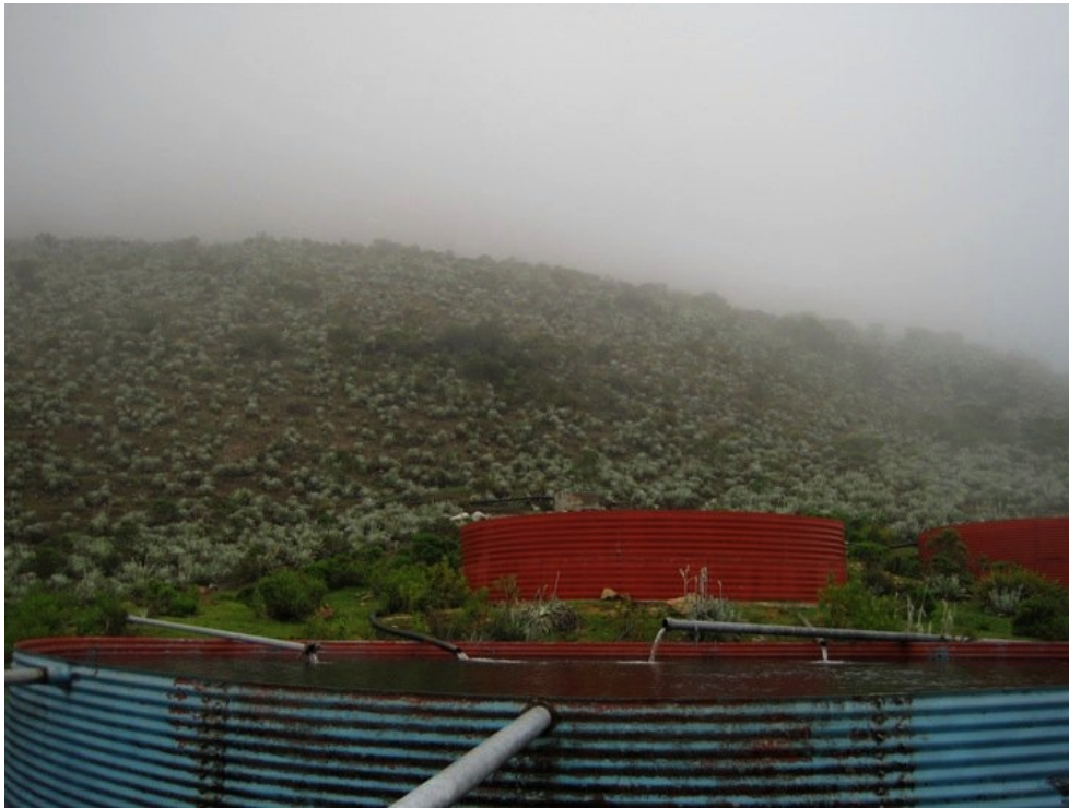
Fotografía 6. Los tanques de agua.
