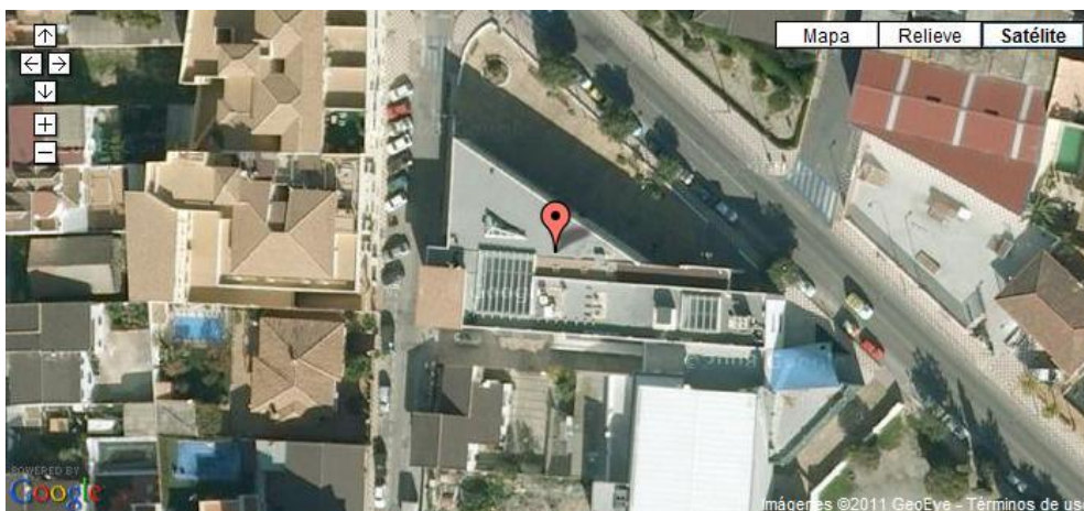
Imagen 6. Vista aérea del Centro Municipal de Cultura de Churriana de la Vega (Fuente: Google Maps)
