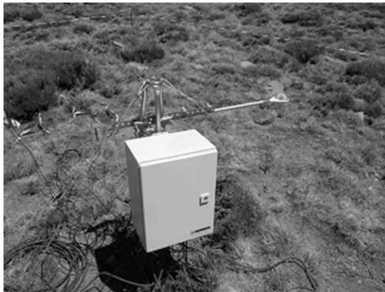
Figura 2.5: Datalogger de la torre de seguimiento energético de la zona experimental de Laguna Seca.
