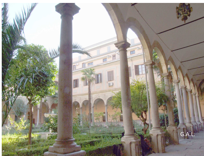
Fig. 8: galería meridional del patio principal que linda con la iglesia.
