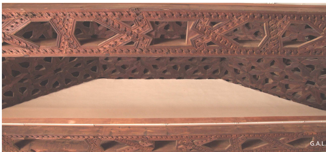
Fig.13: fotografía que recoge la solución dada al extremo perdido simulando terminar en hastial, 2008.
