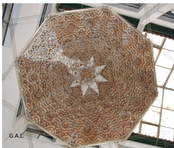
Fig. 244: cupulilla de mocárabes realizada por el Sr. Santiesteban, instalada en la Escuela de Artes Aplicadas y Oficios Artísticos de Granada.
