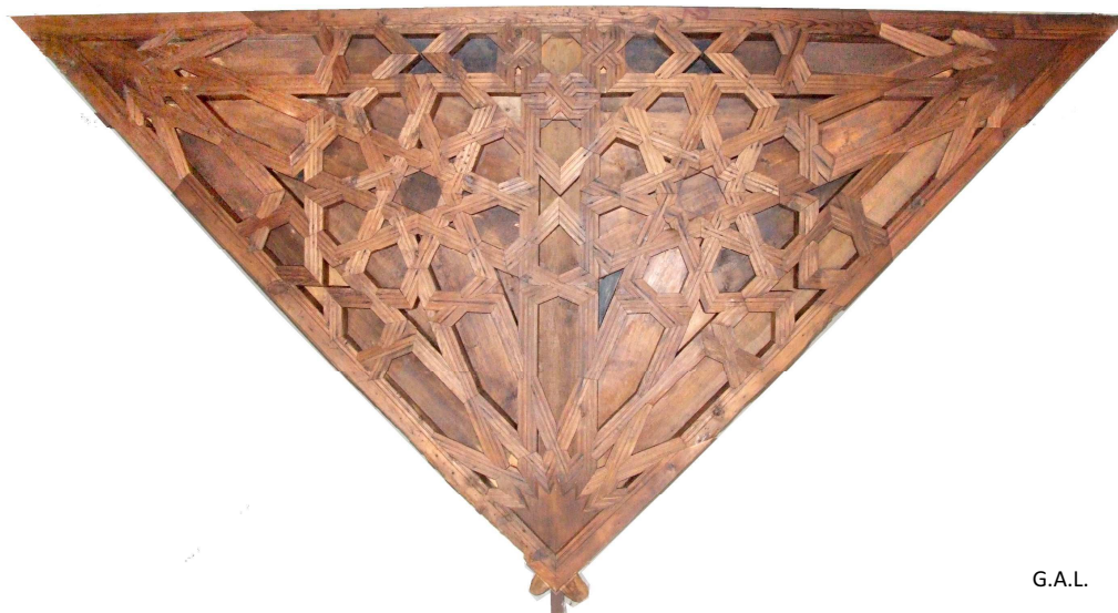
Fig.31: uno de los dos cuadrados que tenía la armadura y que se conservan en el Museo de la Alhambra. 2009.
