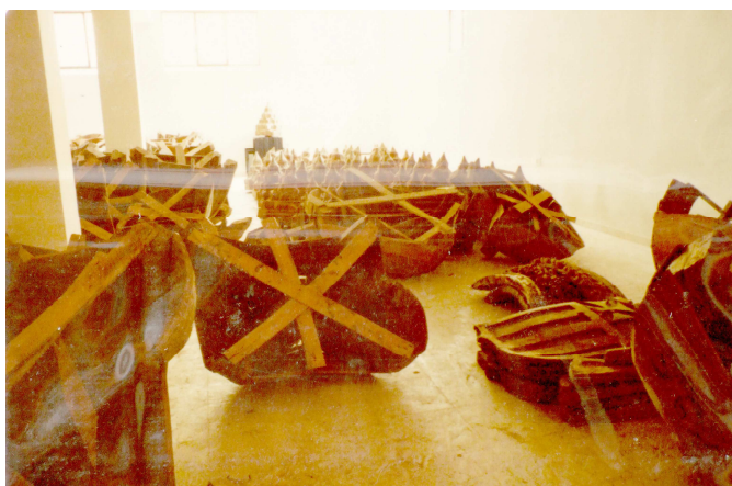
Fig. 23: módulos de los que se compone la armadura, en primer plano vemos los casquetes de cuatro gallones y al fondo las piñas. Fotos del archivo personal de Antonio Fernández Puertas.
