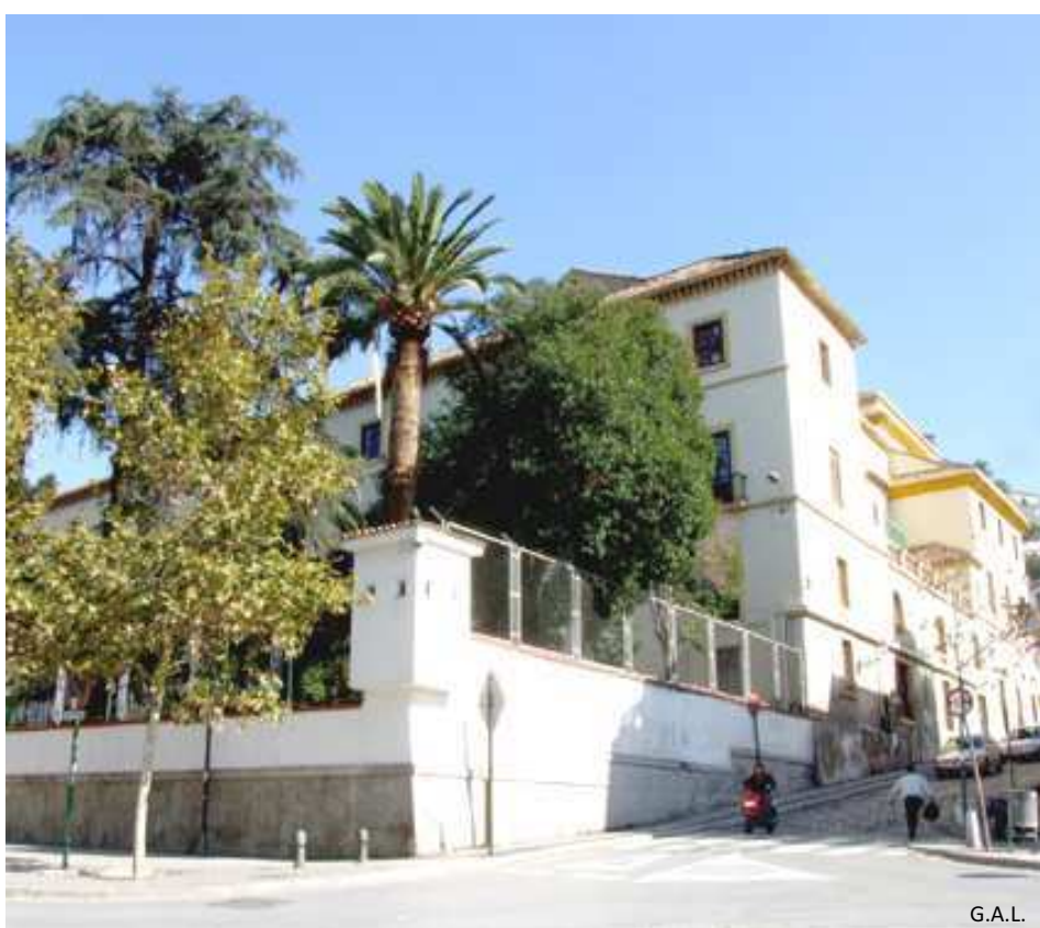
Fig.4: visión actual del convento de la Merced. Esquina donde se ubicaba la elevadísima torre que se derribó en el siglo XIX. La fachada que limita con la calle Cruz de Arqueros corresponde a la construcción de la iglesia; se aprecia la eliminación de cualquier elemento simbólico que recuerde su función original, los añadidos propios del uso militar como son las garitas, la división en pisos y la apertura en la fachada de numerosas ventanas.
