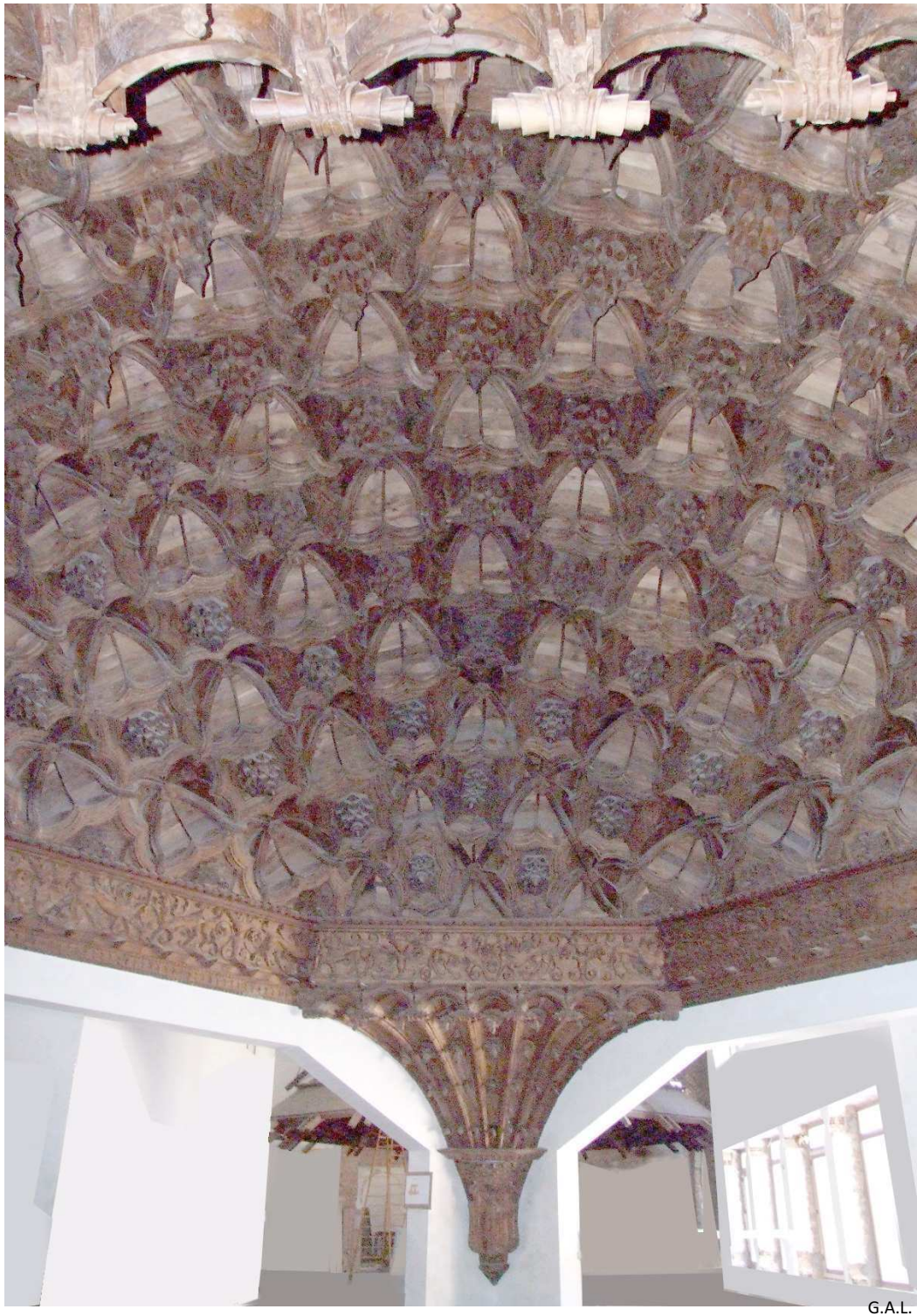
Fig.21: armadura de crucero de la iglesia del Convento de la Merced, instalado en el Museo de la Alhambra. Al fondo, se ve también la instalación de la armadura del presbiterio de misma iglesia. 2008.
