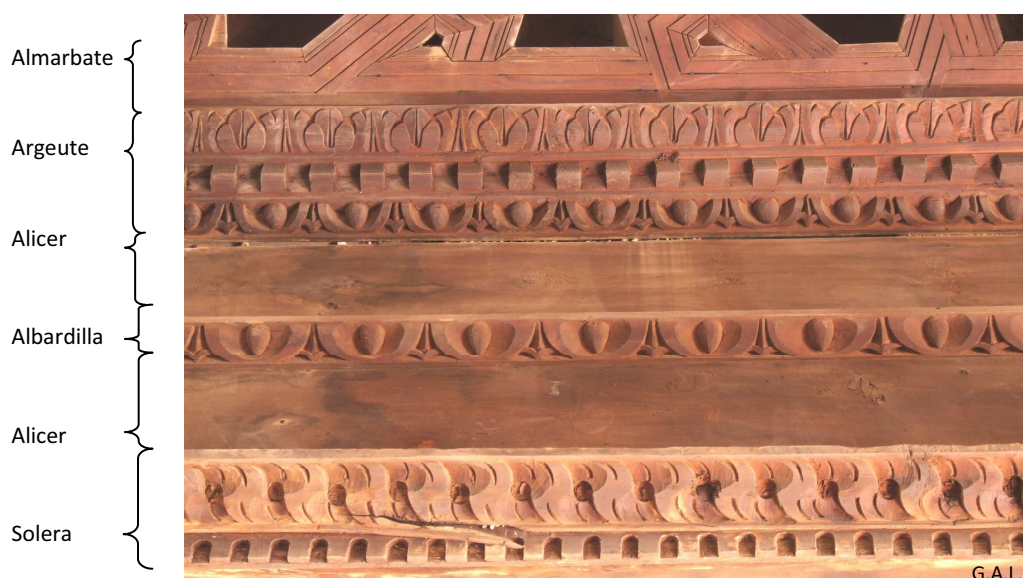
Fig.16: arrocabe de la armadura de la nave. 2008.
