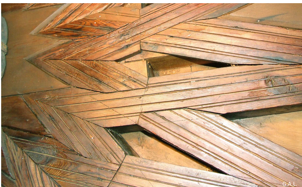
Fig. 36: detalle de trazado del lazo realizado con línea incisa y la ayuda de los cartabones. 2007.
