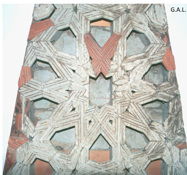
Fig. 19: detalle de uno de los paños conservados donde se observa la rueda de diez y una serie de amputaciones de los taujeles calvados sobre las medias limas. Sorprende la carencia de la calle de limas.
