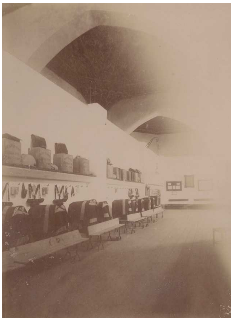
Fig.6: vista de la subdivisión del espacio interior de la nave, destinándose a uso y almacenaje militar. Realizada por Antonio Sancho Hidalgo en el año 1902. AHPG / Comisión de Monumentos / F. 296.
