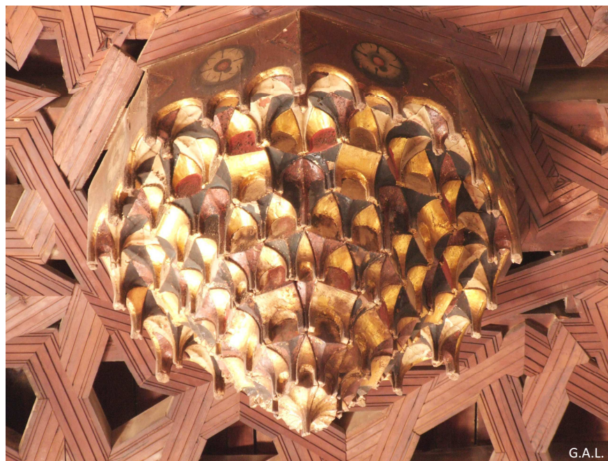
Fig.19: piña de mocarabe situada en el almizate de la armadura de la nave. 2008.
