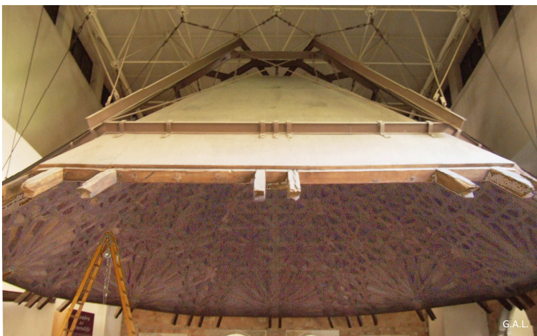
Fig. 30: sistema de instalación de la armadura del presbiterio de la iglesia de la Merced en el Museo de la Alhambra. 2006.
