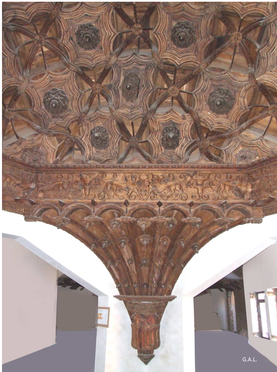
Fig.26: detalle en donde se aprecia la deformación de la trama de casquetes, casetones y piñas para adaptarse a la forma semiesférica y la pechina. 2008.
