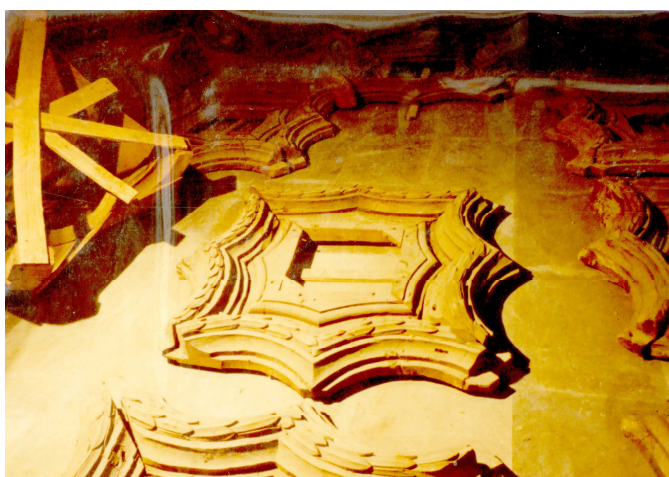
Fig. 24: módulos de los que se compone la armadura, en primer plano vemos los casetones octogonales de lados cóncavos, en su hueco central se introduce la piña de mocárabe para ser sujeta. Fotos del archivo personal de Antonio Fernández Puertas.
