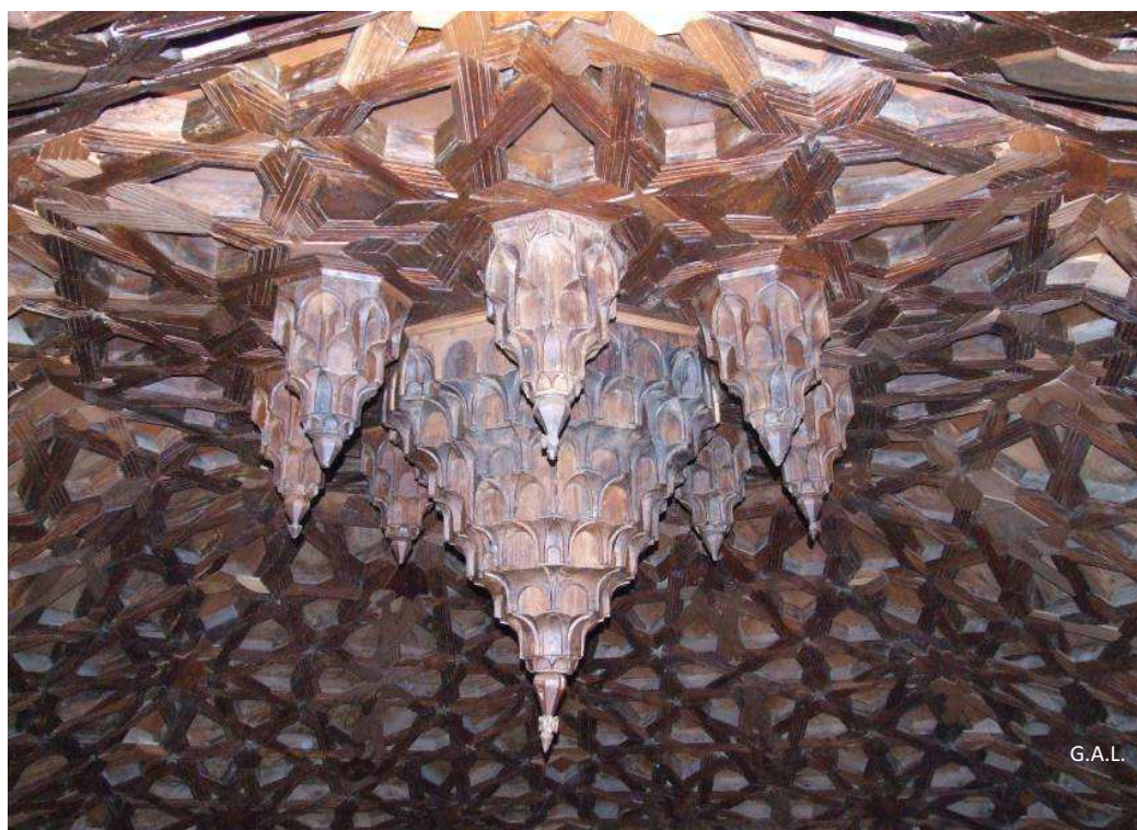
Fig.37: conjunto de piñas de mocárabe del almizate de la armadura del presbiterio de la Merced. 2007.
