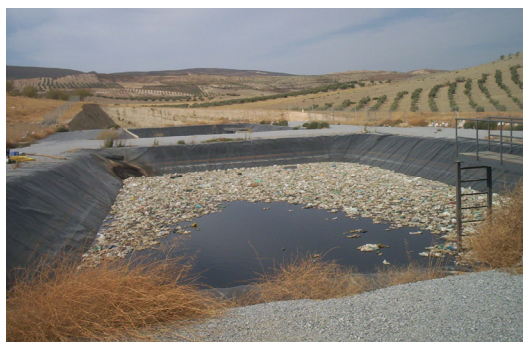
Figura 4.1. Balsa de recogida de lixiviados.
