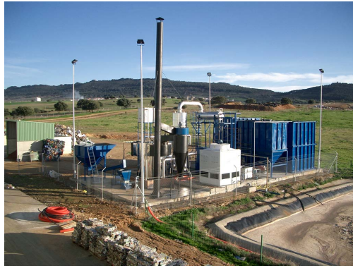
Figura 4.17. Planta de tratamiento de lixiviado de Mirabel.
