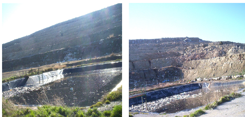
A B Figura 7.2. Balsas de recogida de lixiviados B3 (A) y B4 (B) del vertedero de rechazo de Alhendín (Granada).
