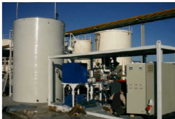
Figura 4.6. Biorreactor de membranas sumergidas.
