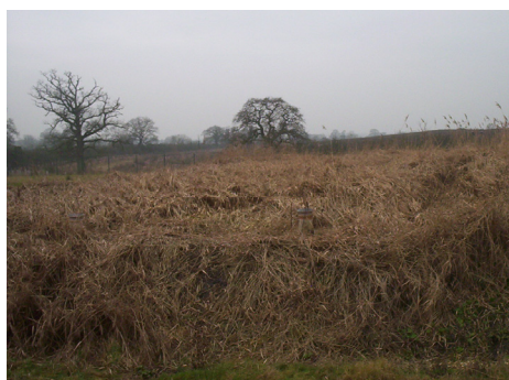
Figura 4.13. Lecho de carrizos utilizado para tratamiento de lixiviado.
