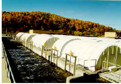
Figura 4.10. Contactores biológicos rotatorios.
