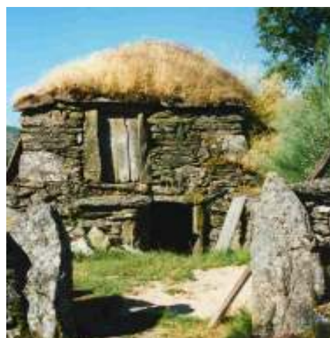
Fotos 100 e 101 - Casas das Brandas de Burzegalinhas, Arcos de Valdevez, e de Santo António de Vale de Poldros, Monção (estrutura de dois pisos, com cobertura em falsa cúpula).
