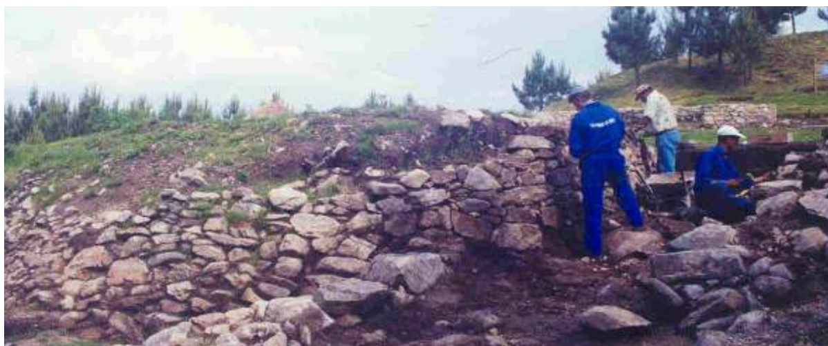
Foto 157 – Trabalhos de restauro da entrada da muralha interna.
