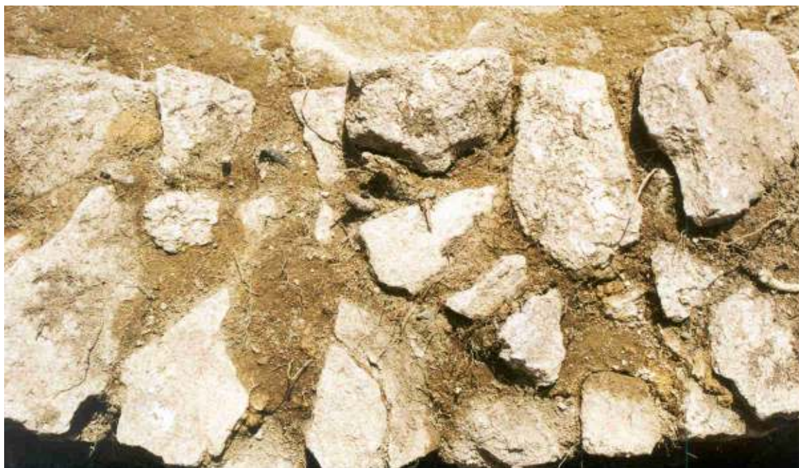
Foto 53 – Estrutura construtiva dos muros das estruturas.
