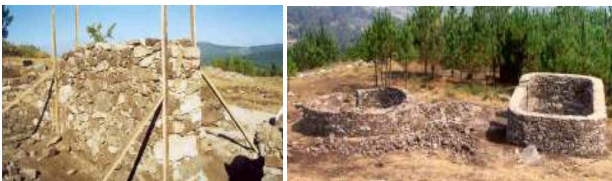
Fotos 140 e 141 – Construção das cabanas-modelo.
