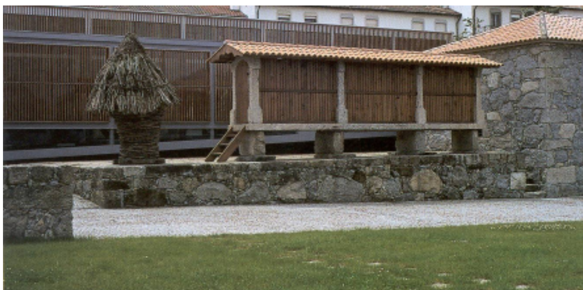
Fotos 177 e 178 – O Museu Regional de Paredes de Coura – vista geral e pormenor do espigueiro e canastro.
