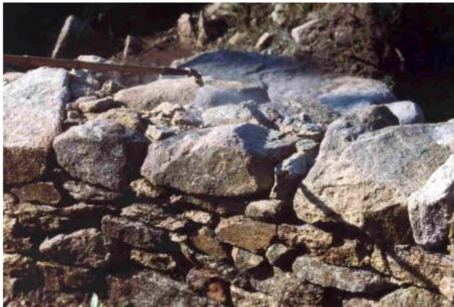
Foto 136 – Tratamento da superfície dos muros com hidrofugante.
