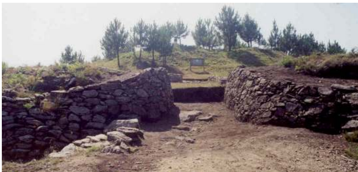
Foto 158 – A entrada da muralha interna após restauro.
