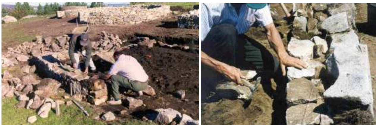
Fotos 127 e 128 – Alinhamento e verticalização dos muros das estruturas.
