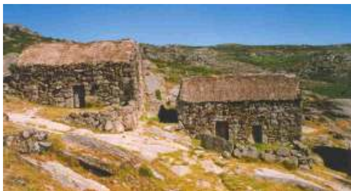
Fotos 100 e 101 - Casas das Brandas de Burzegalinhas, Arcos de Valdevez, e de Santo António de Vale de Poldros, Monção (estrutura de dois pisos, com cobertura em falsa cúpula).
