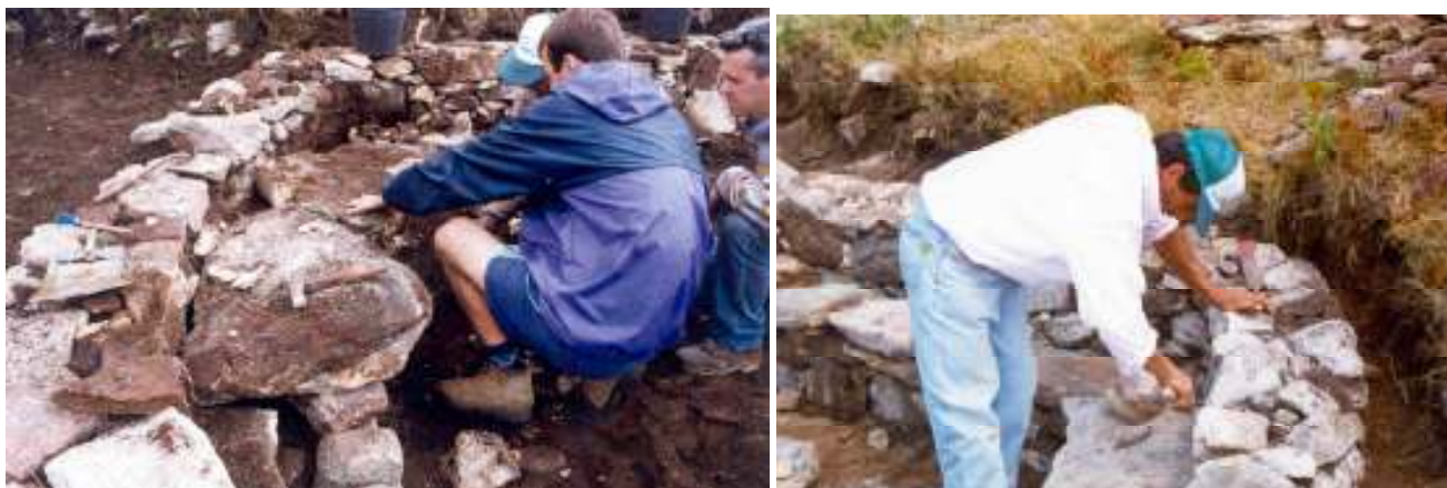
Fotos 130 e 131 – Restauro do banco da cabana 1 do sector A.
