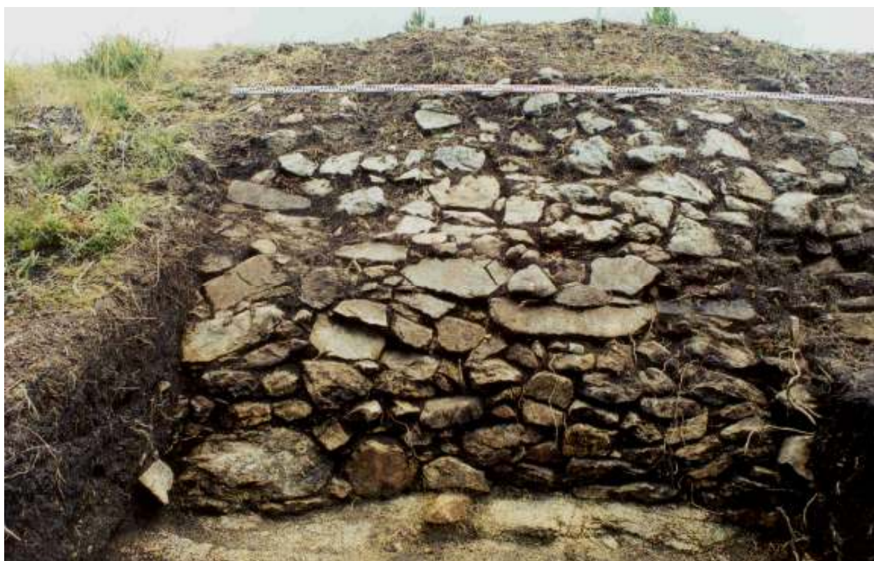
Fotos 71 e 72 – Estrutura construtiva e pormenor da parede externa da muralha.
