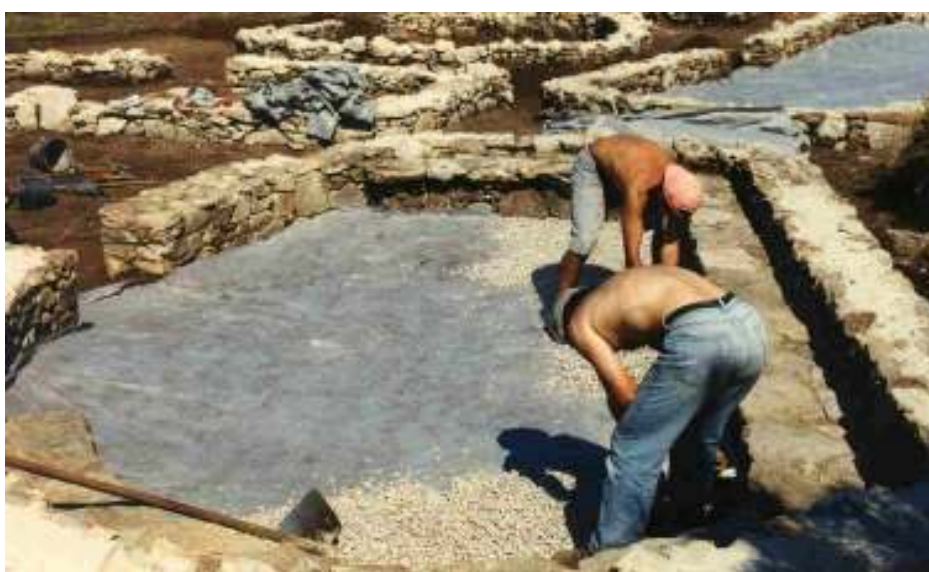
Foto 138 - Colocação da camada de gravilha.
