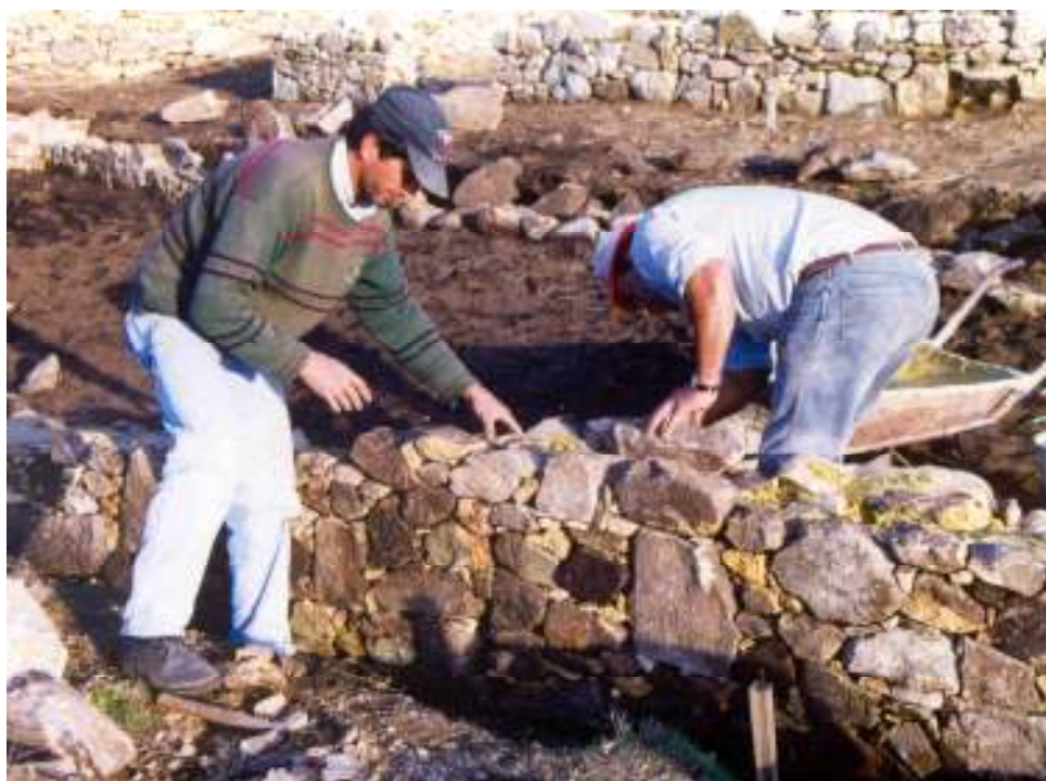
Foto 129 – Consolidação dos muros.
