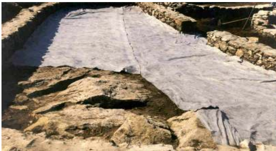
Foto 137 – Colocação da manta geotextil sob o solo nivelado.
