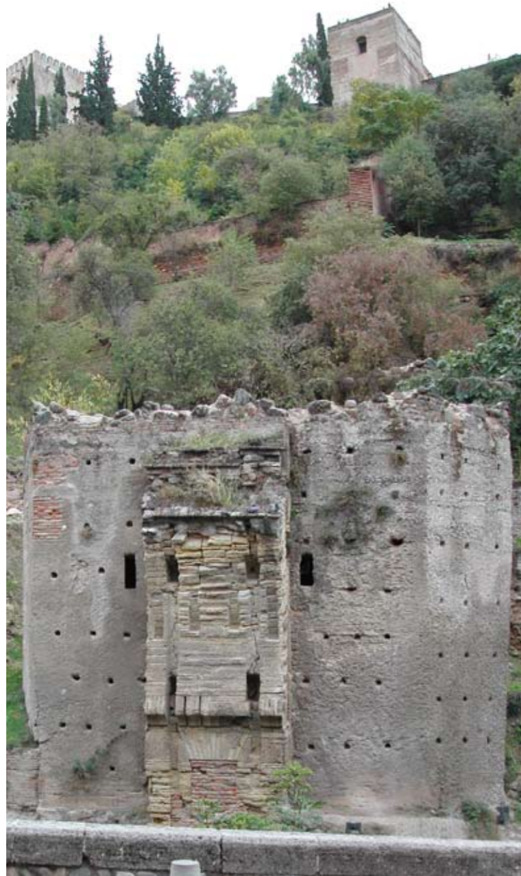
> Fig. C3a. Restos del estribo izquierdo de la Bab al-Difāf (Puerta de los Tableros o de las Compuertas)
