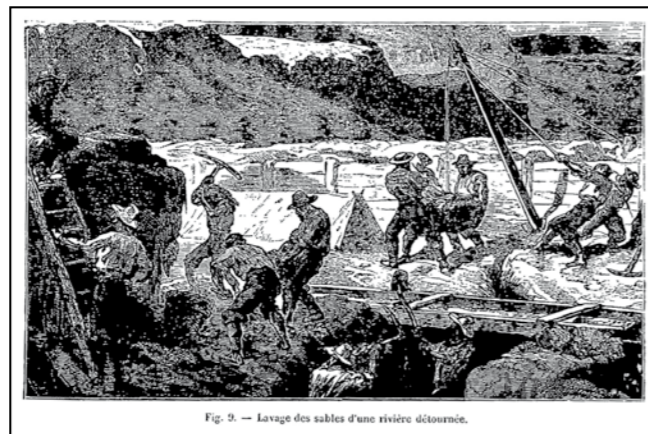
Fig. 9. — Lavage des sables d'une rivière détournée.
