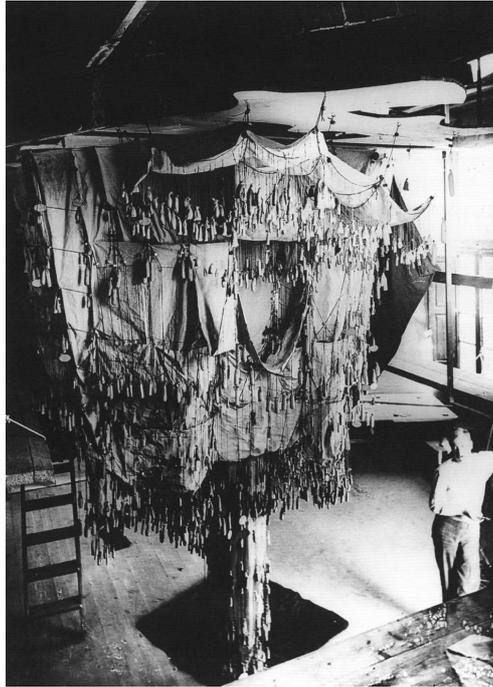
Fig. 1. Antonio Gaudí. Capilla de la Colonia Güell, Barcelona, 1898-1914. Modelo que representa las fuerzas exteriores calculadas sobre la superficie a modo de cargas puntuales repartidas de manera infinitesimal. Gaudí usaba este método no solamente para hacer un modelo estructural sino también para comprobar el acabado estético de la superficie exterior del cierre.
