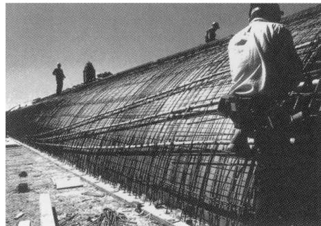
Fig. 45(izq). Secciones constructivas del armado de las bóvedas del Museo Kimbell.
