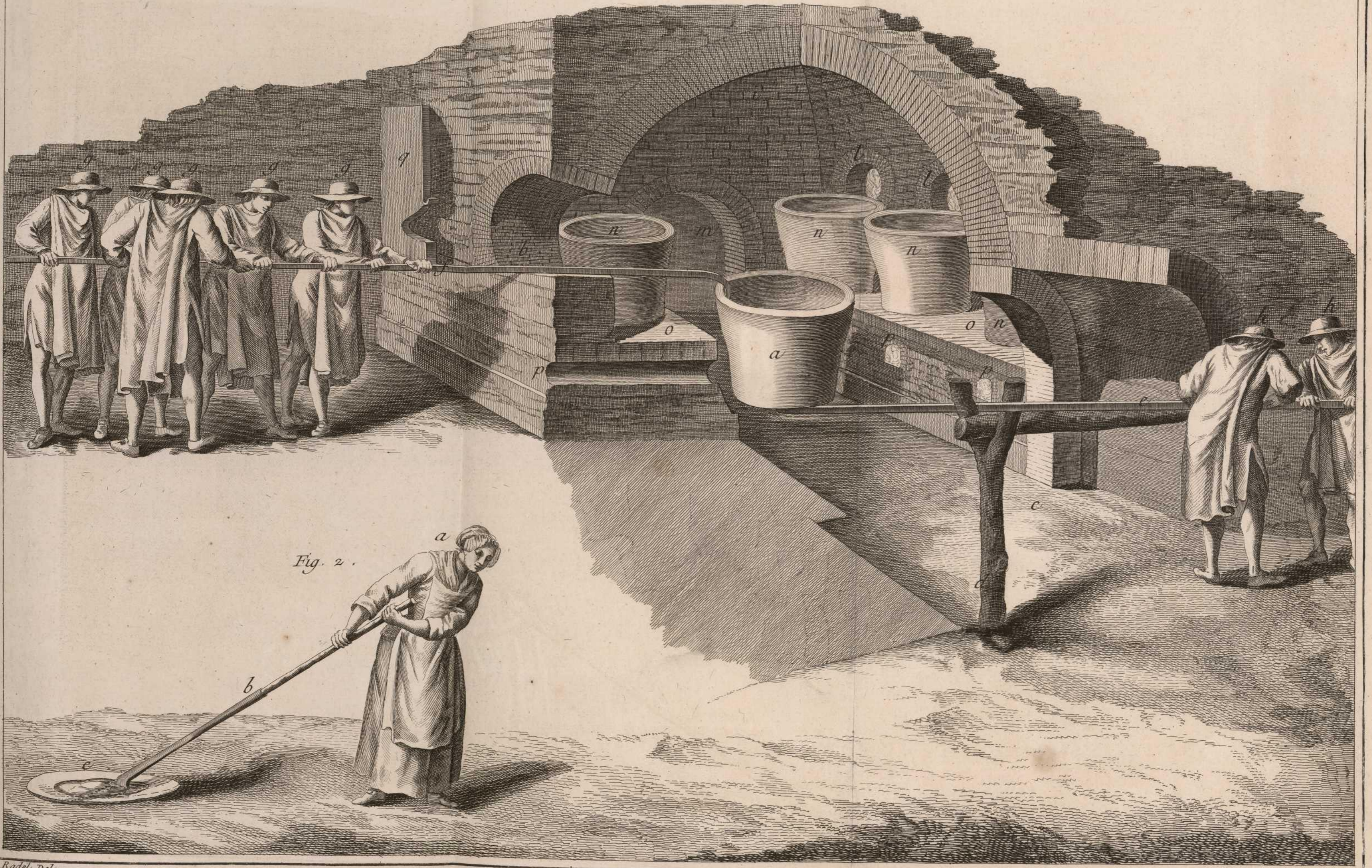
Verrerie en bois, Vue Interieure du Four d'une grande Terrerie en Plats, et l'Operation de mettre le Pot sur le Siege &c.
