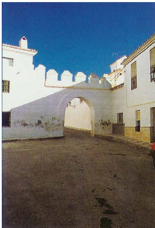
Fotografía nº 17. ARCO DE ENTRADA DEL CASTILLO DE TAJARJA
