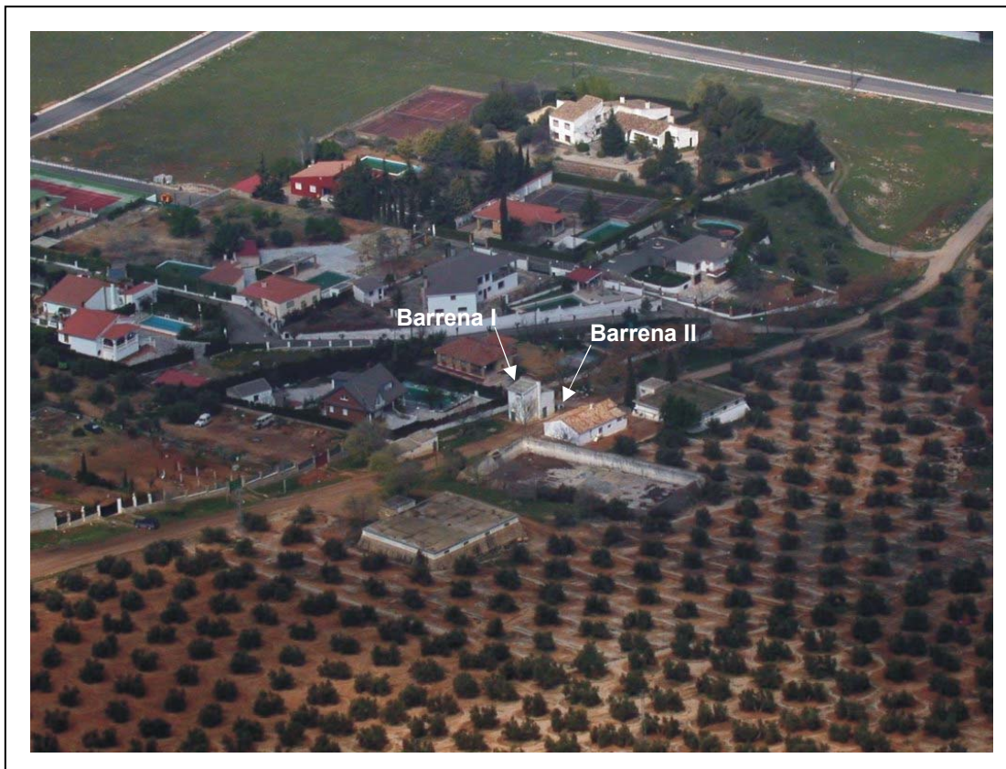
Foto 11. Instalaciones de la Barrena, con el antiguo aljibe del INC y los depósitos de distribución para abastecimiento todavía operativos, pues almacenan el agua procedente del sondeo Peña del Águila.
