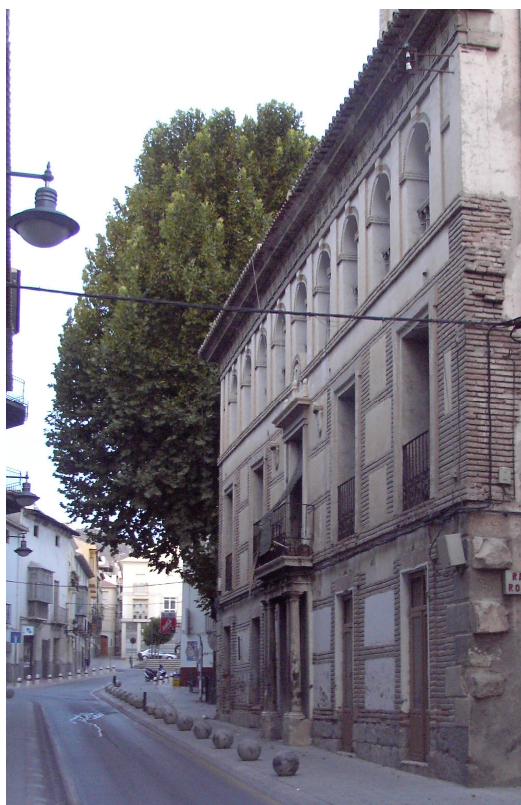
Casa de los marqueses de Cadimo. Fachada principal.
