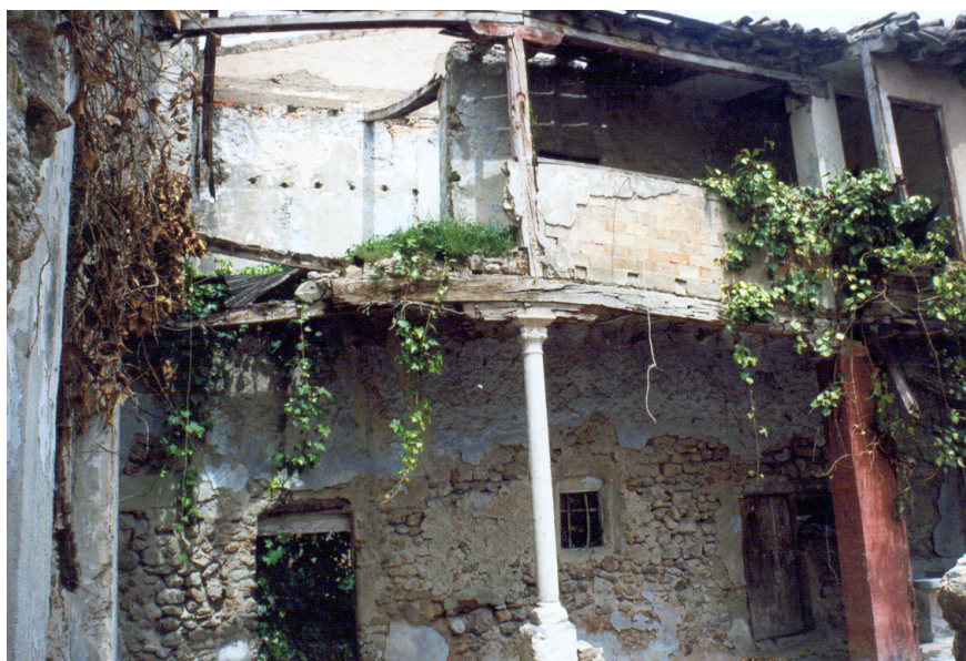
Alhóndiga. Galería del ala norte del patio.
