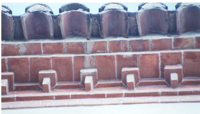
Alhóndiga. Alero fachada principal.
