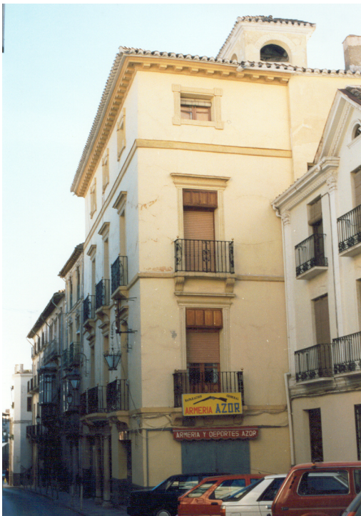
Casa Rodil. Vista general.
