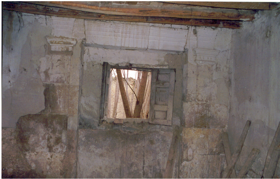
Iglesia de San Jerónimo. Posible puerta de acceso a la sacristía.
