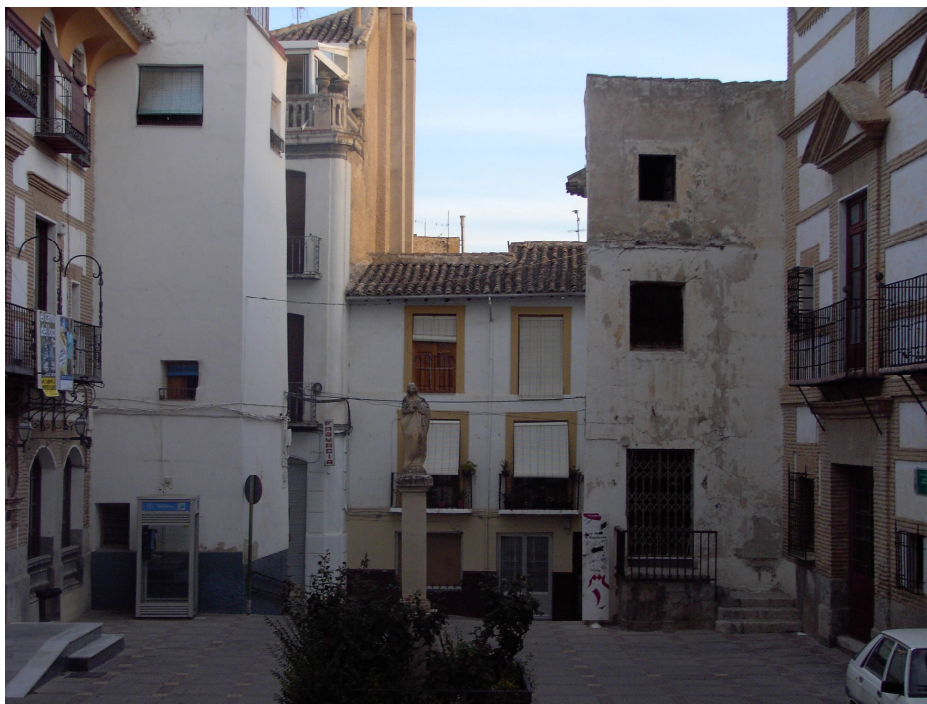
Torreones en los que se apoyaba el arco de la Magdalena.
