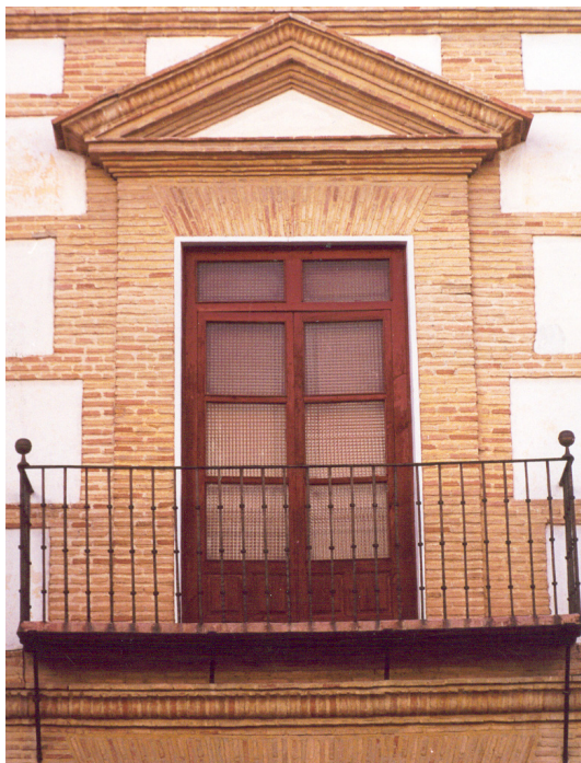
Casa del abad. Fachada principal. Balcón lateral.
