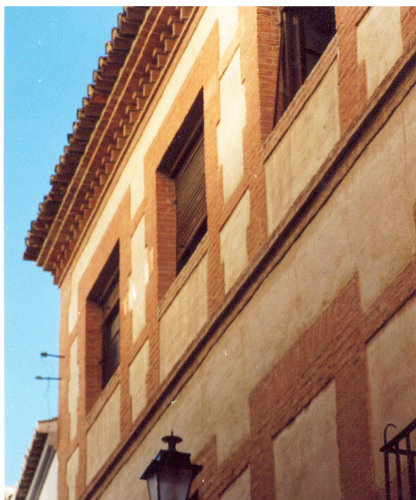
Alhóndiga. Fachada principal. Segunda planta.
