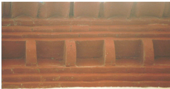
Palacio episcopal. Alero de la fachada norte y trasera.
