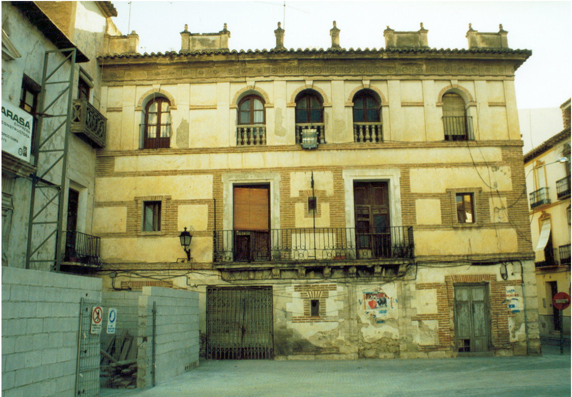
Casa de los marqueses de Cadimo. Fachada de poniente.
