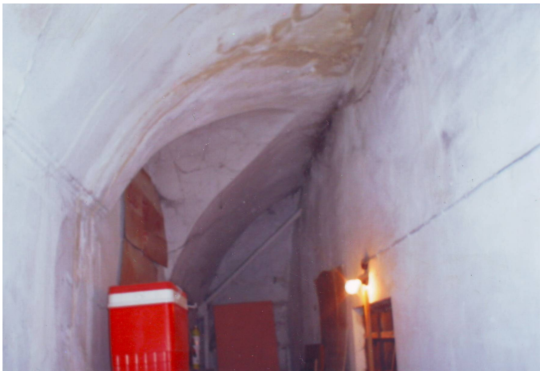
Casa de José Sánchez Morales. Parte de la bóveda escarzana del patio.
