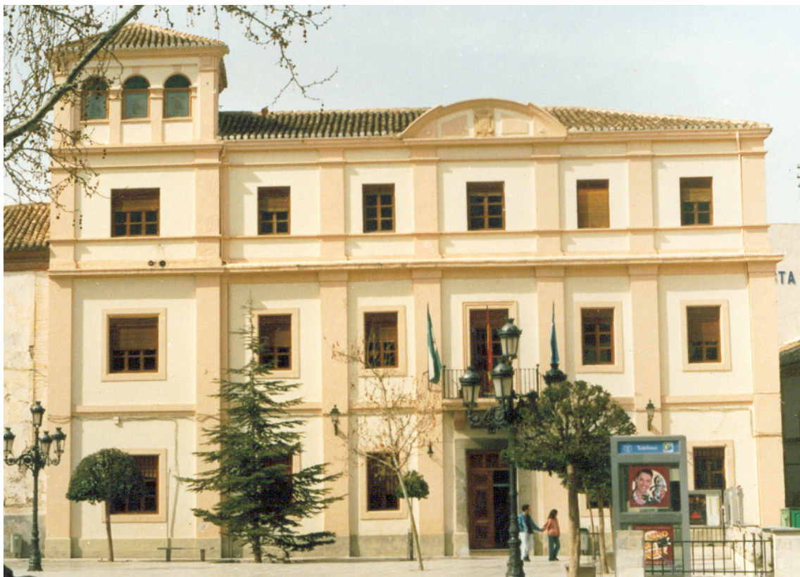
Cárcel. Fachada principal tras las reformas.
