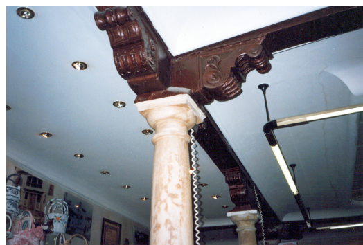
Casa nº 3 de la calle de la Cabeza. Patio cegado.
