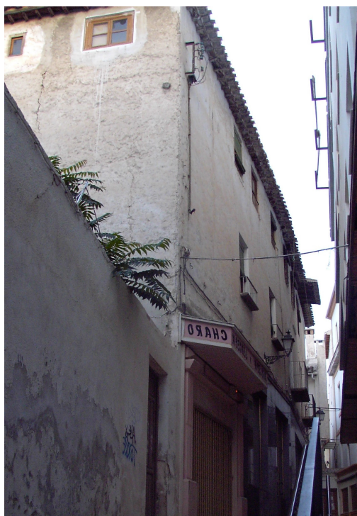
Casa de José Sánchez Morales. Fachada sur.
