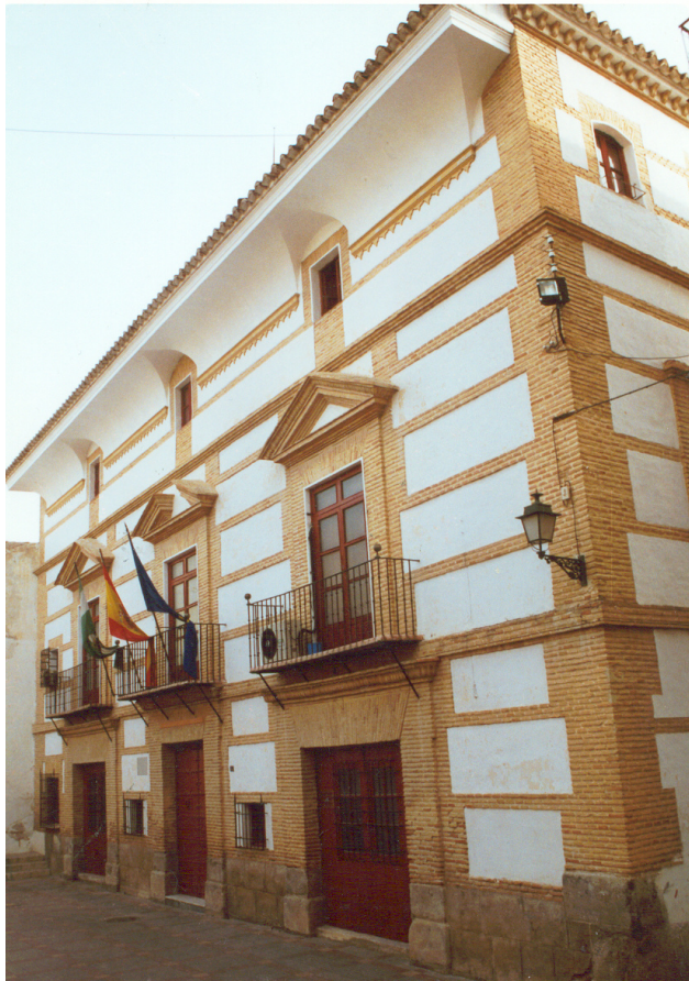
Casa del abad. Fachada principal.
