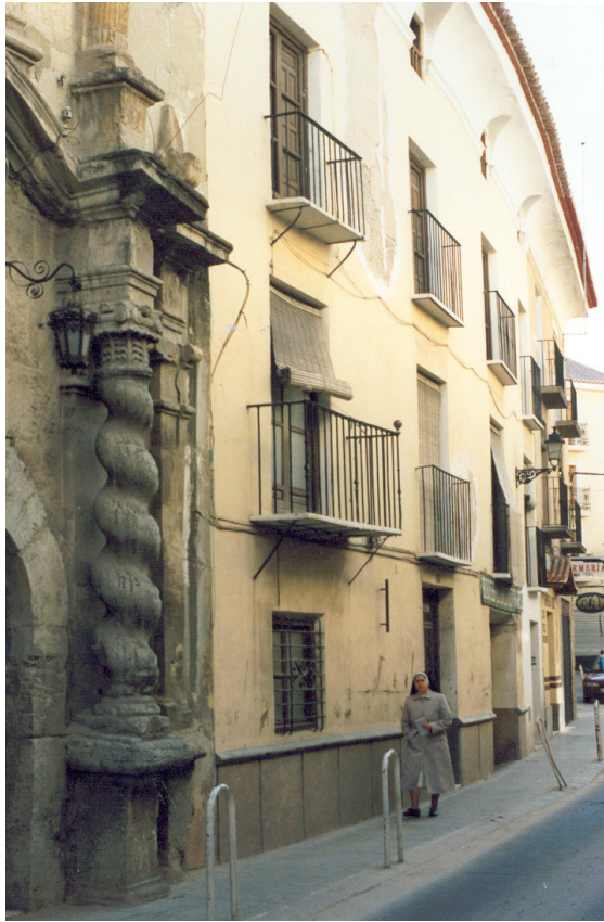
Palacio episcopal. Flanco norte de la fachada principal.
