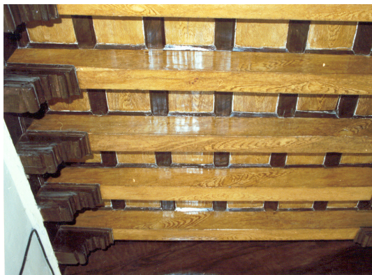
Casa nº 12 de la calle Alamillos (?).
