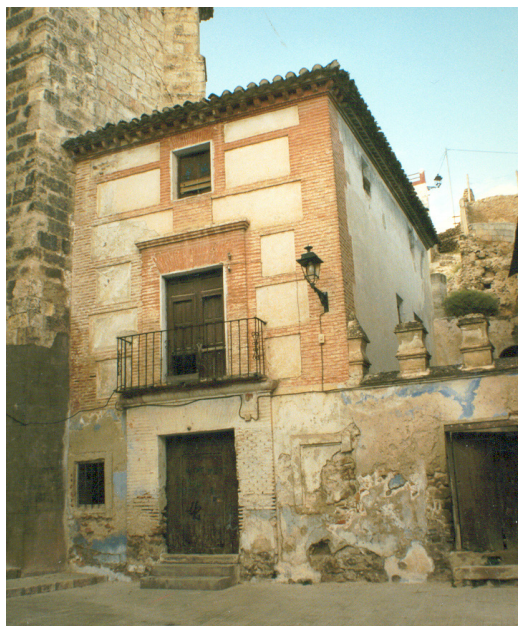
Casa del campanero levantada en la década de los sesenta de la que se tomó la idea compositiva y de materiales.
