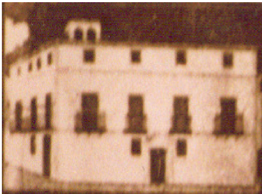
Casa del Señor de Castril. Fachada principal (1849). A.E.C. Foto de uno de los dibujos realizados por Ramón Díaz Cruz en 1849.
