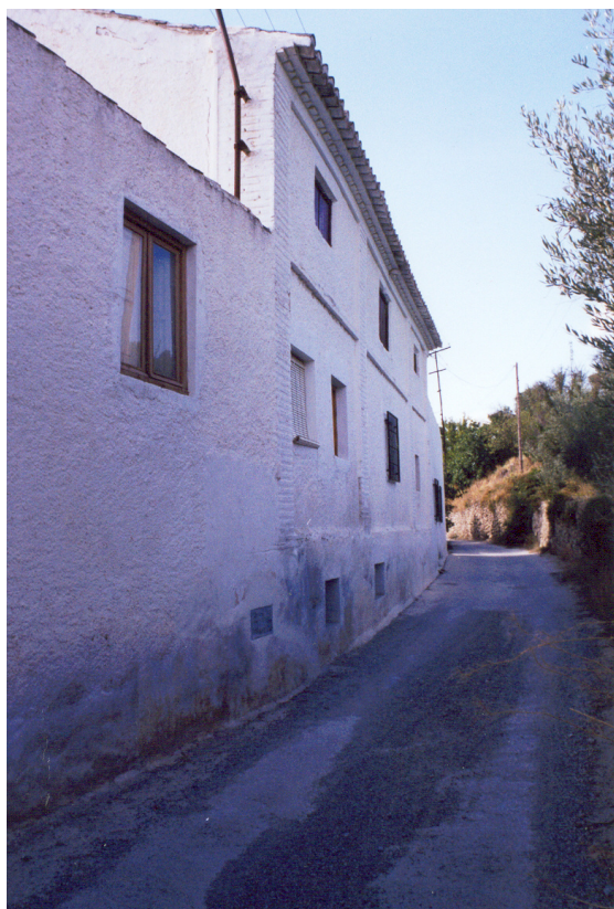
Casa de Baños de Zamora.
