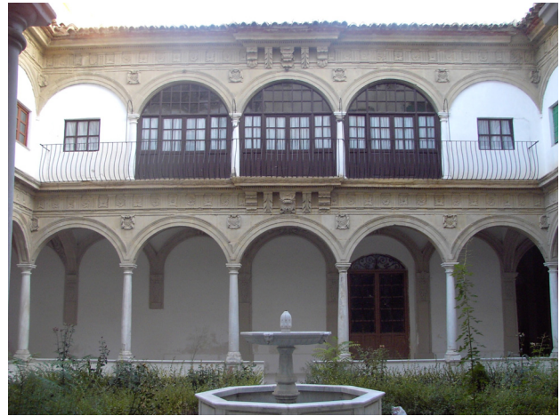
Convento de Santo Domingo. Claustro.
