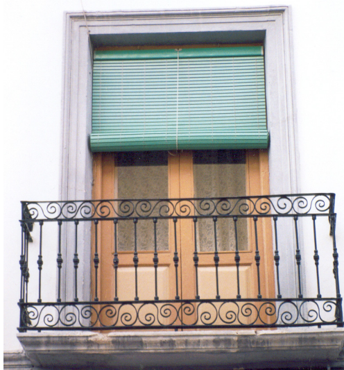
Balcón de la fachada principal.
