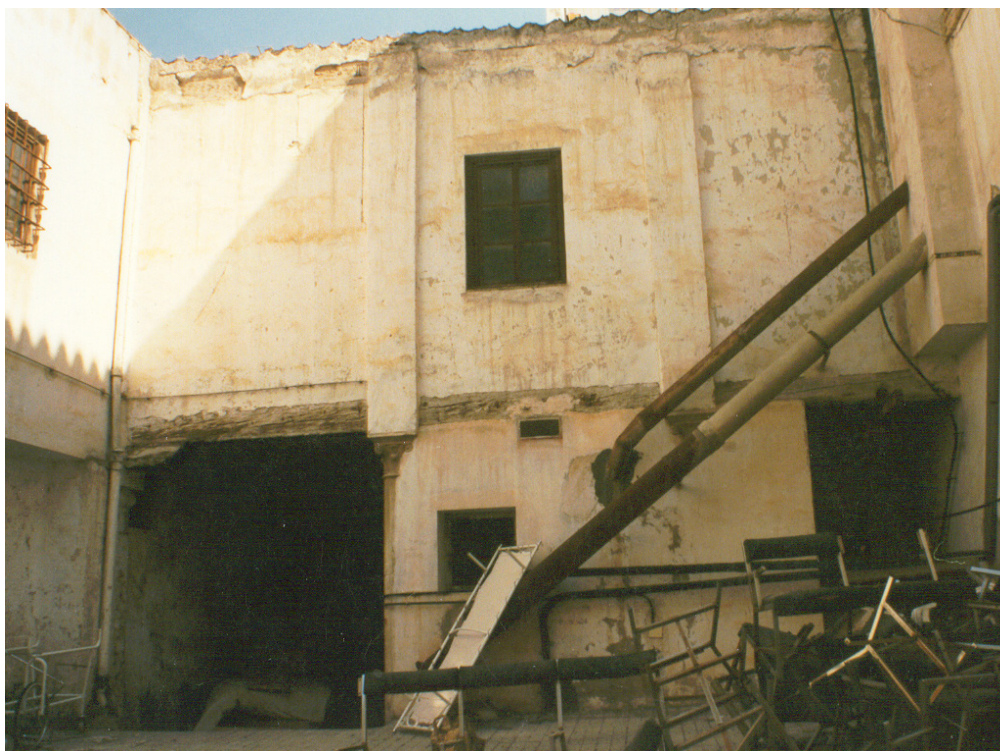
Casa accesoria del abad. Fachada al jardín.
