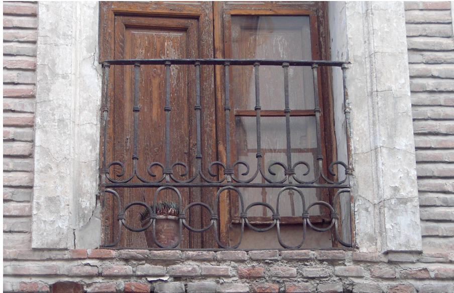
Casa de los marqueses de Cadimo. Barandilla de un antepecho de la fachada principal.
