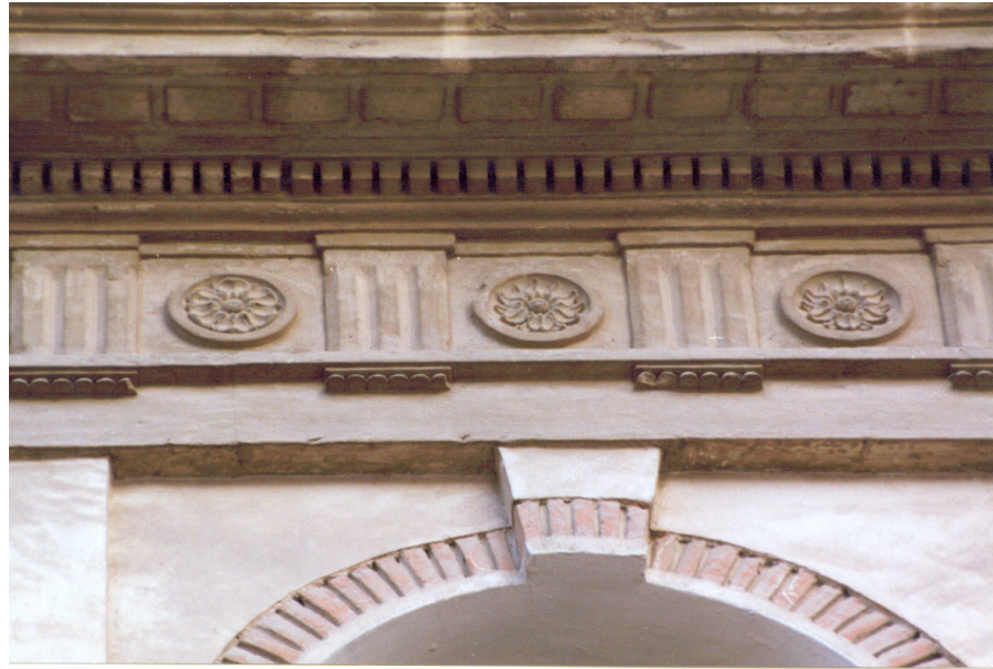
Casa de los marqueses de Cadimo. Entablamento que corona la fachada principal.
