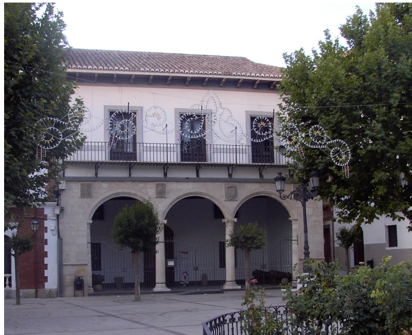
Casas del Cabildo. Fachada principal.
