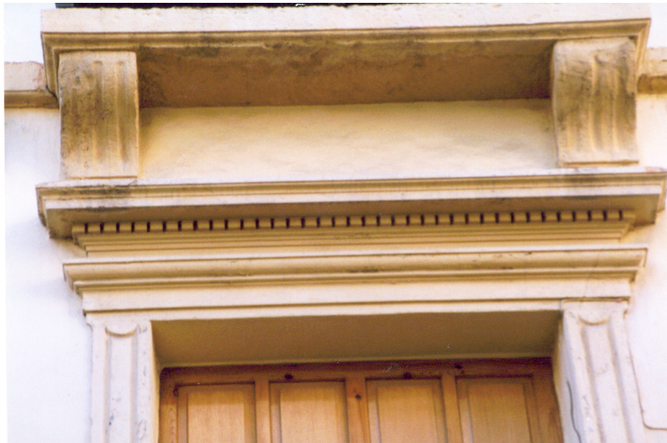
Casa Rodil. Pilastras y entablamento dórico coronando los balcones.
