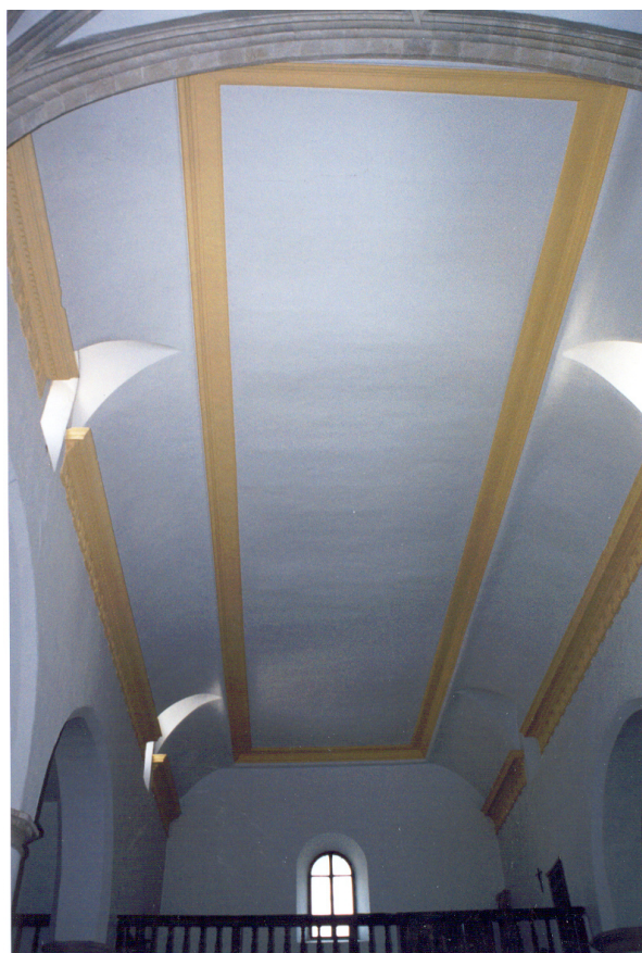
Iglesia de San Juan. Cubierta de la nave central.
