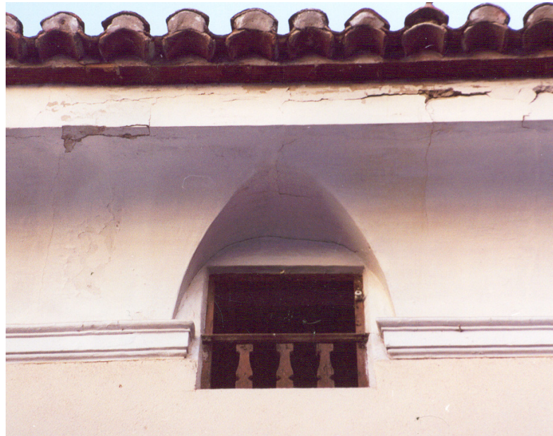
Palacio episcopal. Detalle de la cornisa de la fachada principal.
