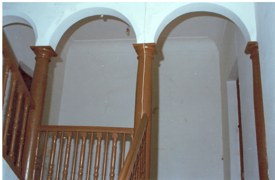
Casa de los marqueses de Cadimo. Escalera. Acceso a la primera planta.
