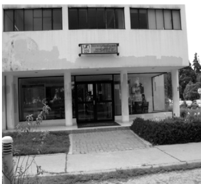
Imagen N° 5. Departamento de lenguas extranjeras, edificio 229.
