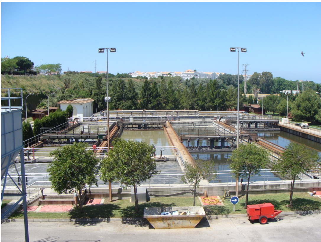
Figura 39. Reactor biológico de doble etapa de Sanlúcar de Barrameda.
