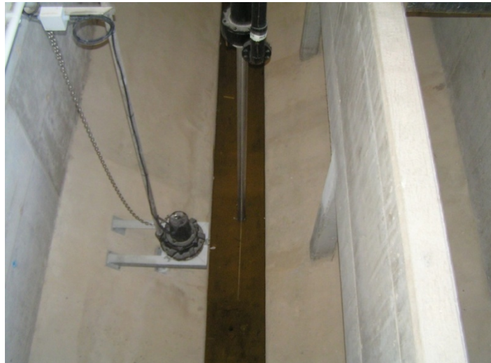
Figura 45. Vista del desarenador-desengrasador del pretratamiento.
