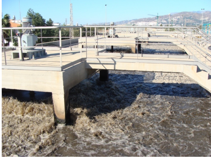
Figura 18. Reactor biológico con aireadores superficiales de la depuradora de Motril.
