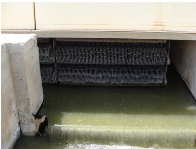
Figura 29. Biodiscos del reactor biológico de la planta de Palomares.
