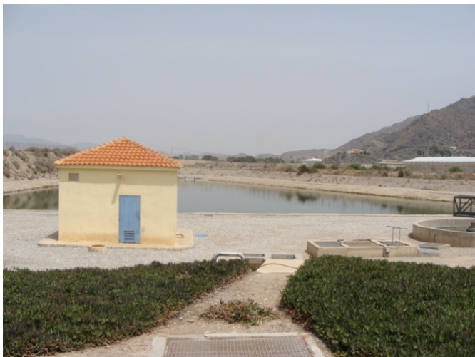
Figura 32. Laguna anaerobia de salida de la instalación de Palomares.
