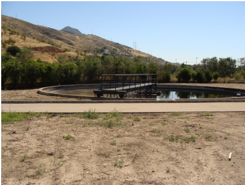
Figura 43. Vista del decantador secundario de la planta de Loja.
