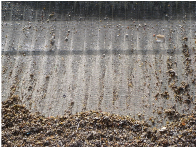
Figura 27. Tamiz de agua de llegada de la planta de Palomares.
