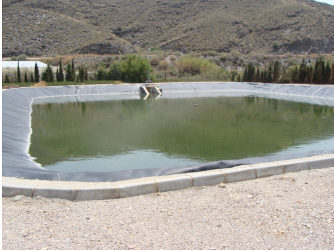
Figura 28. Laguna anaerobia previa a los biodiscos de la planta de Palomares.
