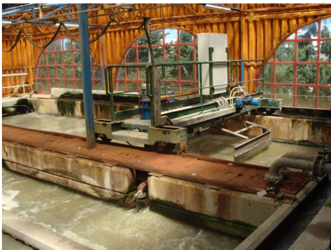
Figura 38. Vista del desarenador-desengrasador
