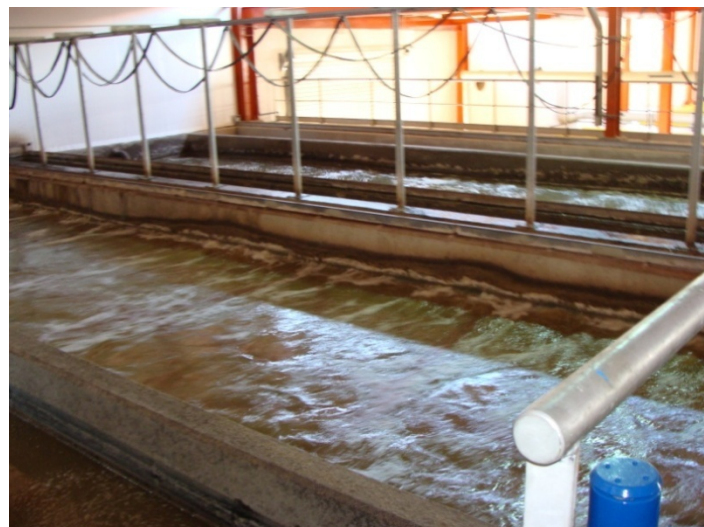
Figura 60. Vista del desarenador desengrasador del pretratamiento.
