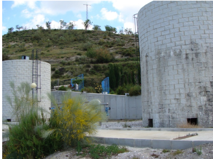
Figura 22. Vista de los dos reactores de lechos bacterianos instalados.
