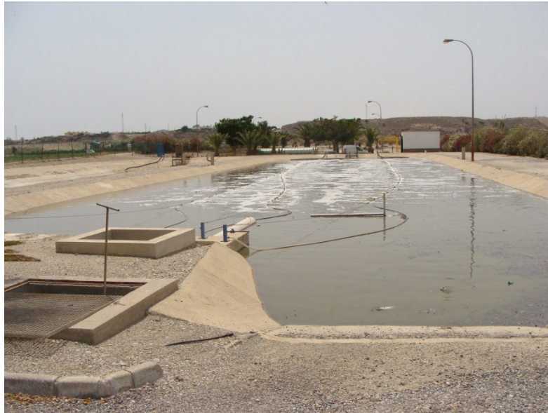
Figura 55. Laguna previa a los biodiscos de la planta de Cuevas.
