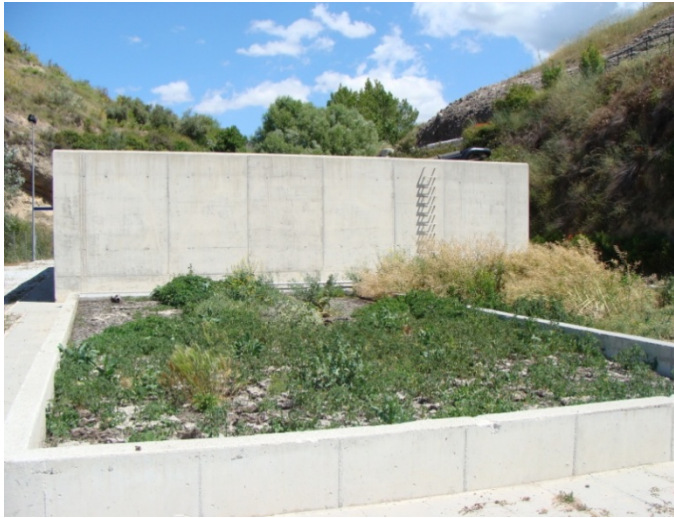
Figura 53. Vista de las eras de secado de la planta de Huétor Santillán.
