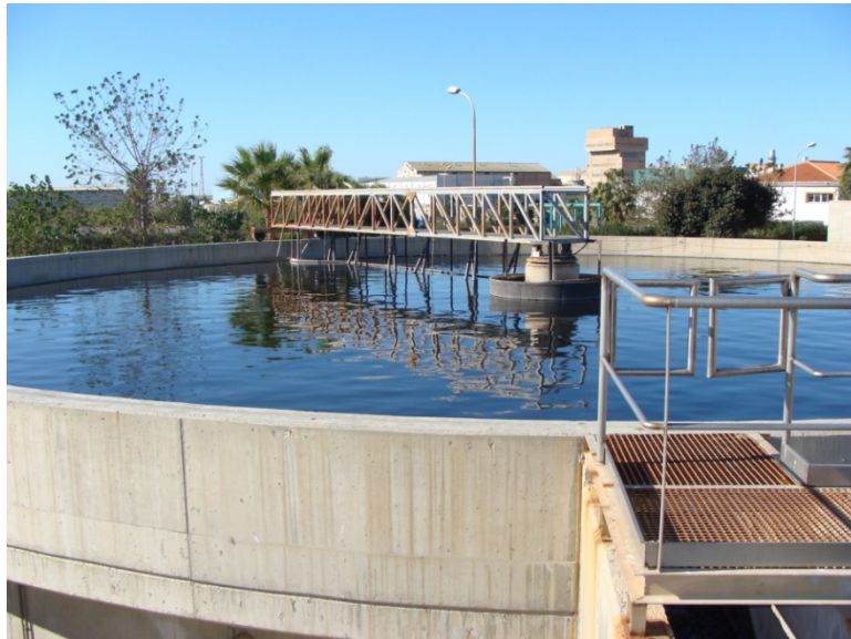
Figura 17. Decantador primario de la instalación.
