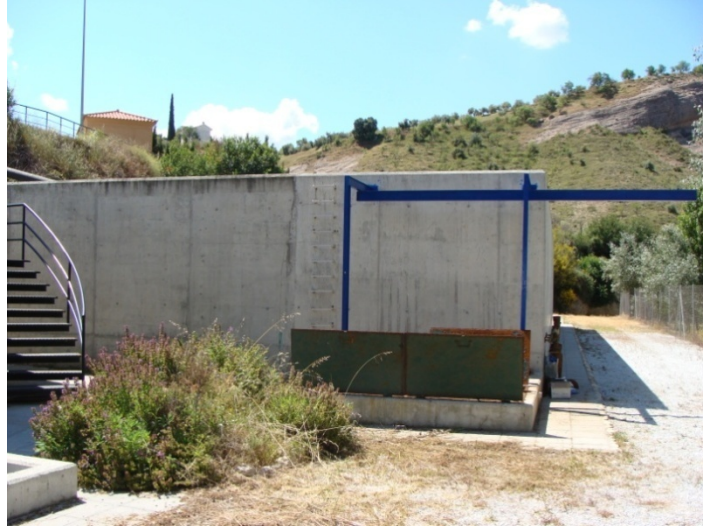
Figura 49. Vista de la laguna anaerobia de la planta de Huétor Santillán.
