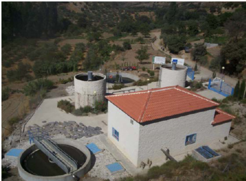
Figura 20. Vista general de la depuradora de Beas de Granada.
