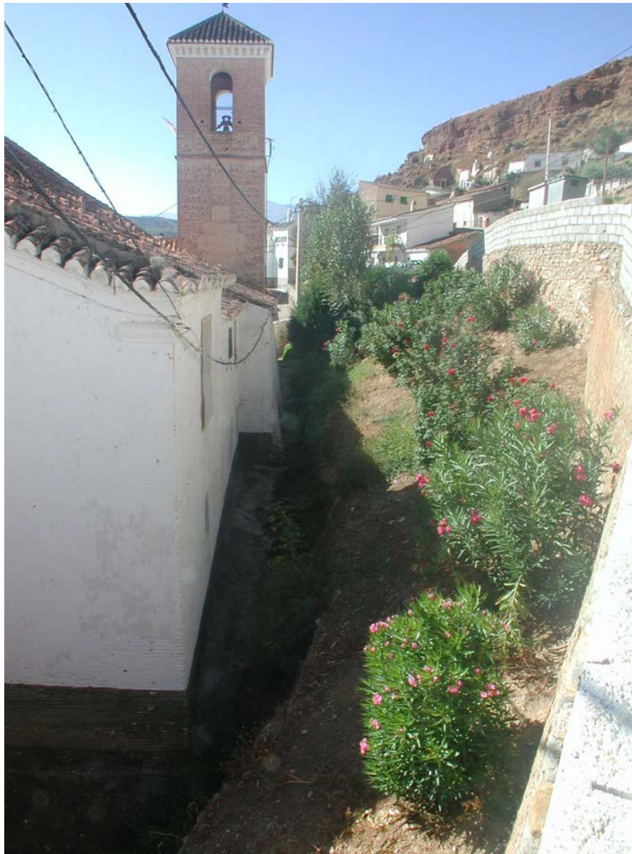
Exterior del lateral correspondiente al lado del evangelio.
