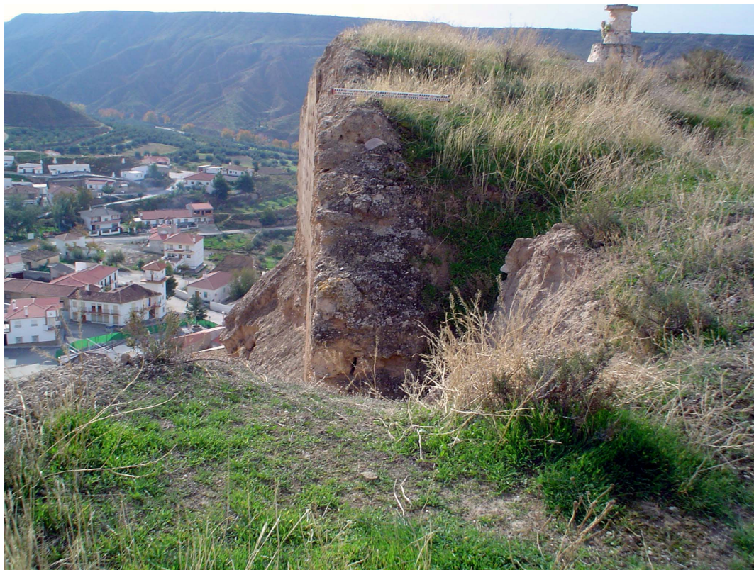
Figura 6. Castillo de Gorafe, recinto interior, lienzo 1 SE en cara N.
