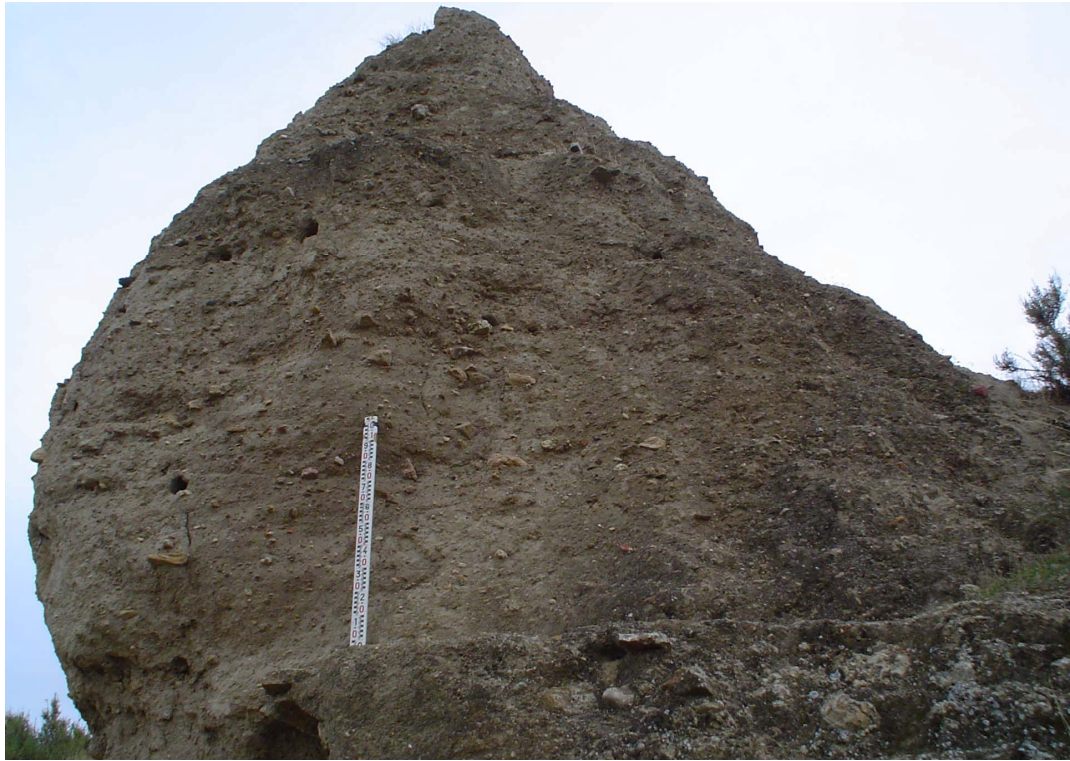
Figura 1. Castillo de Guadix el Viejo, Recinto exterior, Torre 3 en su cara N. Construido en tapial de tierra.
