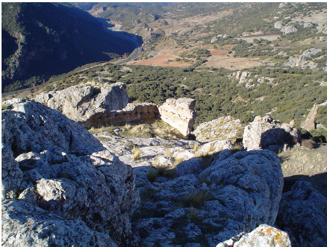
Figura 15. Vista general de la muralla superior.
