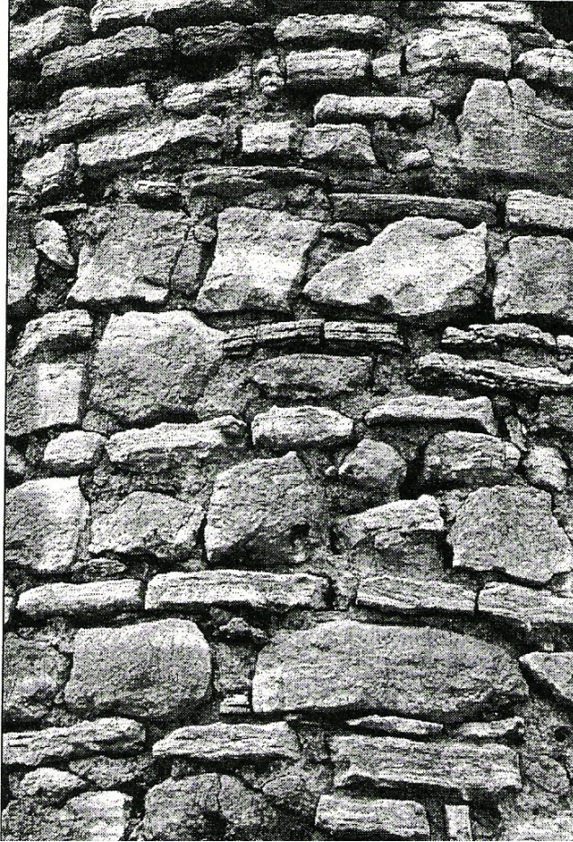
Figura 13. Aparejo de mampostería enripiada.
