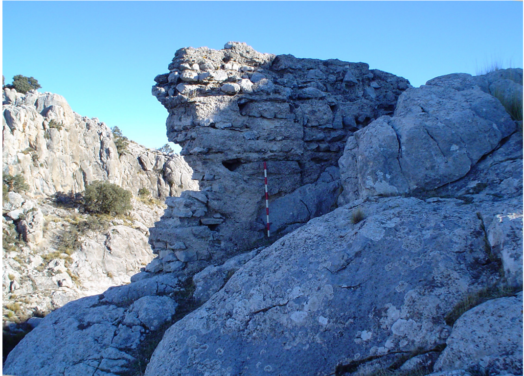
Figura 13. El muro N de la muralla superior en su cara S.
