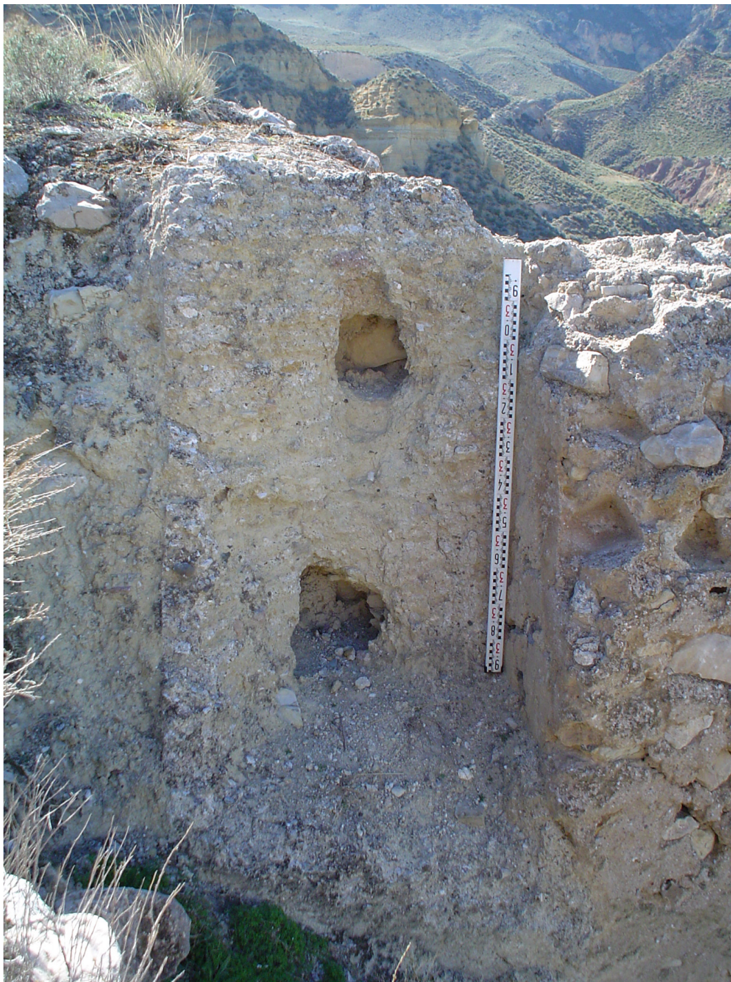
Figura 14. La puerta muro tapial 3 con muro mampostería 3 en la cara S.
