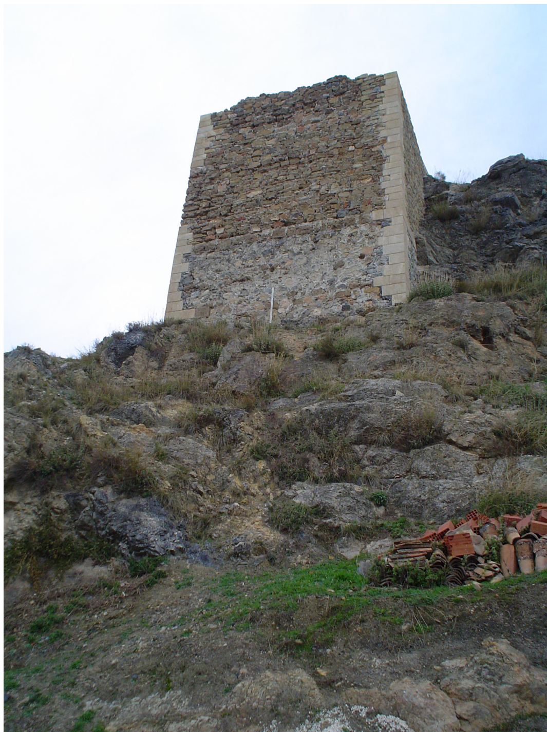
Figura 13. Torre SO en su cara S.
