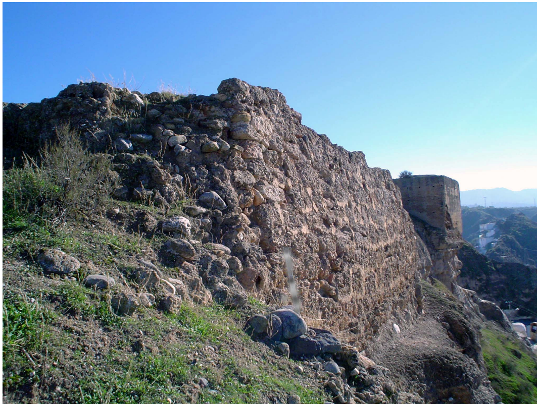
Figura 11. Torre NO y Lienzo O en el ángulo NO del Castillo.
