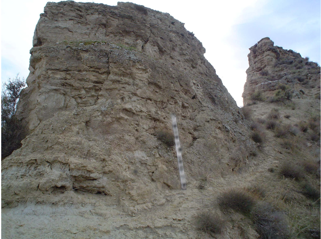
Figura 12. Castillo de Guadix el Viejo, torre 6 del recinto exterior en su cara N.
