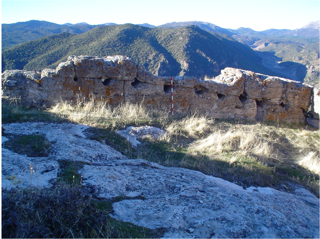
Figura 10. El muro S de la muralla superior en su cara N.
