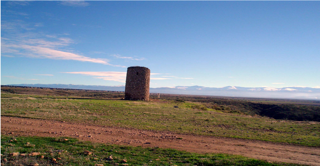
Figura 7. Vista general de la Torre del Guájar.
