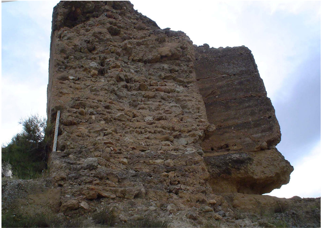
Figura 19. Castillo de Guadix el Viejo, torre 2 del recinto exterior en su cara N.
