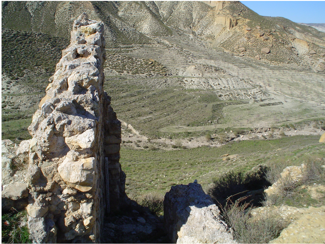
Figura 6. El pasillo de la puerta con muro mampostería 7 en la cara O.
