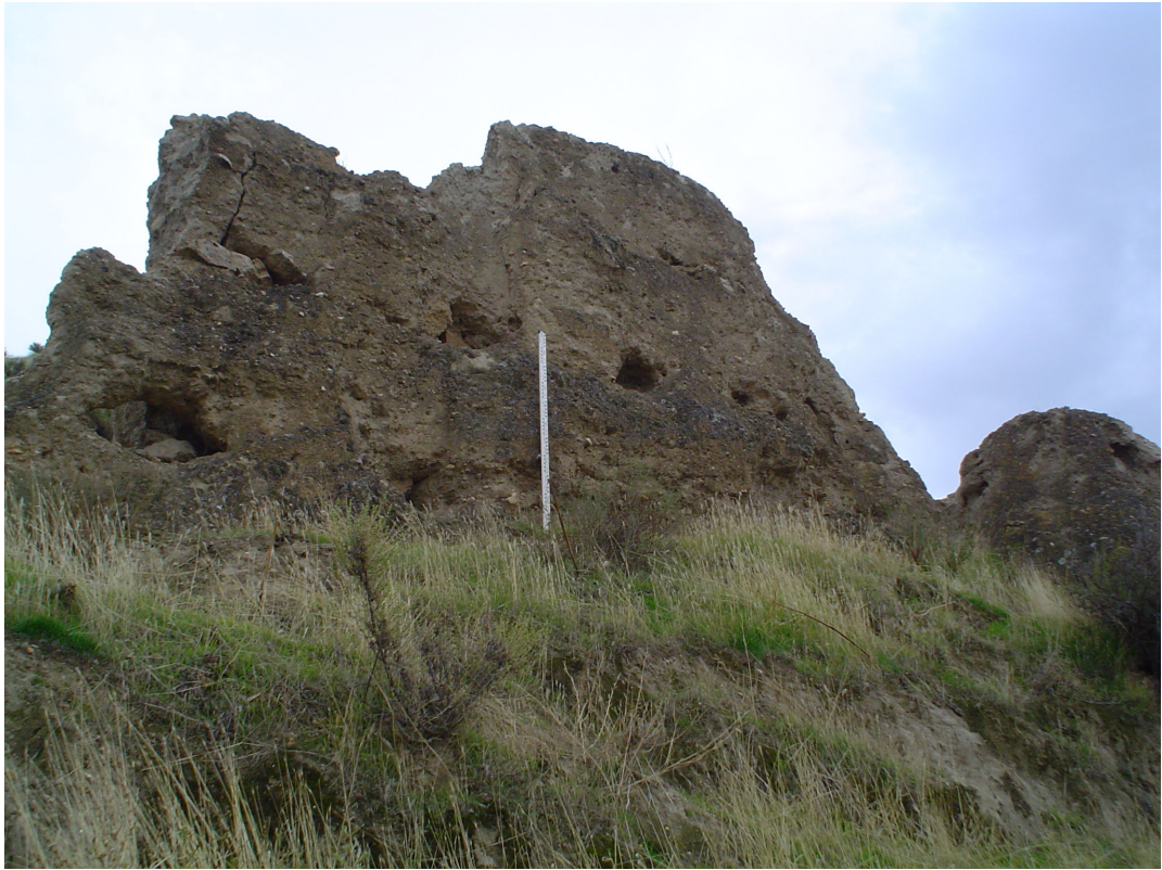
Figura 9. Castillo de Guadix el viejo, muro 2 del recinto exterior en su cara N.
