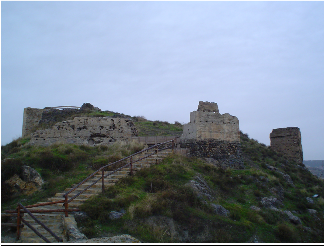
Figura 4. vista general del castillo de La Peza en lado E.
