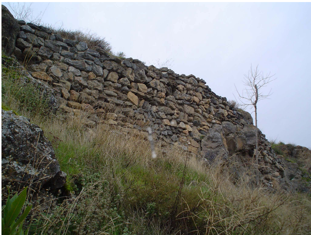
Figura 14. Muro N del recinto exterior en su cara N.
