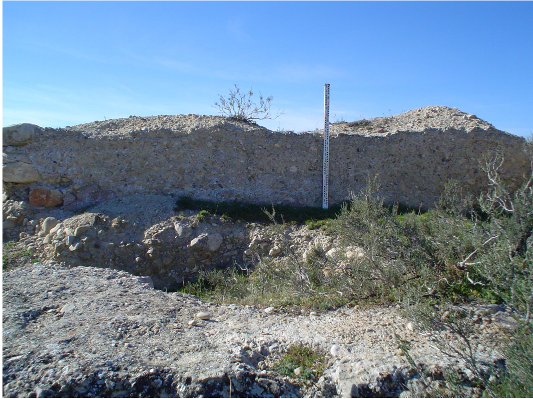
Figura 2. Castillo de Don Cristóbal, Aljibe, Muro S en su cara N. Construido en tapial de hormigón.
