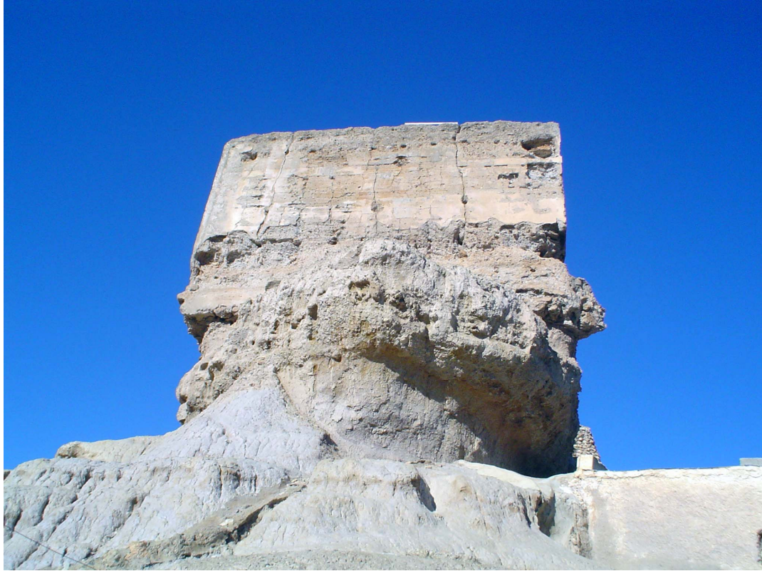
Figura 5. Castillo de Bacor, Torre S en su cara N. Construido en tapial calicastro.
