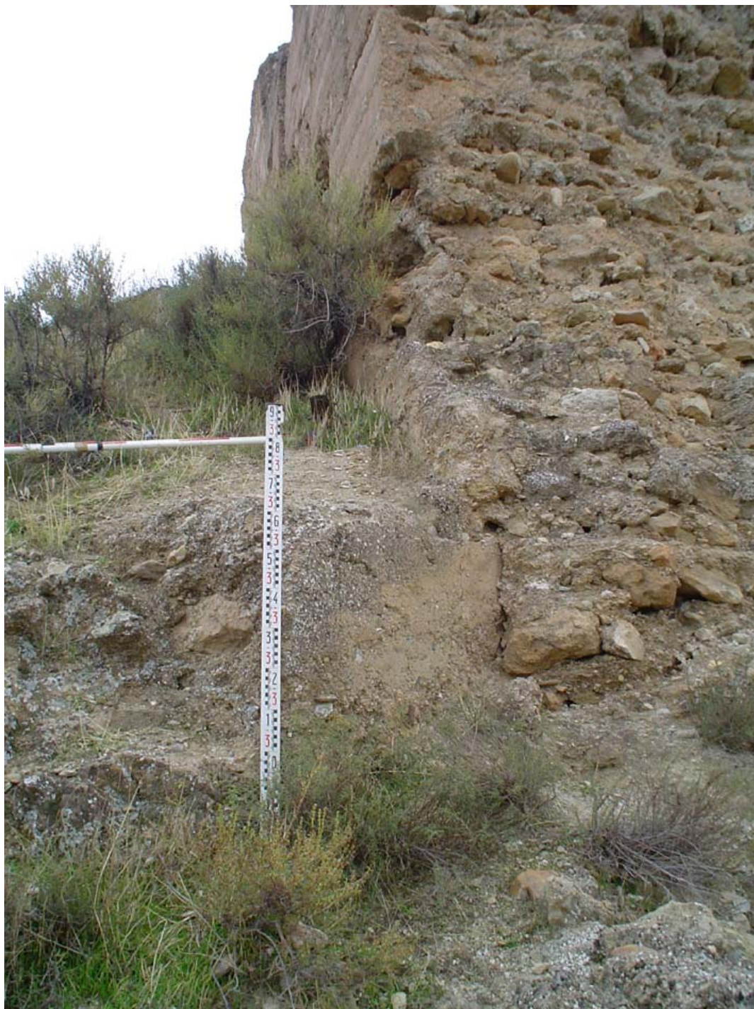
Figura 22. Castillo de Guadix el Viejo, muro 1 del recinto exterior en su cara N.
