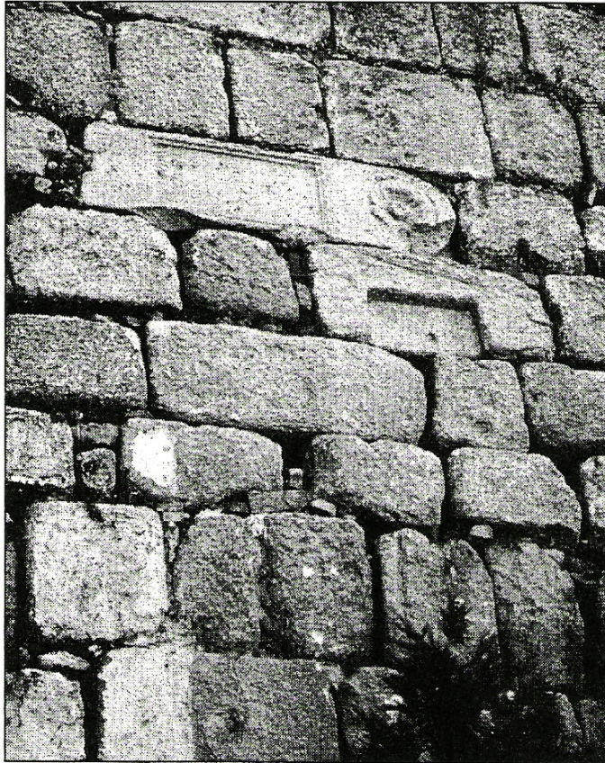
Figura 11. Restos constructivos de la Alcazaba de Mérida, en donde se observa el aparejo en sillares de época emiral, con aprovechamiento de piezas romanas.
