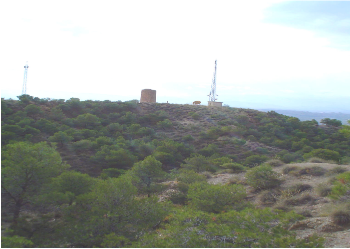
Figura 11. Vista general de la Torrecilla de Baza o del Monje.
