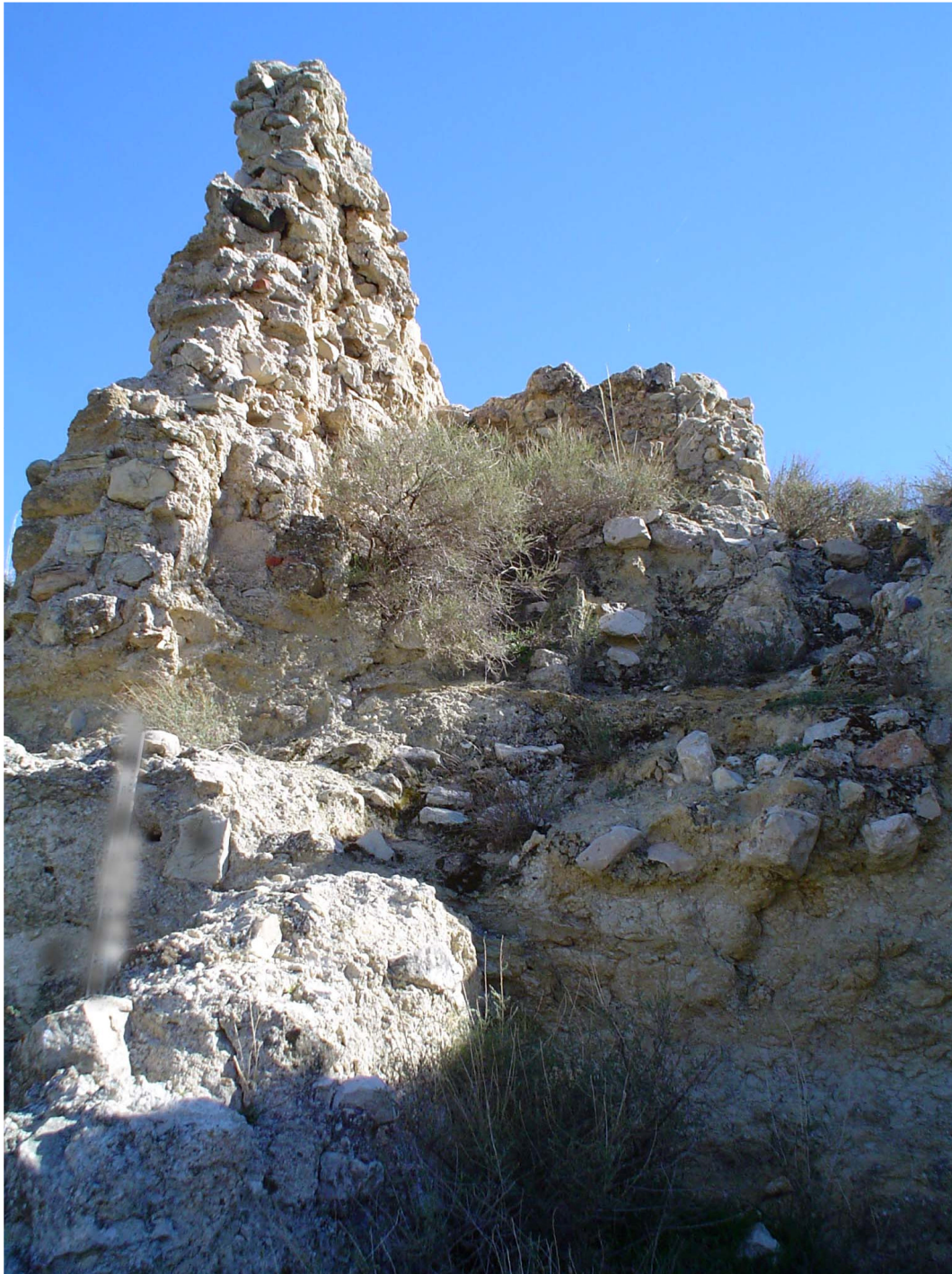
Figura 12. La puerta muro tapial 1 con muro tapial 2 en la cara O.
