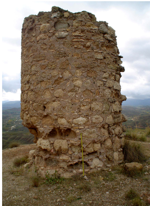
Figura 15. Vista general de la Torre de Magrú o Cullar.
