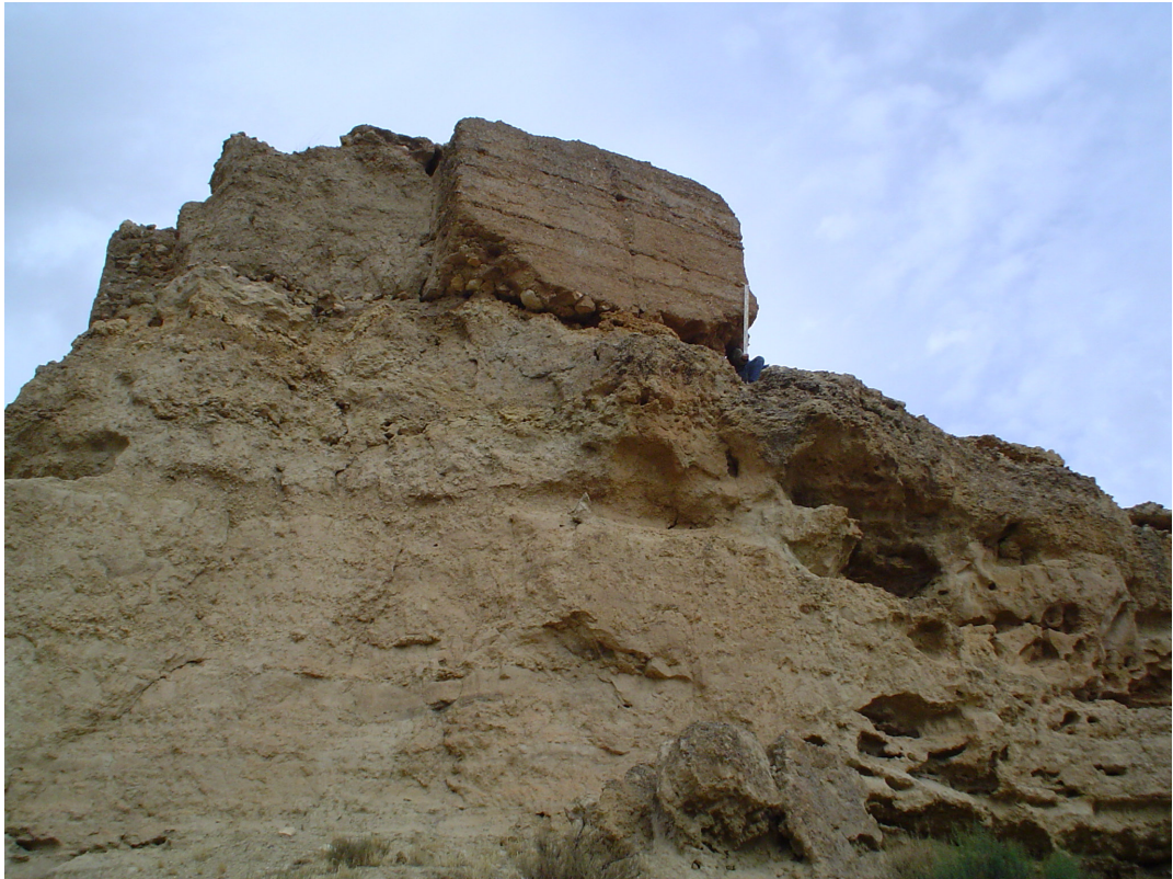
Figura 17. Castillo de Guadix el Viejo, torre 1 del recinto exterior en su cara S.
