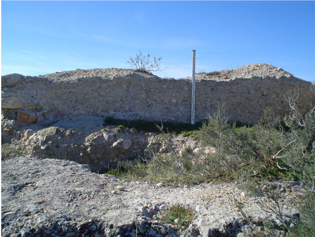
Figura 6. Aljibe desde la cara N de su muro S.
