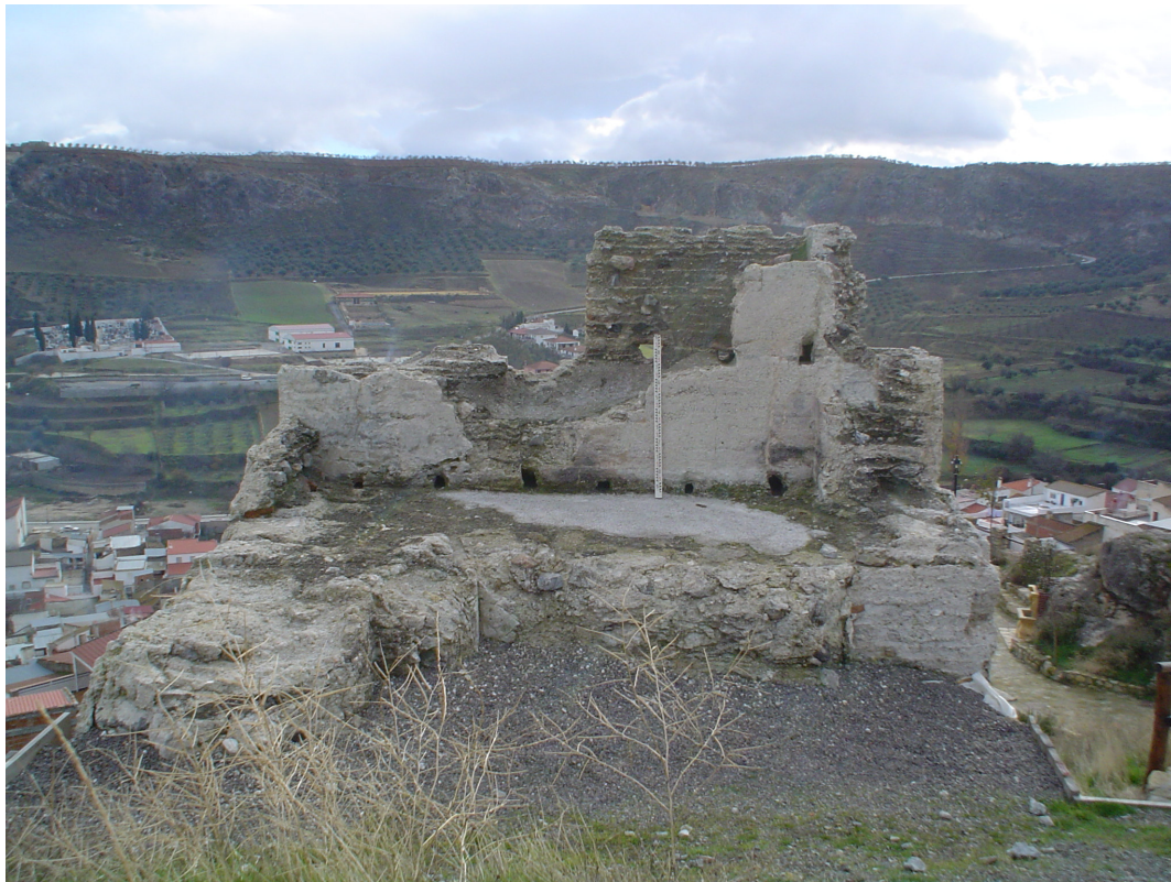
Figura 9. Torre E en cara interior
