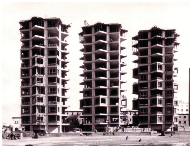
Figura 7. Imagen, todavía en construcción, de las Tres Torres del Star Building , año 1974. (Fuente: María del Mar Samper).
