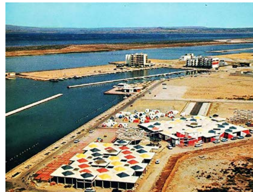
figura 8 Cluster de viviendas Hexacube . Vista general: conjunto de prototipos construidos en Port-Leucate 1972, junto a edificios modulares públicos. “Leucate lève le voile sur son design”, L’Indépendant: David Liaudet.
