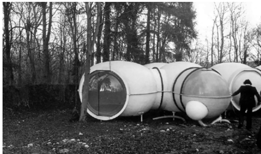
figura 4 Domobiles de Pascal Häusermann. Prototipos de “vivienda evolutiva” construida, tras desplazar los módulos con coches particulares. Colección FRAC-Centre.
